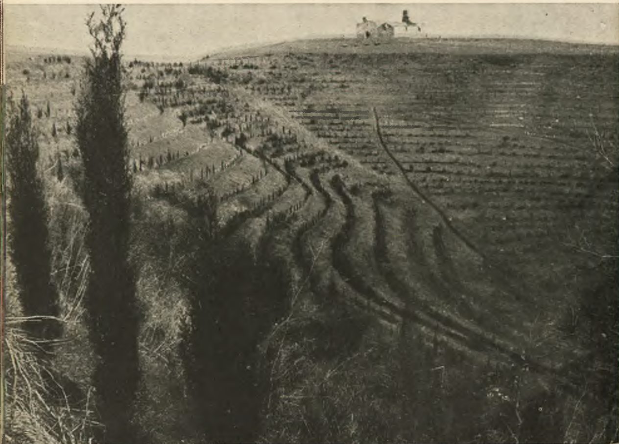
Fot. 16 - Matera - BM Bradano, sottobacino Rifeccia : Lavori di sistemazione idraulico-forestale.
