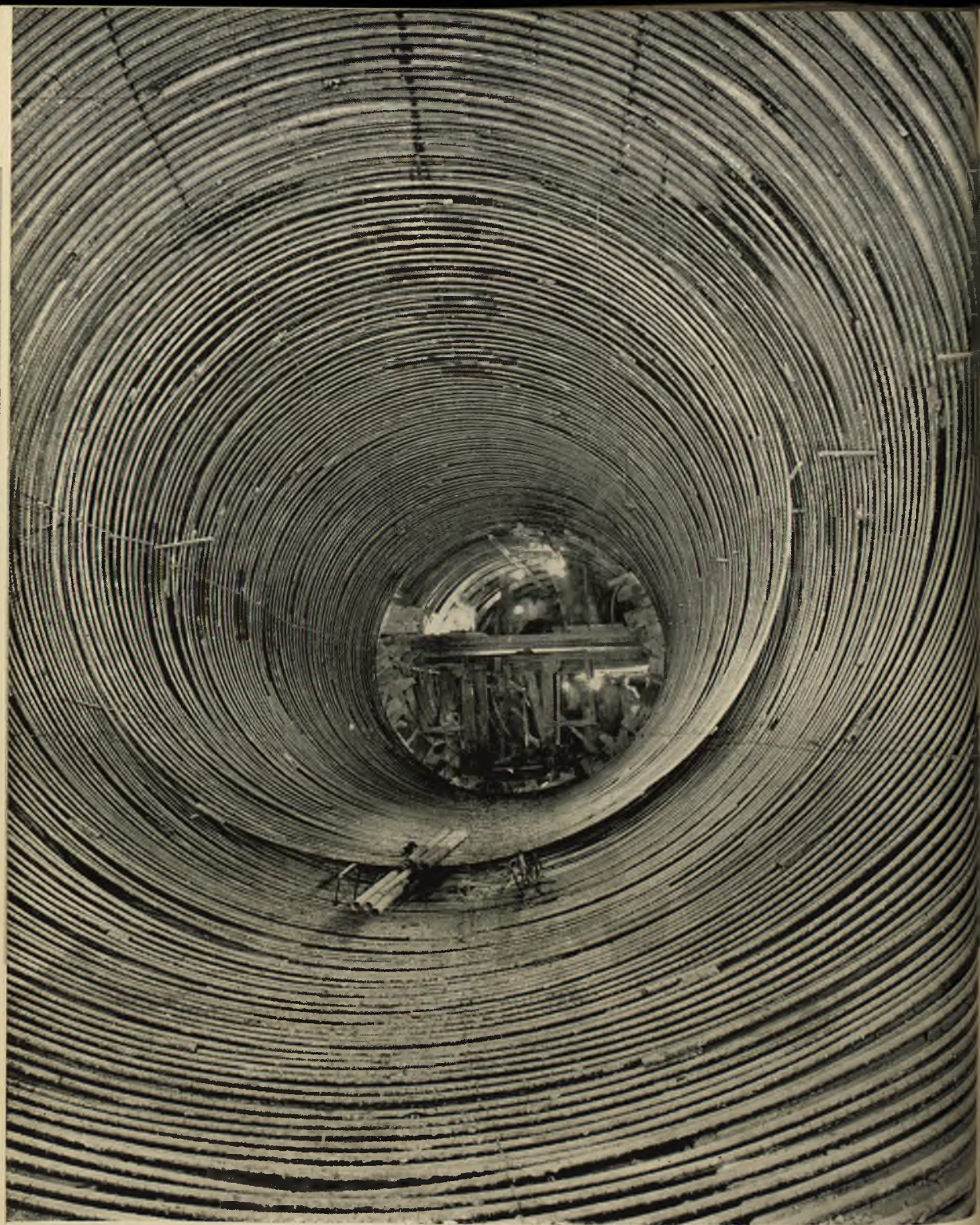
Fot. 49 - Sbarramento di Pietra del Pertusillo sul fiume Agri (Lucania): Armatura galleria scarico di fondo.
