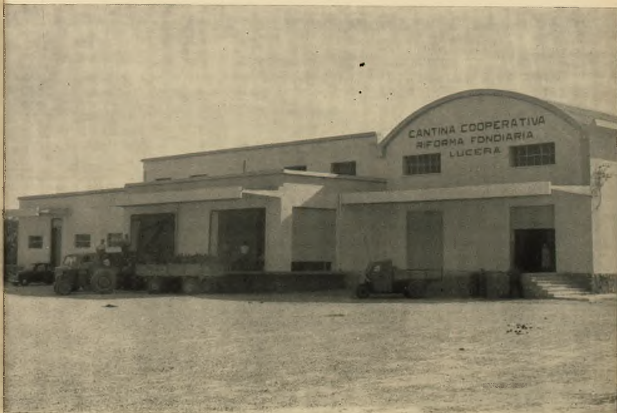
Fot. 5 - Cantina di Lucera (Foggia): Prospetto e lato distribuzione.
