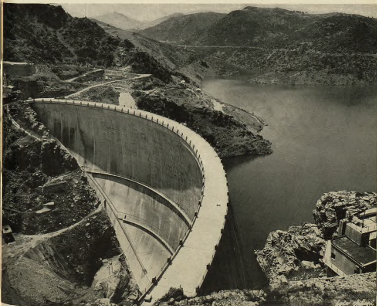
Fot. 8 - Serbatoio di Monte Su Rei sul Rio Mulargia (Sardegna): La diga ultimata.
