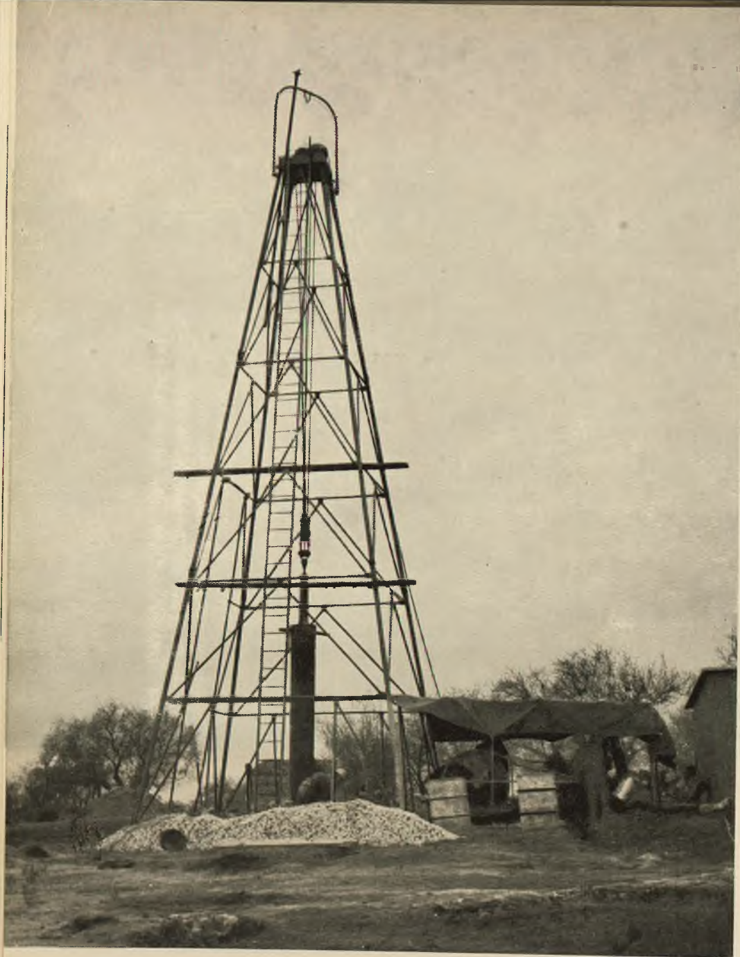
Fot. 5 - Cantiere a percussione.
