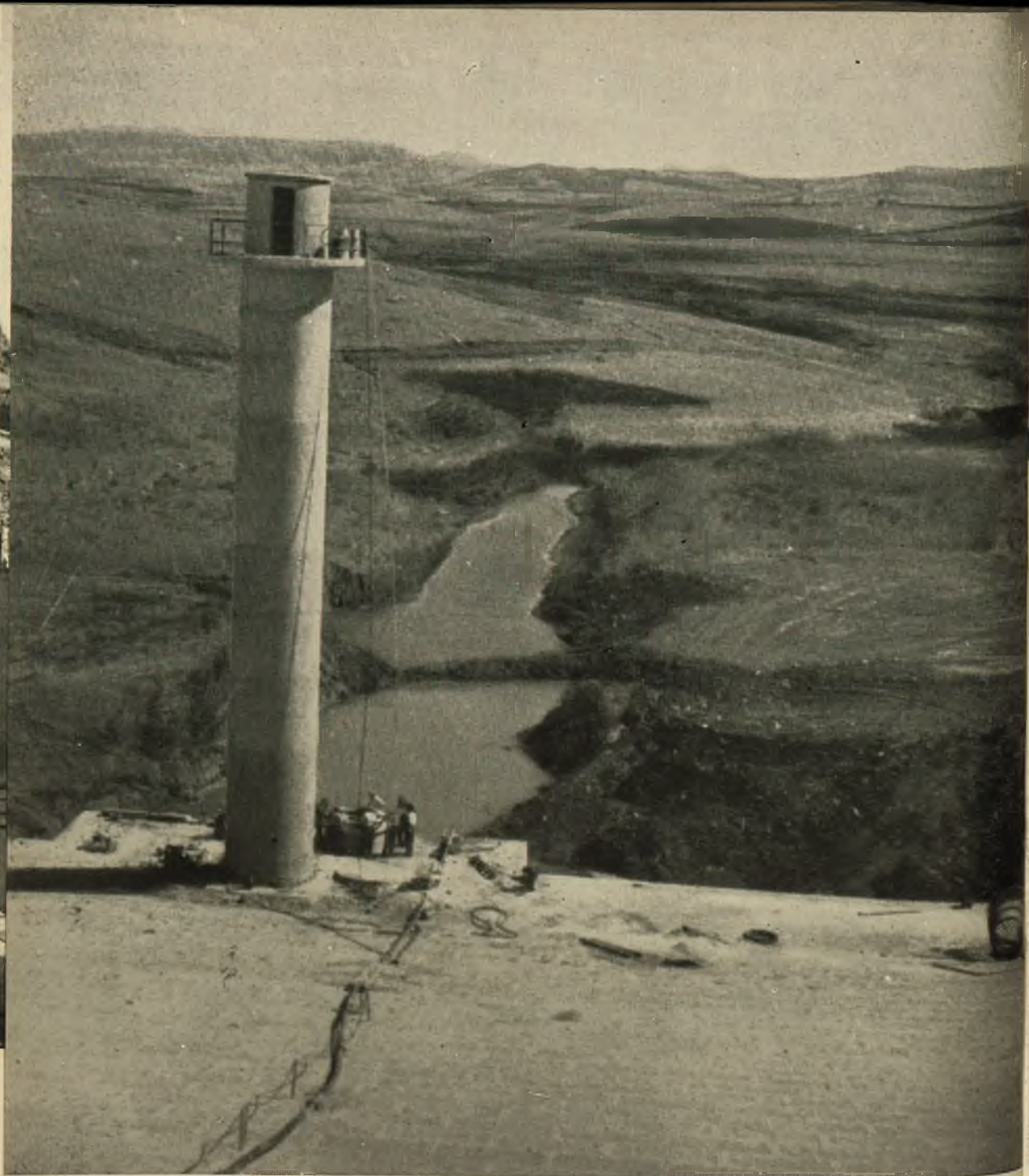
Fot. 22 - Serbatoio della Trinità sul fiume Delia (Sicilia): Torre di accesso alla camera valvole.
