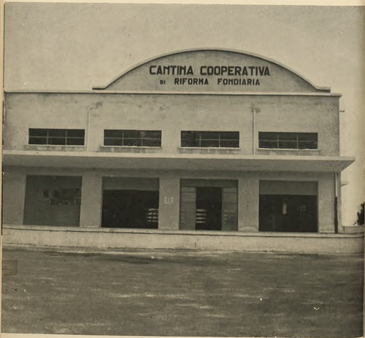
Fot. 4 - Cantina di Tutturano (Brindisi).
