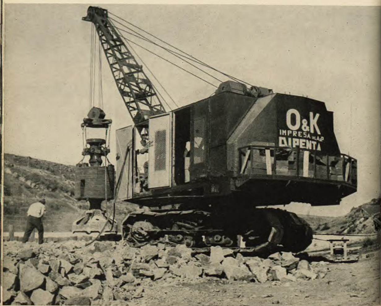
Fot. 39 - Serbatoio sul Rio Cuga (Sardegna): Particolare del mezzo vibrante.
