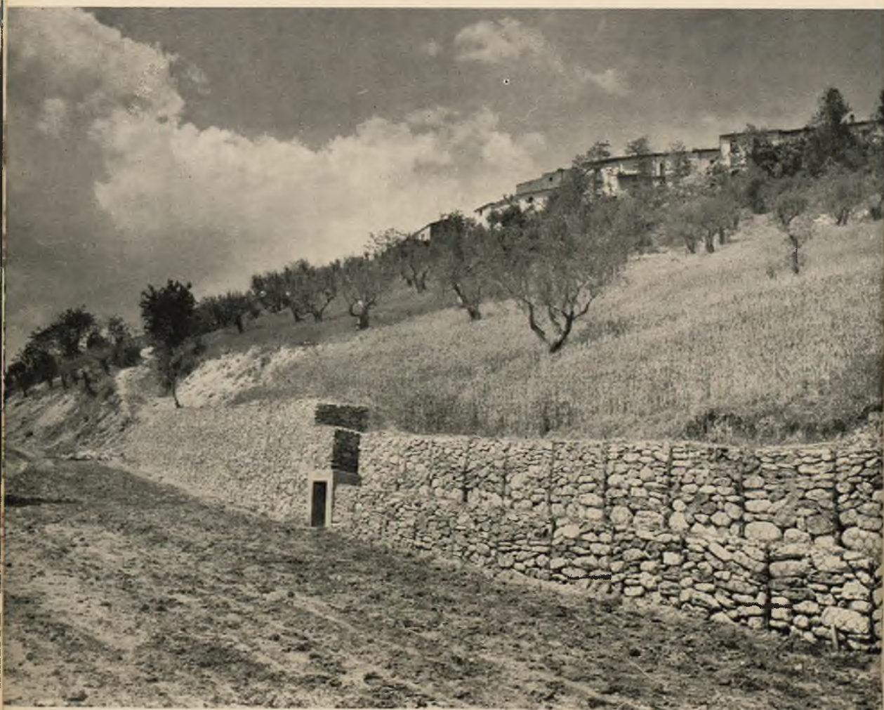
Fot. 26 - Comune di Teramo - Strada interpodereale spiano casette: Gabbionate di sostegno della strada in costruzione.
