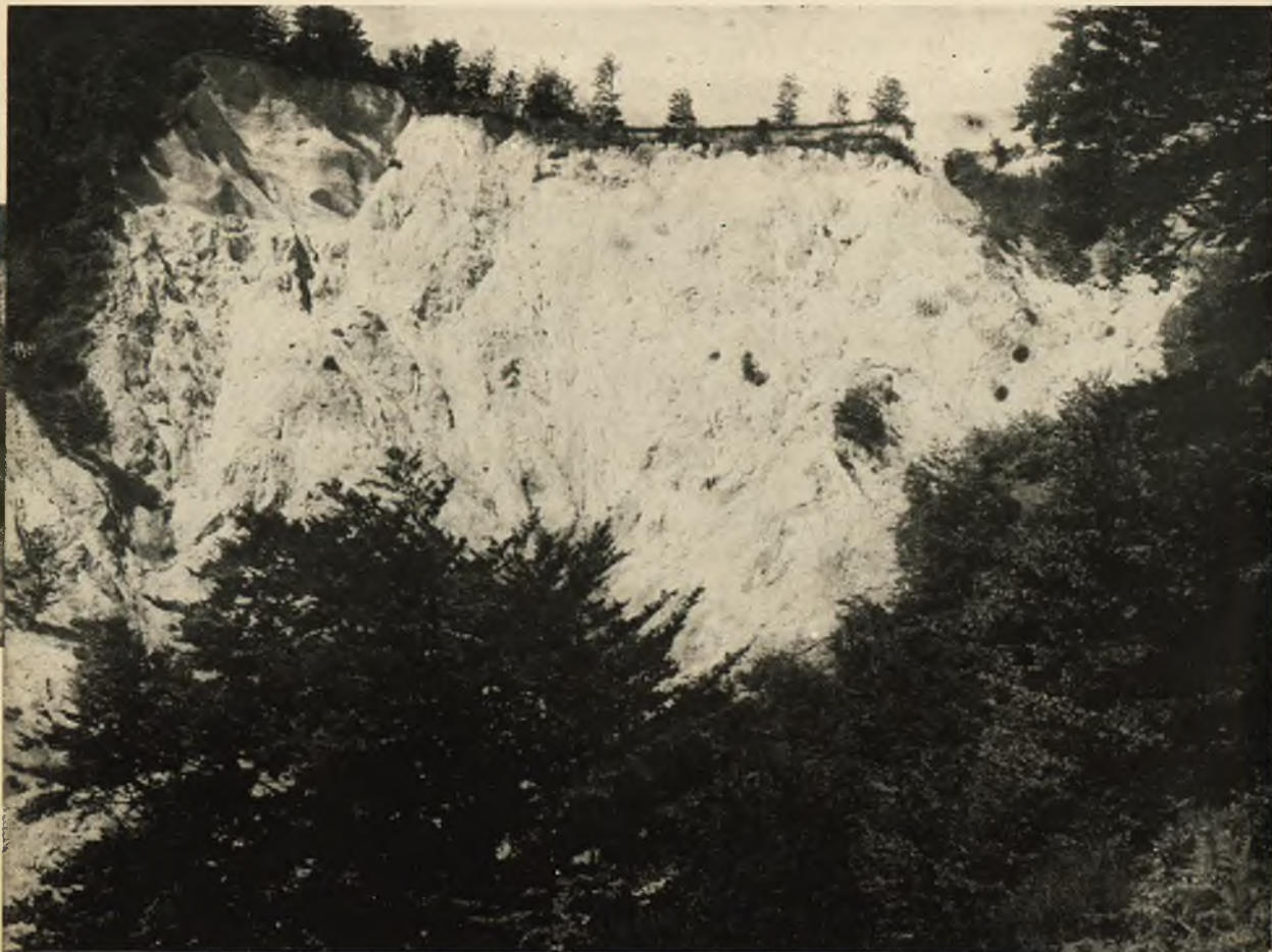
Fot. 30-39 - Reggio Calabria - BM Lordo Portigliola. Sistemazione della frana Timpa della Donna: Lavori in corso.
