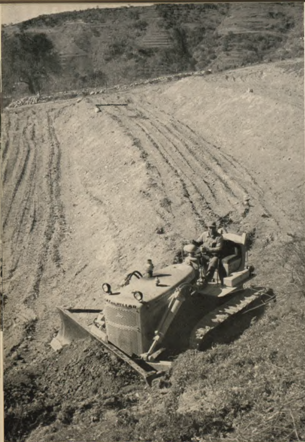
Fot. 14 - Azienda Nesci Bova - Reggio Calabria: Lavori in corso per terrazzamenti.
