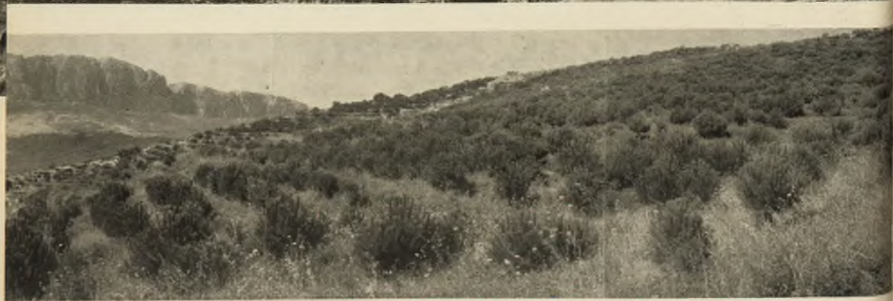
Fot. 19 - Caltanissetta - BM fiume Gela: Lavori di sistemazione idraulico-forestale (rimboschimento con eucalipti).
