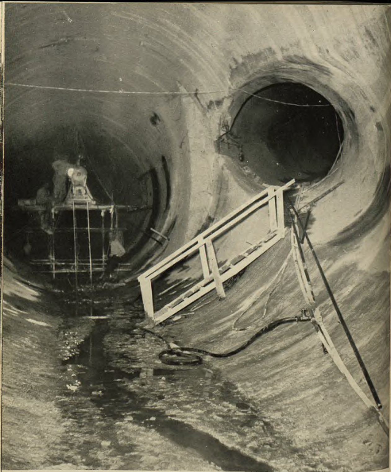
Fot. 16 - Serbatoio di Abate Alonia sul Rendina (Puglia): Galleria dello scarico di fondo e presa.
