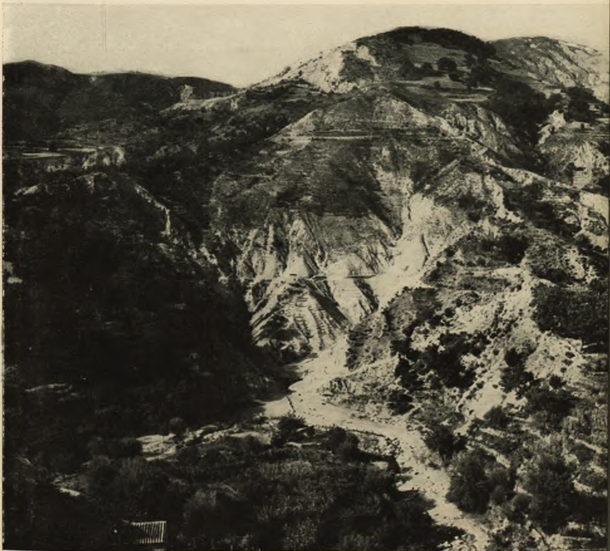
Fot. 43 - Cosenza - BM Precariti. Sistemazione della frana Paoli: Lavori in corso.
