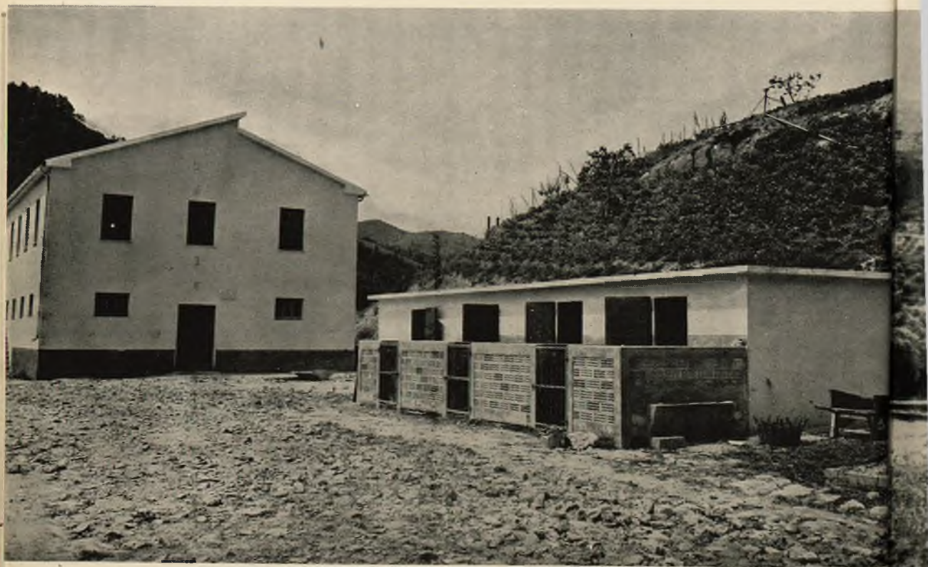
Fot. 31 - Fabbricato rurale in costruzione.
