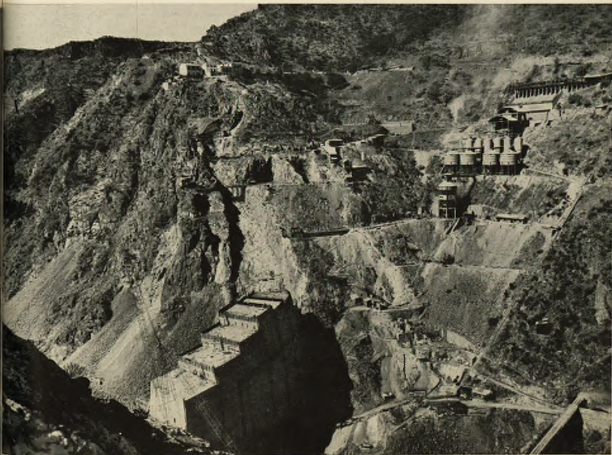
Fot. 3 - Serbatoio di Nuraghe Arrubiu sul Flumendosa (Sardegna): Panoramica dei getti.
