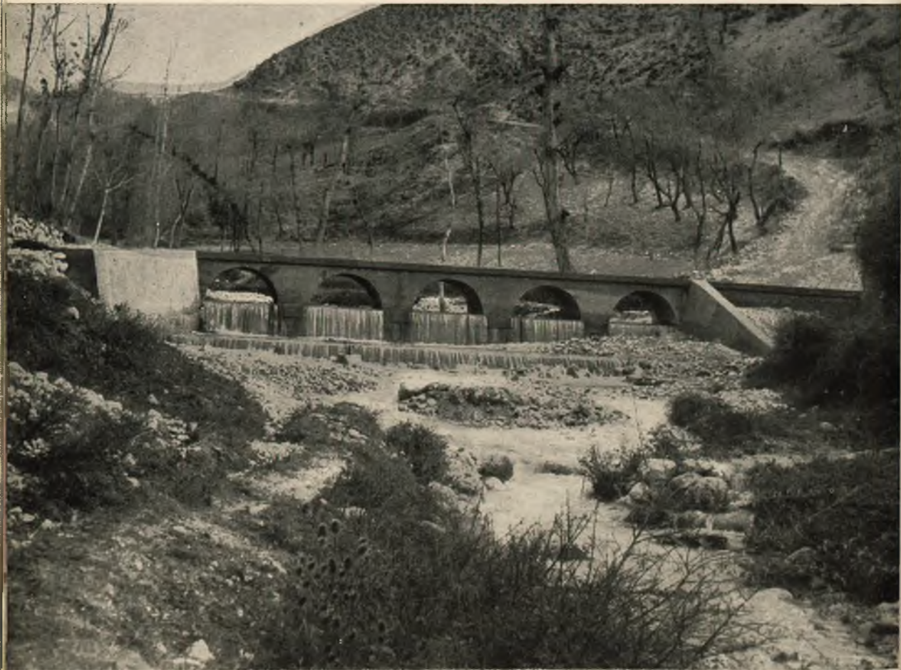
Fot. 12 - L'Aquila - BM torrente Vella. Sistemazione idraulico-connessa : Briglia con sovrastante passaggio.
