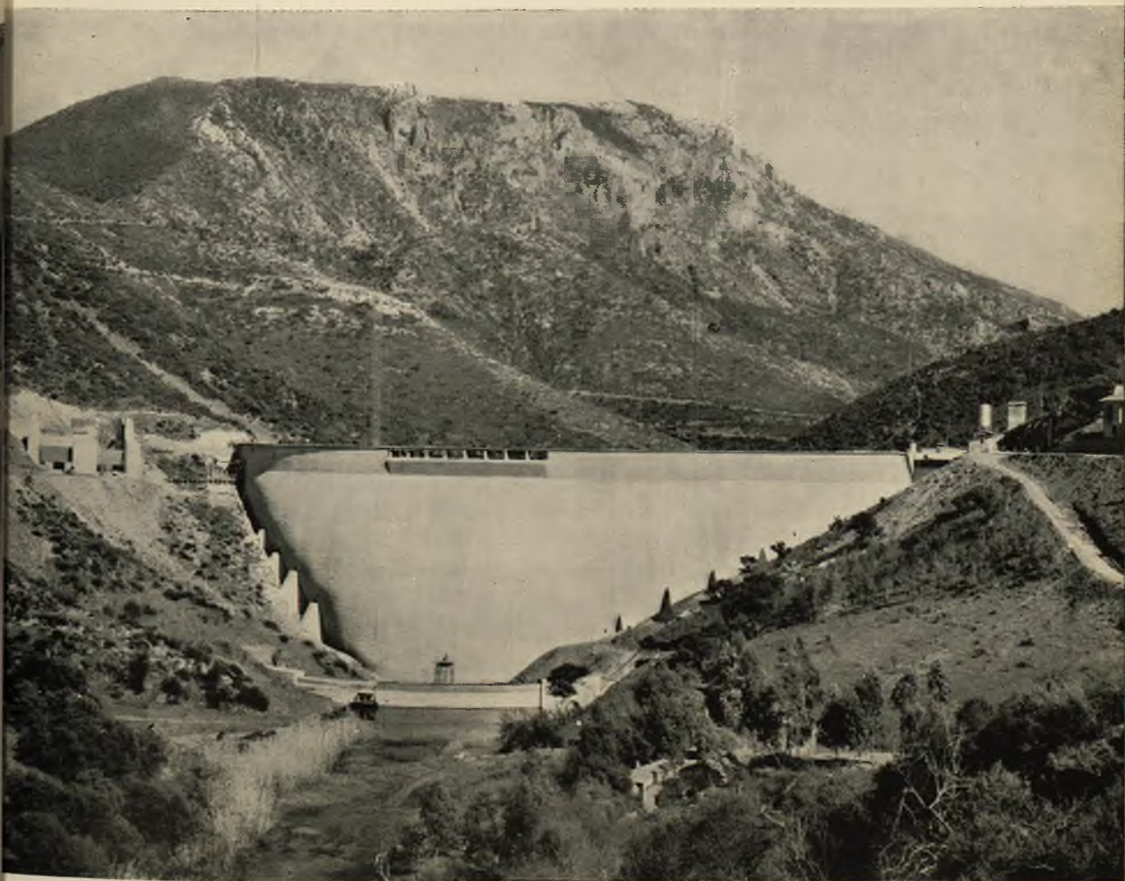
Fot. 60 - Sbarramento di Punta Gennarta sul Rio Canonica (Sardegna): La diga ultimata.
