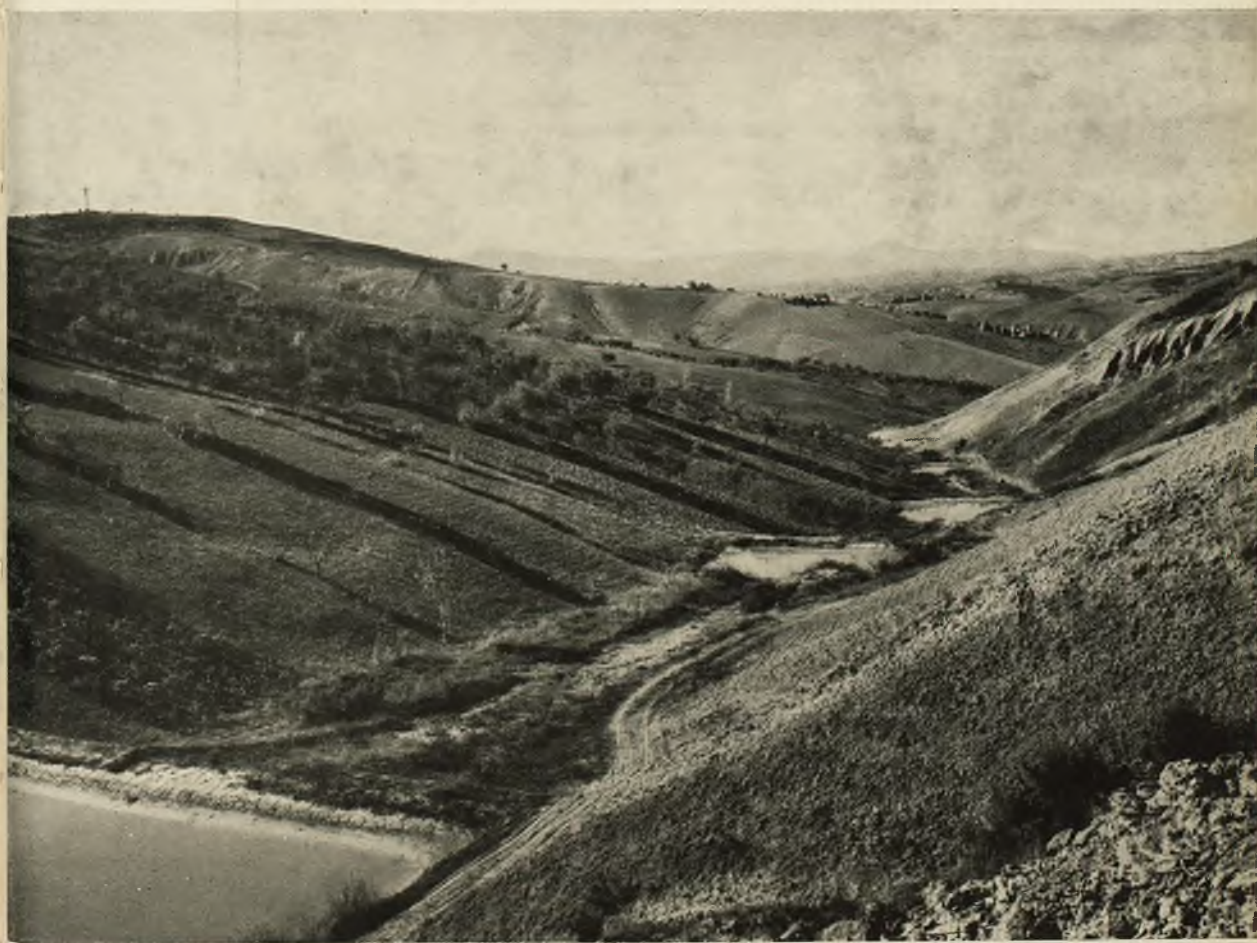
Fot. 4 - Teramo - CB del Tronto: Traverse in terra.
