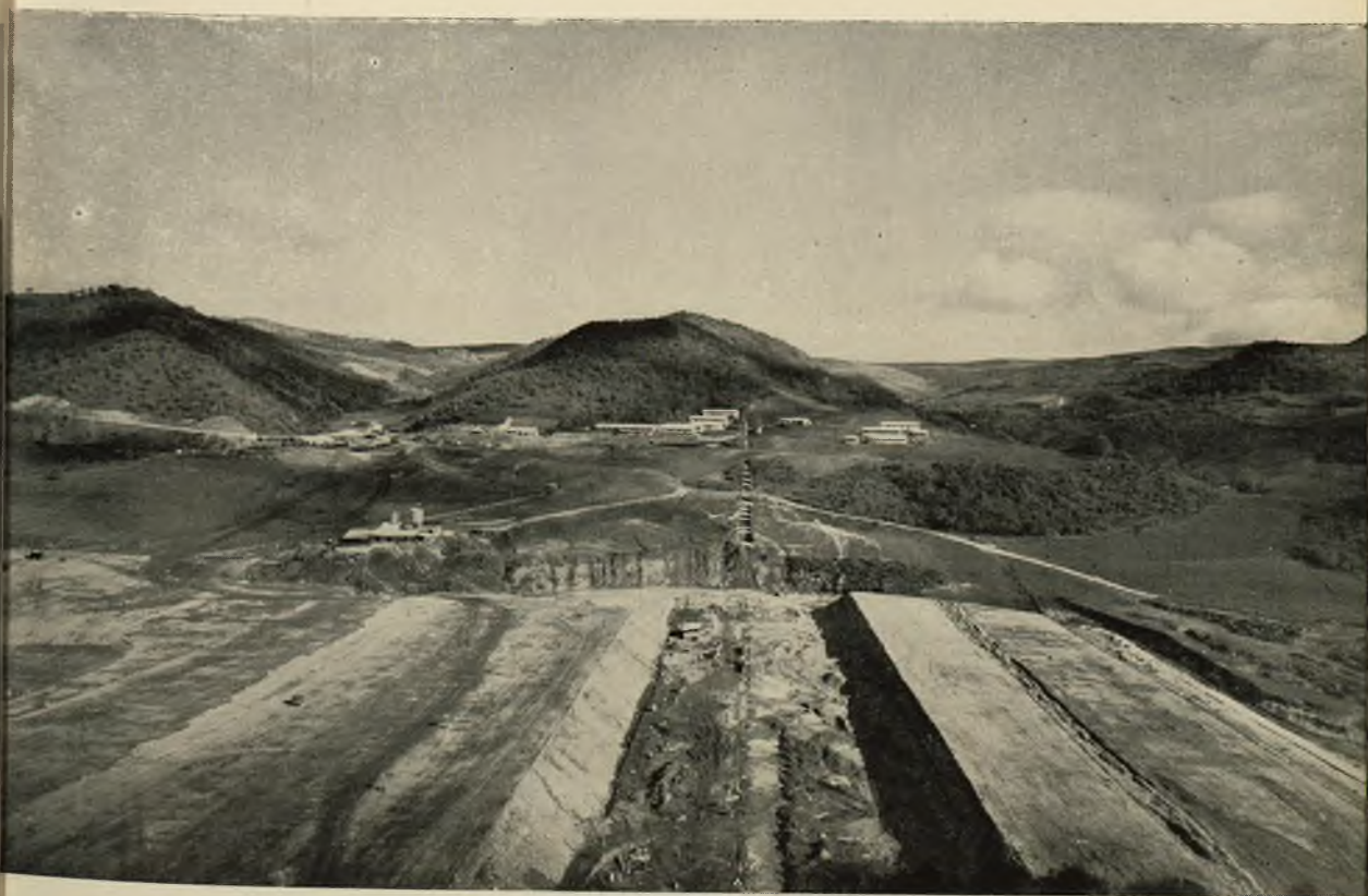
Fot. 46 - Sbarramento di San Pietro sull'Ossento (Campania): Il corpo della diga in fase di esecuzione.
