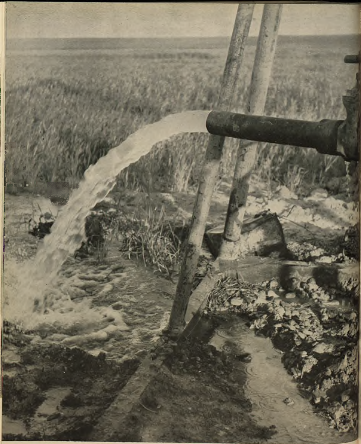
Fot. 9 - Pozzo in emungimento.
