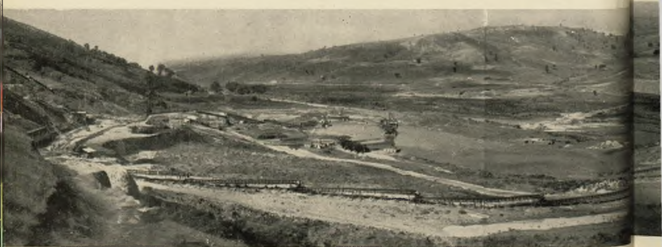
Fot. 43 - Diga di Occhito sul fiume Fortore (Puglia): Vista del cantiere della diga. Impianto di approvvigionamento del materiale alluvionale; rinfianco di monte e muro al piede di valle della diga; scarico di superficie.
