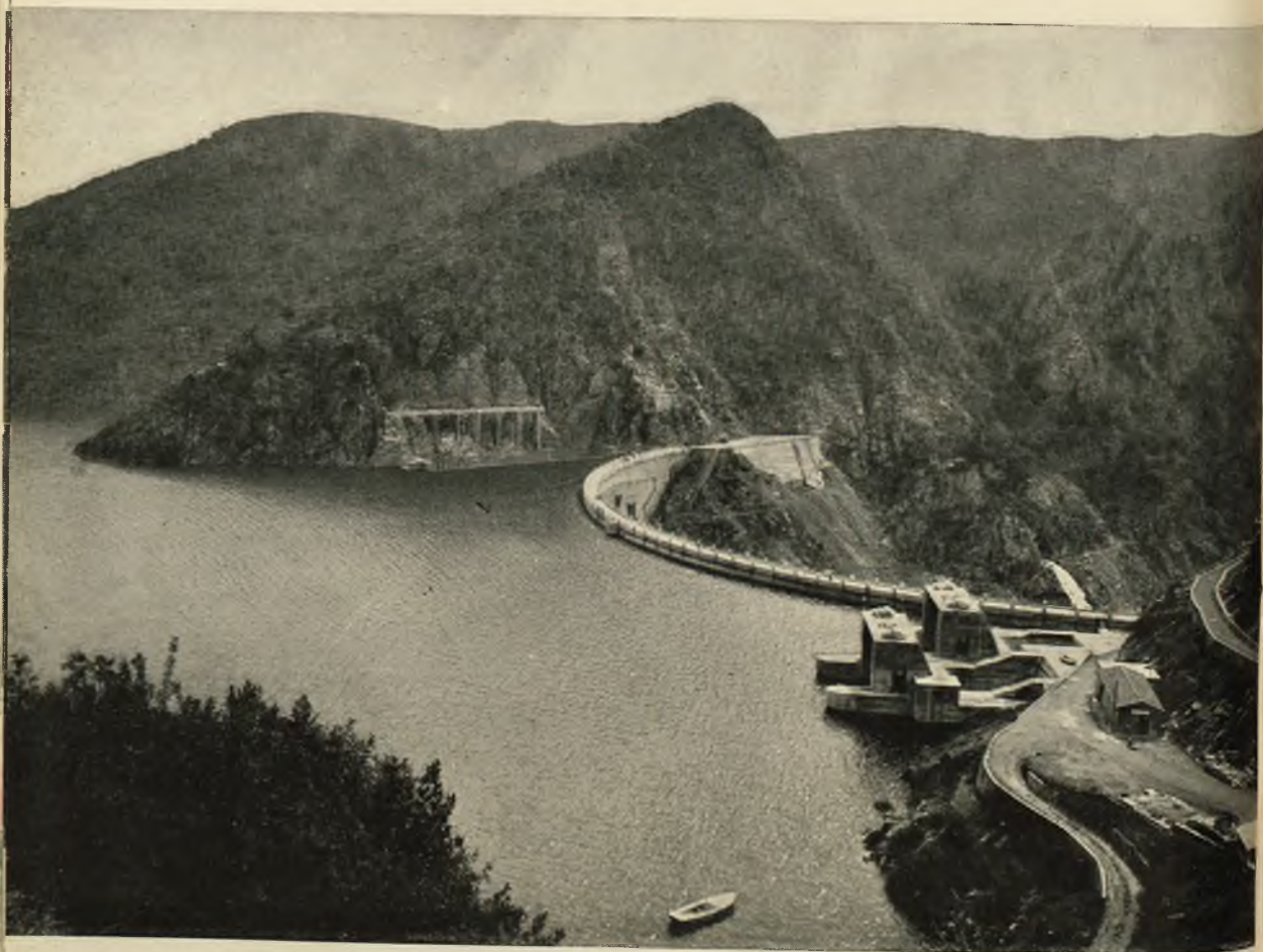
Fot. 7 - Serbatoio di Nuraghe Arrubiu sul Flumendosa (Sardegna): Il serbatoio totalmente invasato.
