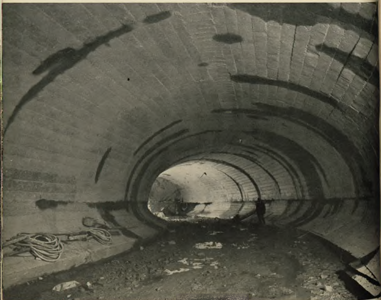
Fot. 57 - Sbarramento di Punta Gennarta sul Rio Canonica (Sardegna): Galleria scarico di superficie.
