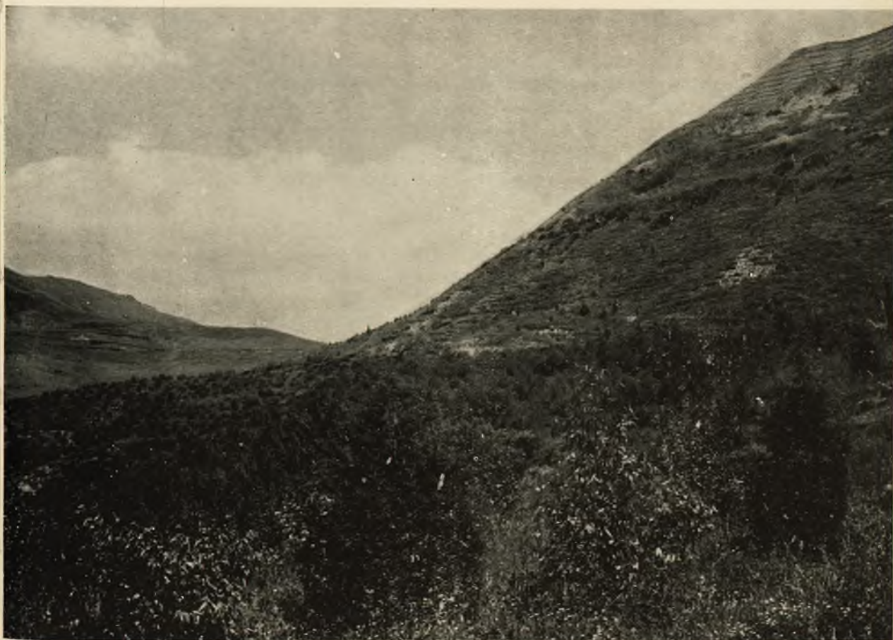
Fot. 17 - Palermo - BM Imera settentrionale: Lavori di sistemazione idraulico-forestale (rimboschimento e consolidamento di pendici franose).
