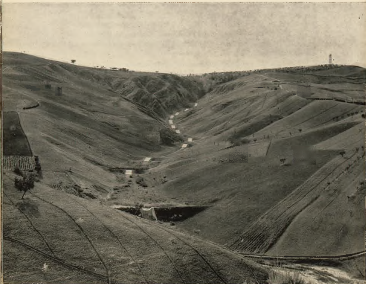
Fot. 14 - Catanzaro - BM torrente Zinnavo: Opere di sistemazione idraulica a protezione di zone a coltura agraria.
