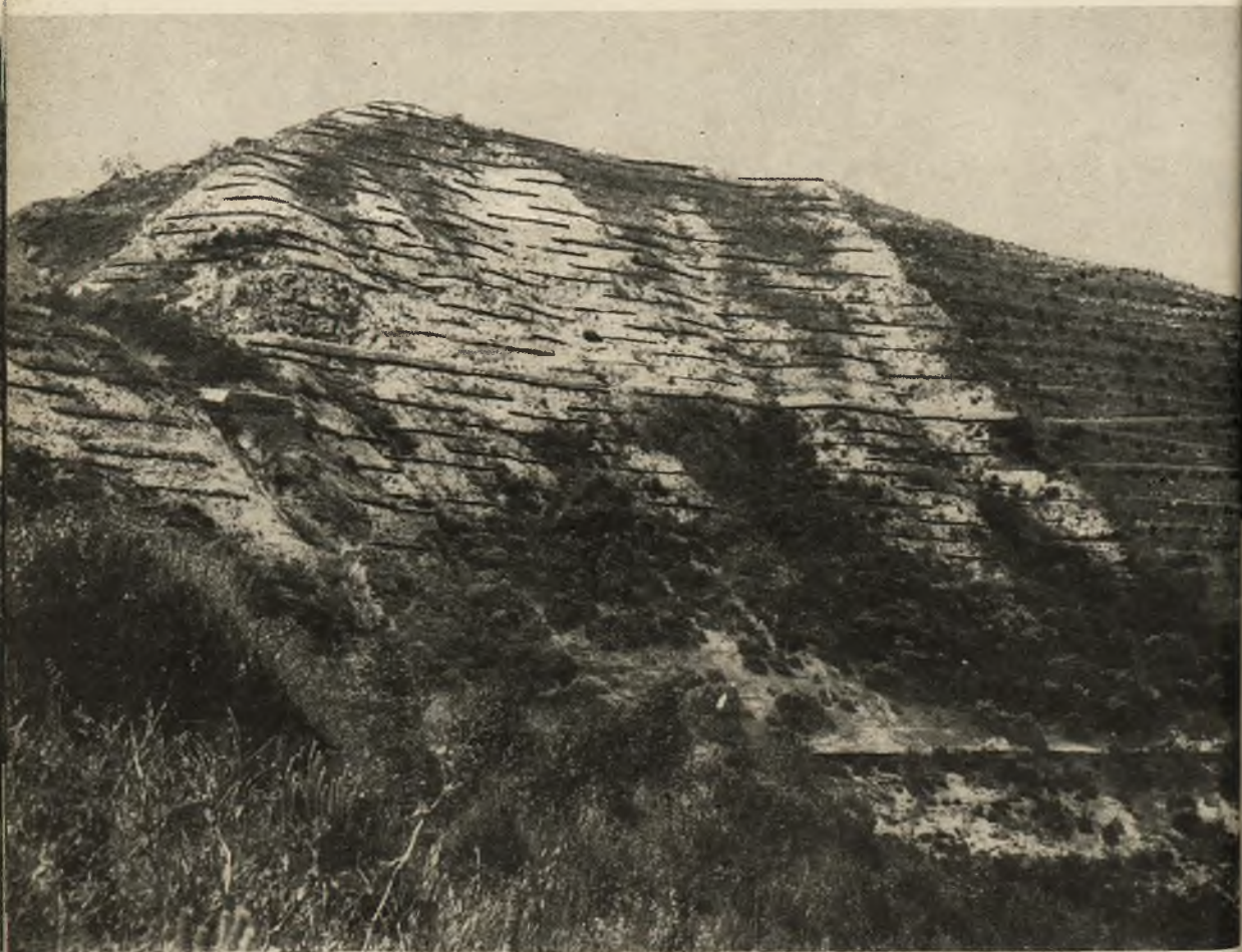
Fot. 50 - Palermo - BM Imera settentrionale; Consolidamento pendici franose.
