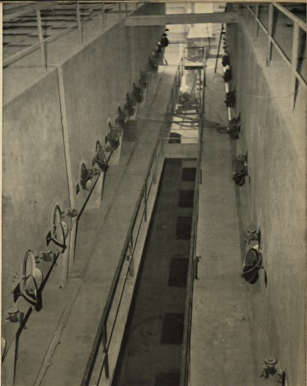
Fot. 8 - Cantina Sociale di Ostuni (Brindisi): Panoramica di vasche.
