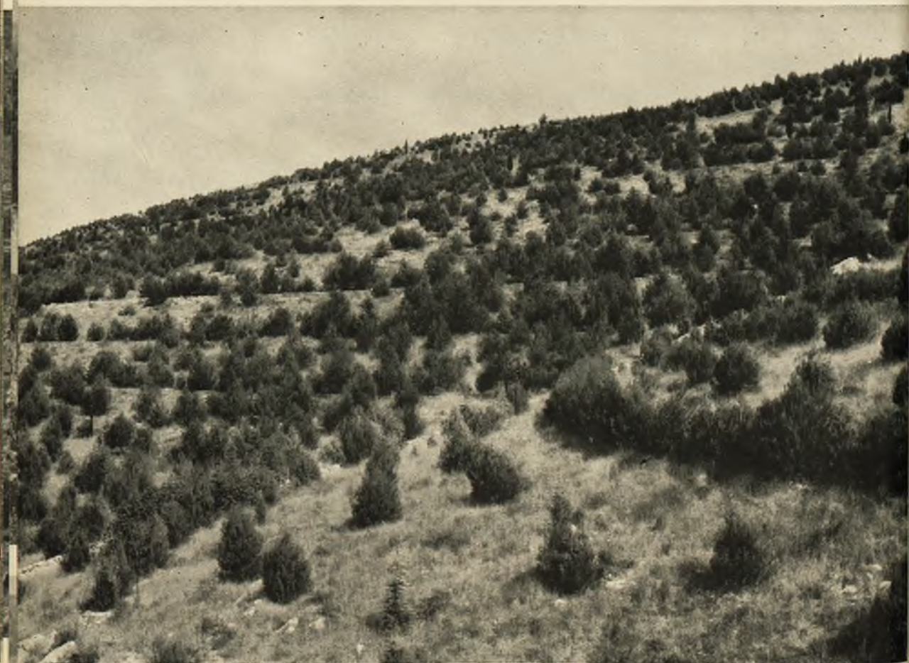
Fot. 21 - Foggia - BM torrente Locone: Lavori di sistemazione idraulico-forestale.
