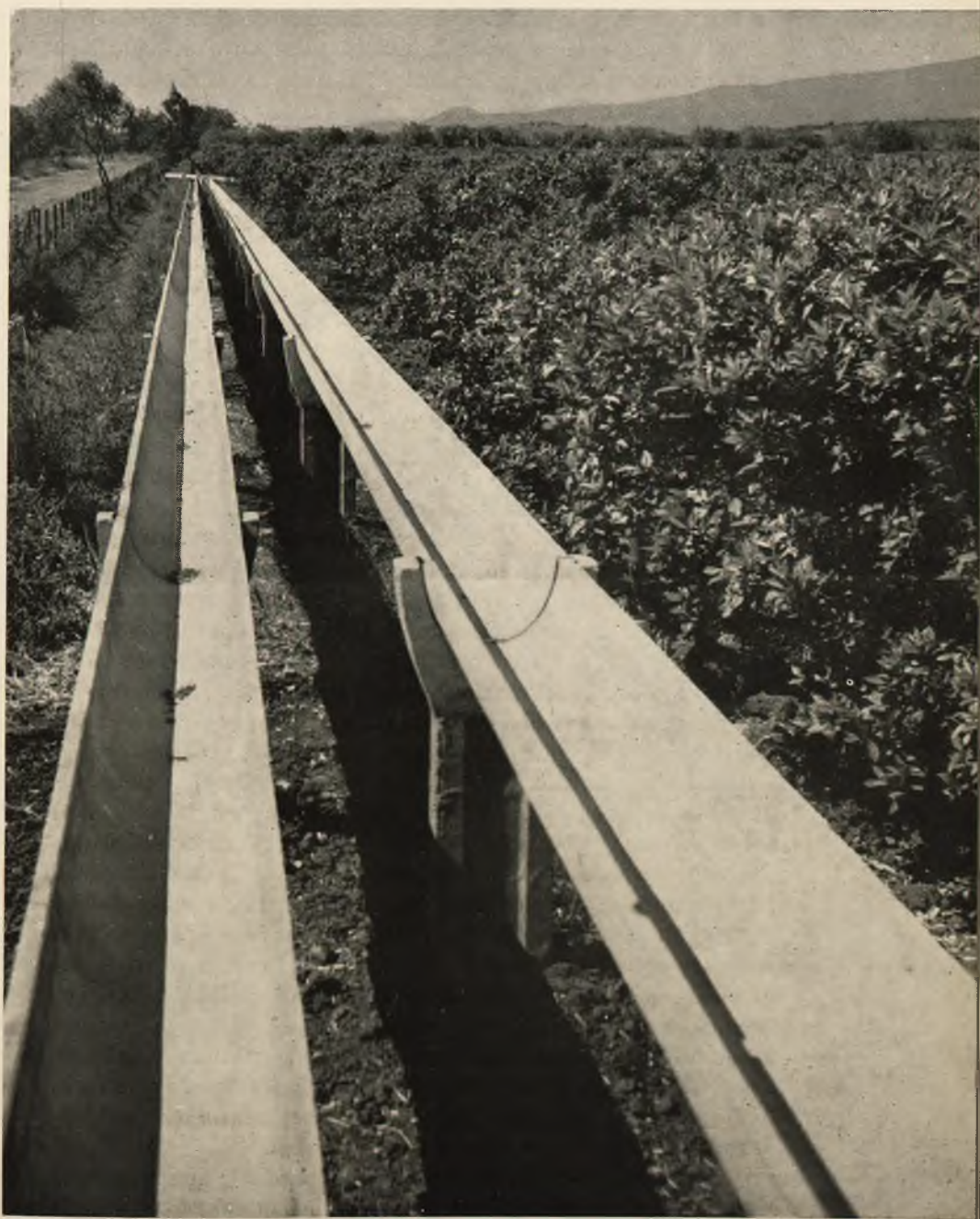
Fot. 16 - Reti di distribuzione irrigua nella piana di Catania (Sicilia).
