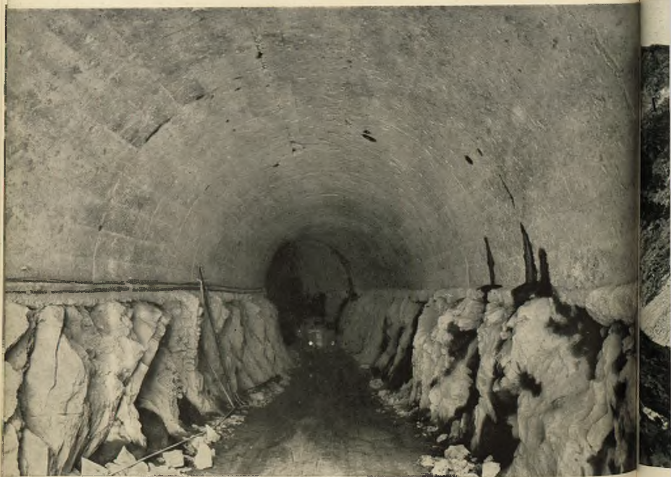
Fot. 2 - Serbatoio di Nuraghe Arrubiu sul Flumendosa (Sardegna): Galleria di scarico in destra.
