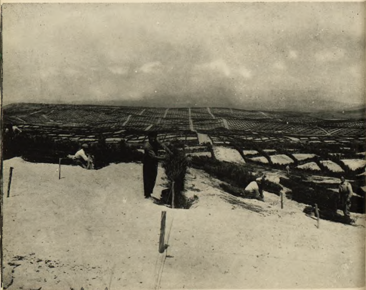
Fot. 27 - Cagliari - Litorale Foci Tirso-Is Arenas: Dune in corso di sistemazione.
