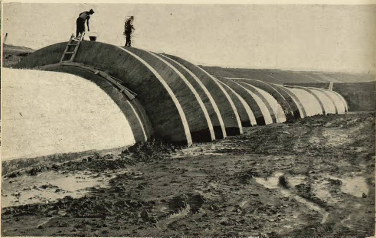
Fot. 20 - Serbatoio della Trinità sul fiume Delia (Sicilia): Galleria in c. a. — inserita nel corpo della diga.
