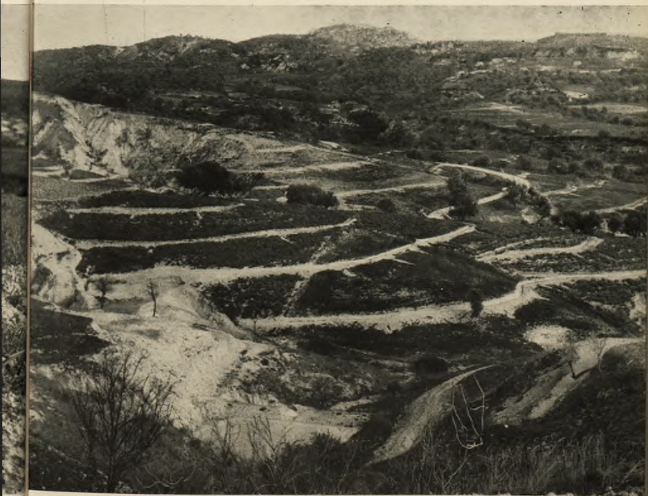
Fot. 55 - Reggio Calabria - CB di Caulonia: Sistemazione idraulico-agraria in corso di completamento.
