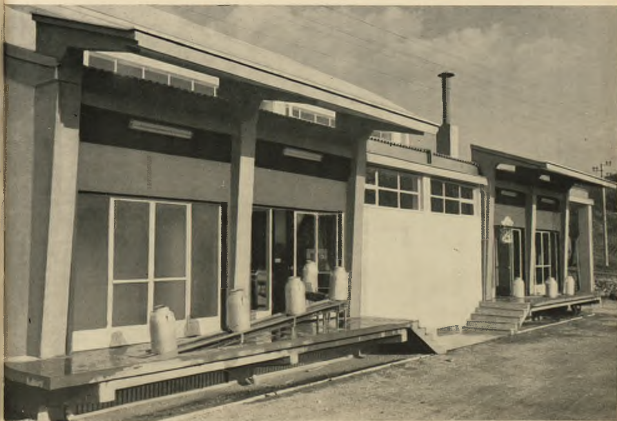
Fot. 1 - L'Aquila - Centrale del latte: Lato ricevimento automatico bidoni.
