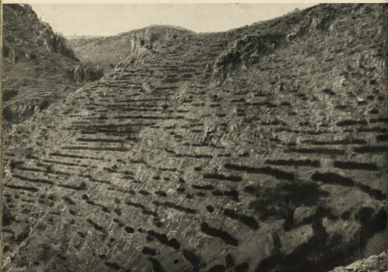
Fot. 18 - Palermo - BM Passo di Rigano: Lavori di sistemazione idraulico-forestale (rimboschimento a mezzo semina di pino domestico)
