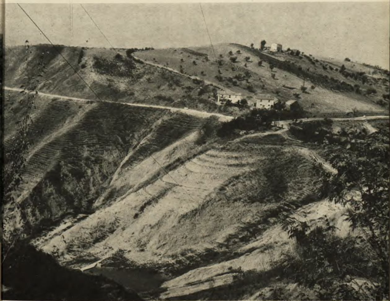
Fot. 47 - Teramo - BM dei torrenti Piomba, Cerrano e Calvano (calanchi di Atri): Sistemazione della frana nel fosso Plaia.
