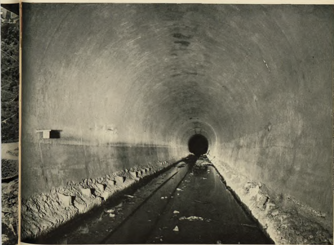
Fot. 11 - Serbatoio di Monte Su Rei sul Rio Mulargia (Sardegna): Galleria di derivazione.
