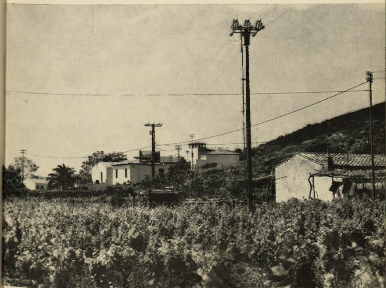
Fot. 4 - Linee elettriche e cabine di trasformazione su sostegni tubolari rastremati in acciaio.
