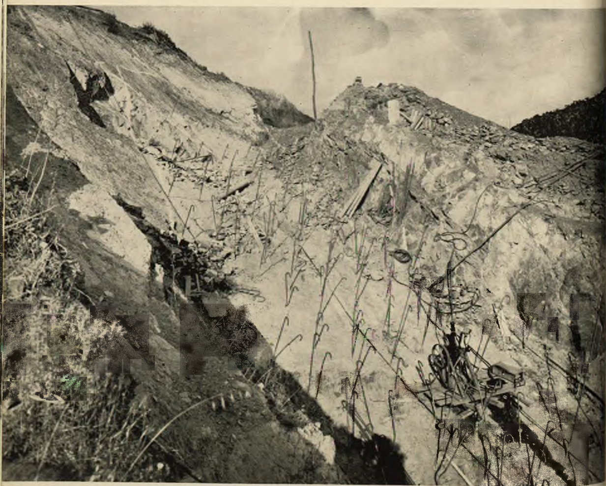
Fot. 55 - Sbarramento di Punta Gennarta sul Rio Canonica (Sardegna): Chiodatura della roccia di imbasamento.
