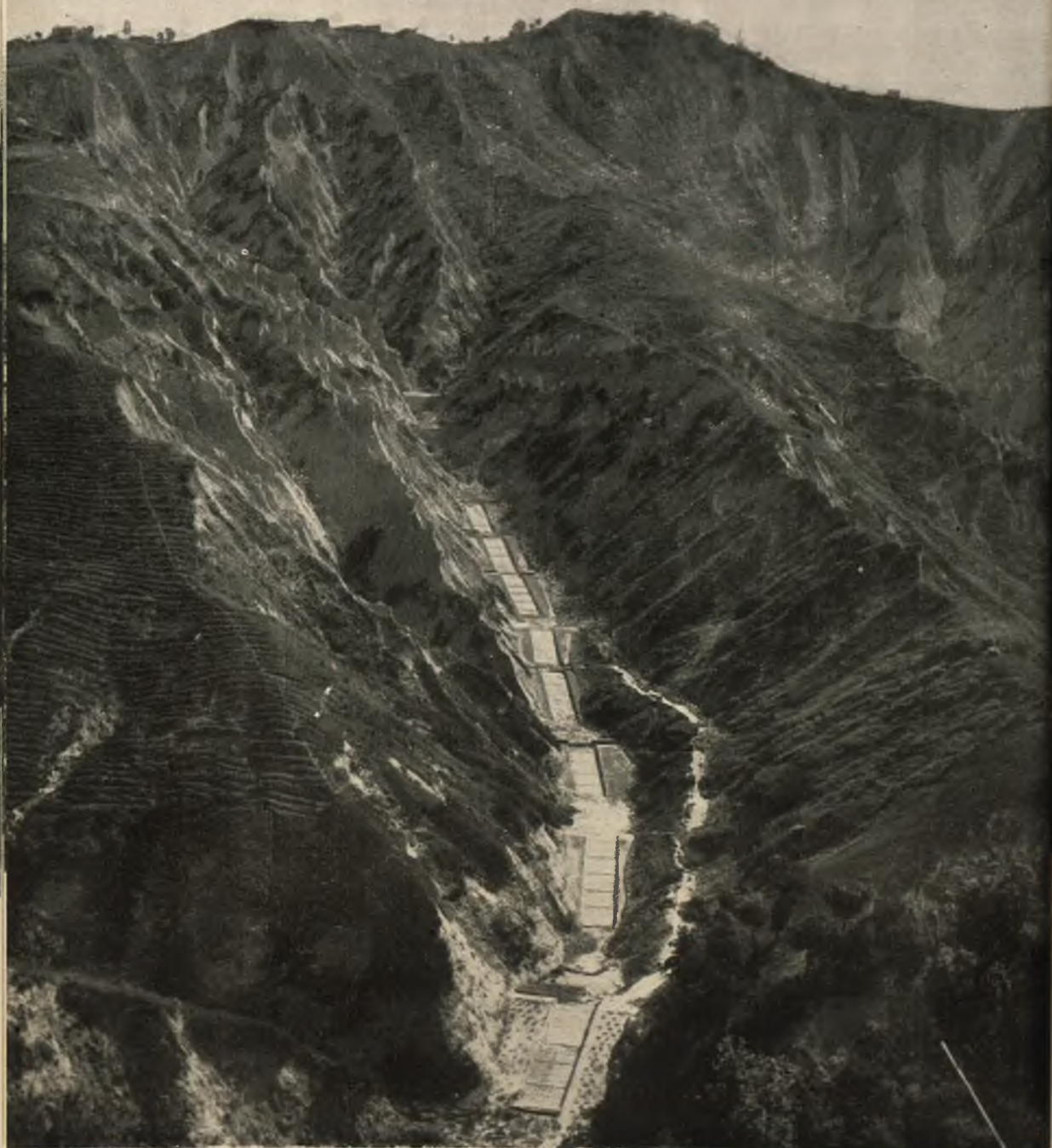
Fot. 52 - Teramo - BM dei torrenti Piomba, Cerrano e Calvano (calanchi di Atri). Sistemazione zone calanchive: Lavori in corso.
