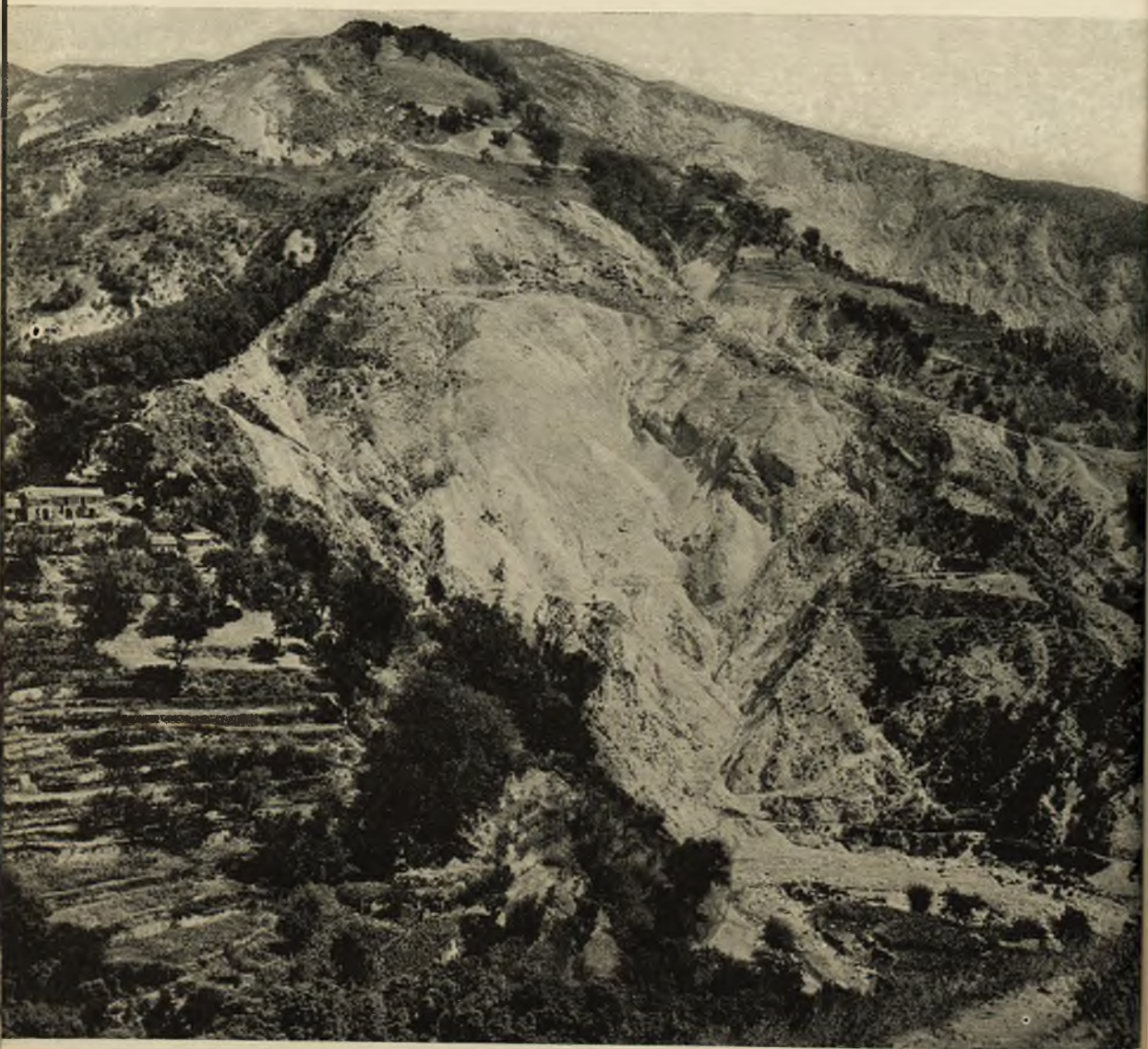
Fot. 42 - Cosenza - BM Precariti. Sistemazione della frana Paoli: Lavori da iniziare.
