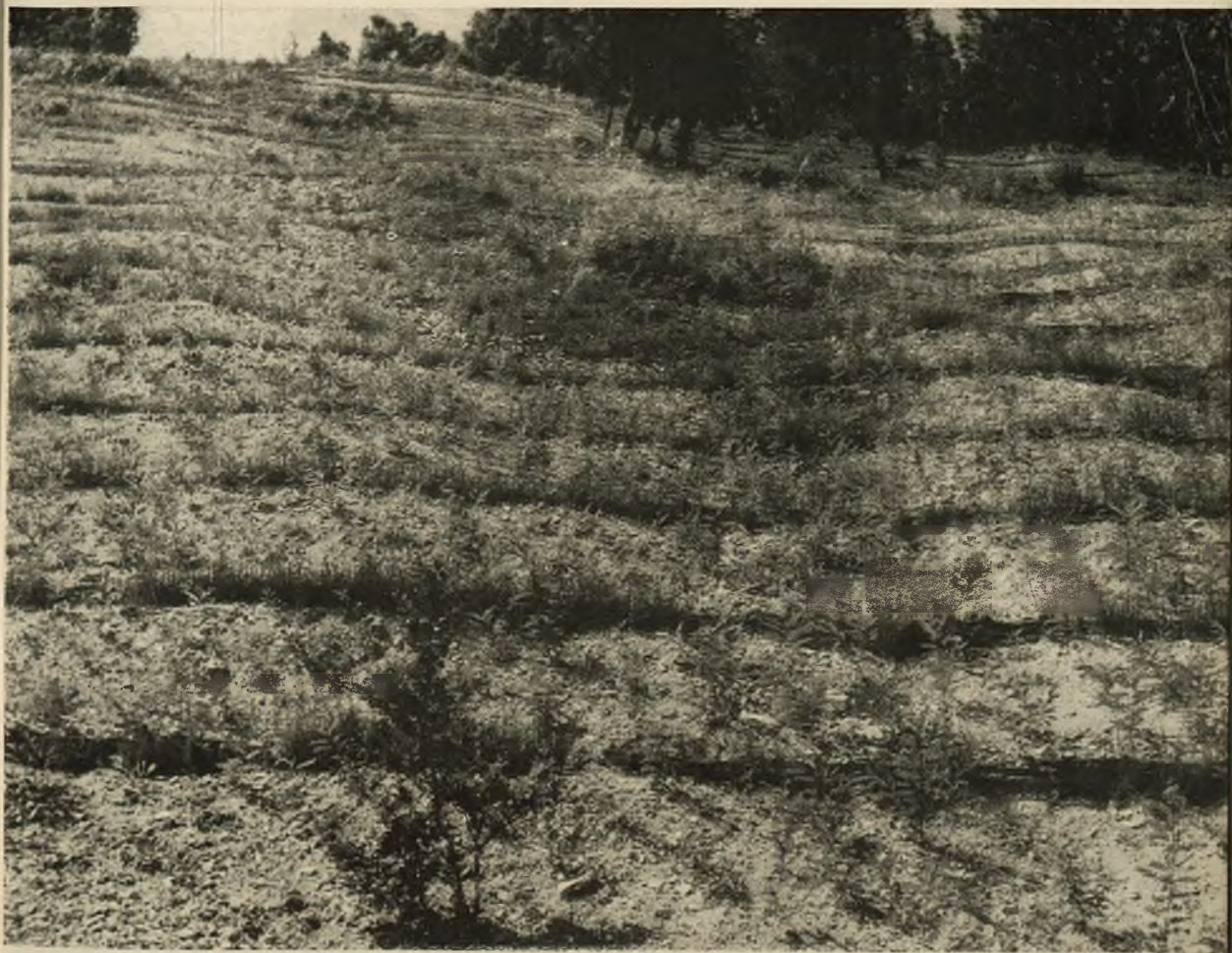
Fot. 41 - Reggio Calabria - BM Mesima. Sistemazione della frana dell'Omo Morto: Lavori in corso.
