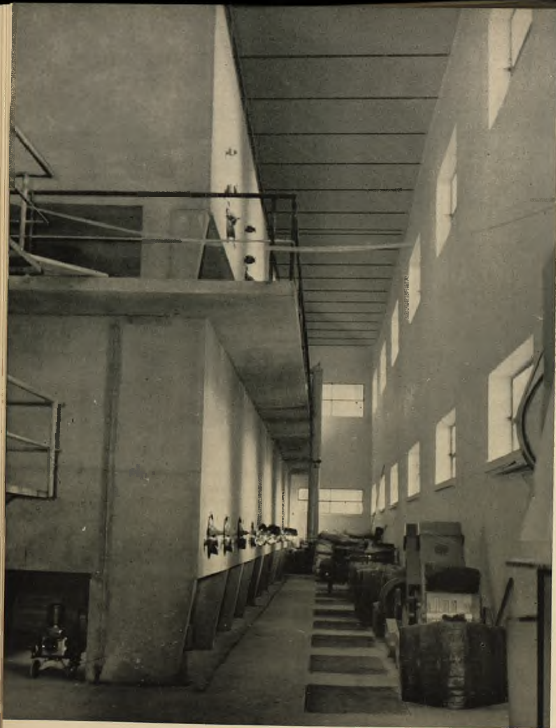
Fot. 7 - Cantina Sociale di Ostuni (Brindisi): Particolare di vasche.
