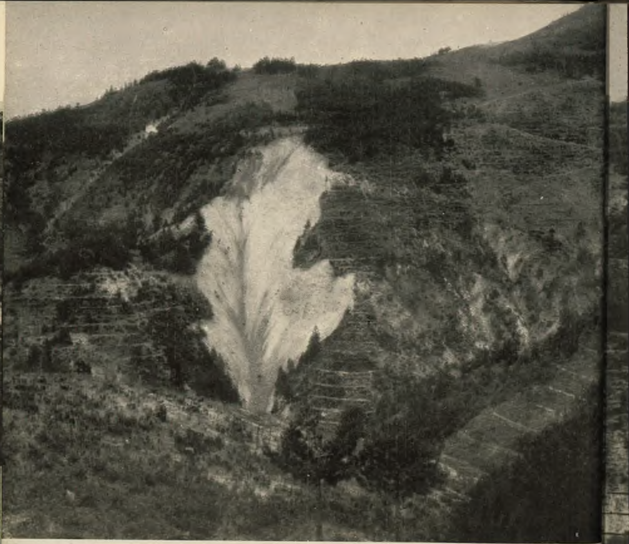
Fot. 48 - Cosenza - BM Trionto. Sistemazione della frana Caprice: Lavori da iniziare.
