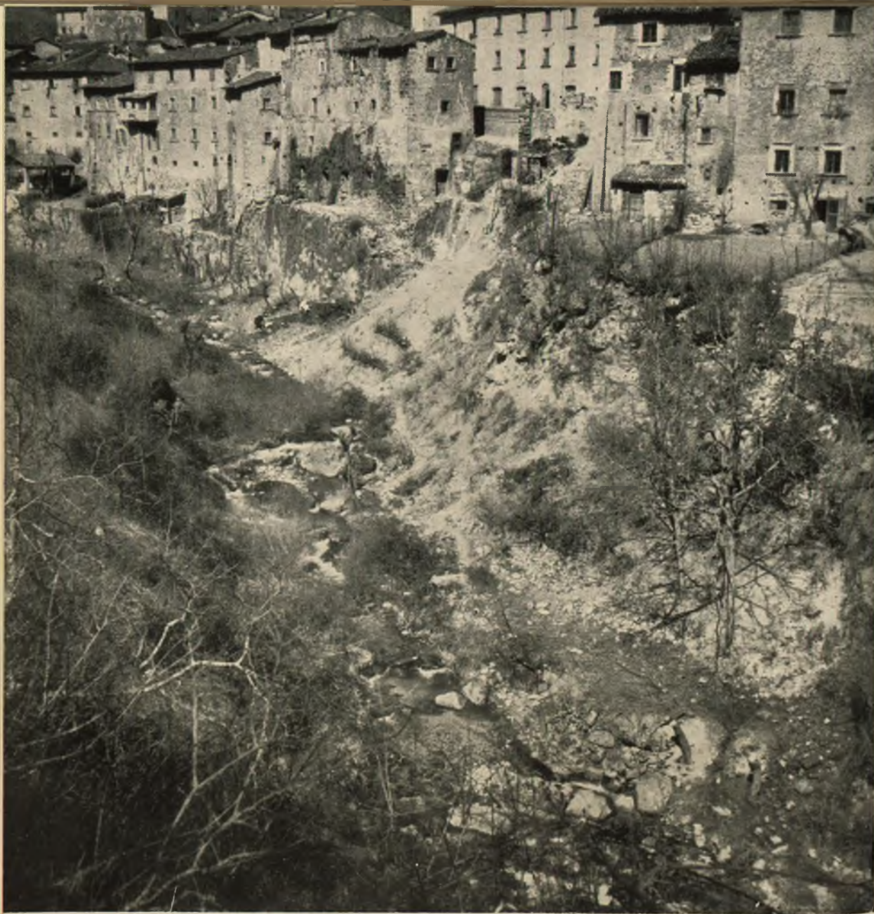
Fot. 1 - Ascoli Piceno - BM fiume Tronto: Abitato di Borgo minacciato da erosione torrentizia.
