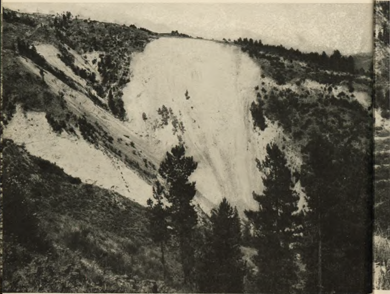
Fot. 44 - Cosenza - BM Trionto. Sistemazione della frana Maddalena: Lavori da iniziare.
