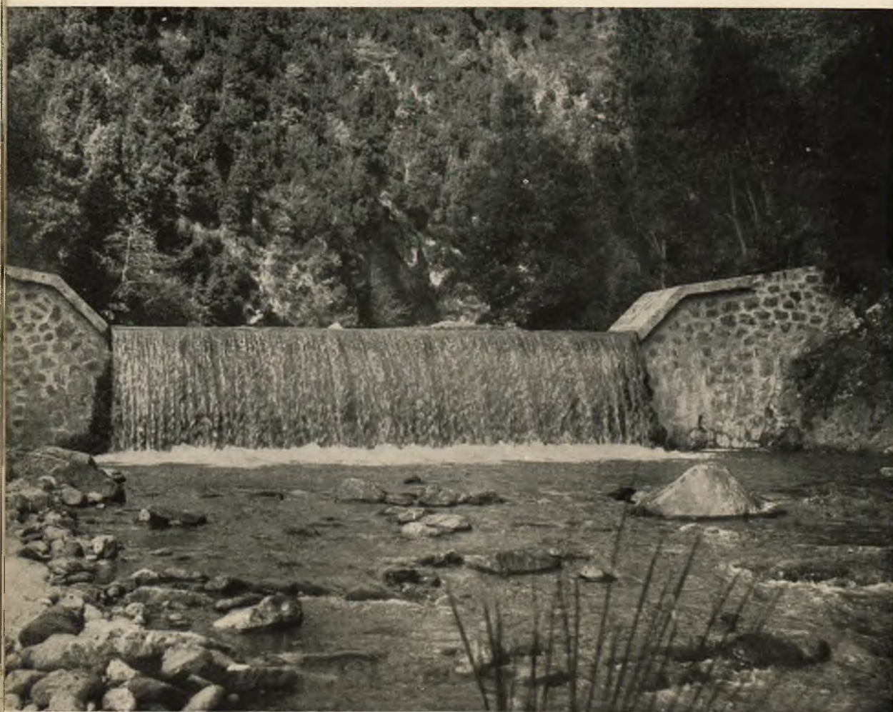
Fot. 10 - Catanzaro - BM Angitola, sottobacini Reschia, Fallà e Scardizzi: Lavori di sistemazione idraulico-connessa.
