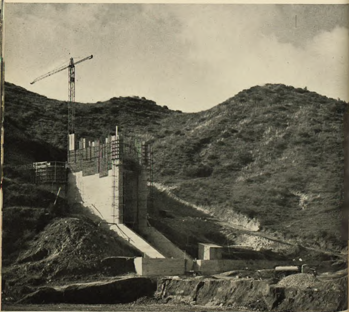
Fot. 47 - Sbarramento di San Pietro sull'Ossento (Campania): Imbocco dello scarico di fondo.
