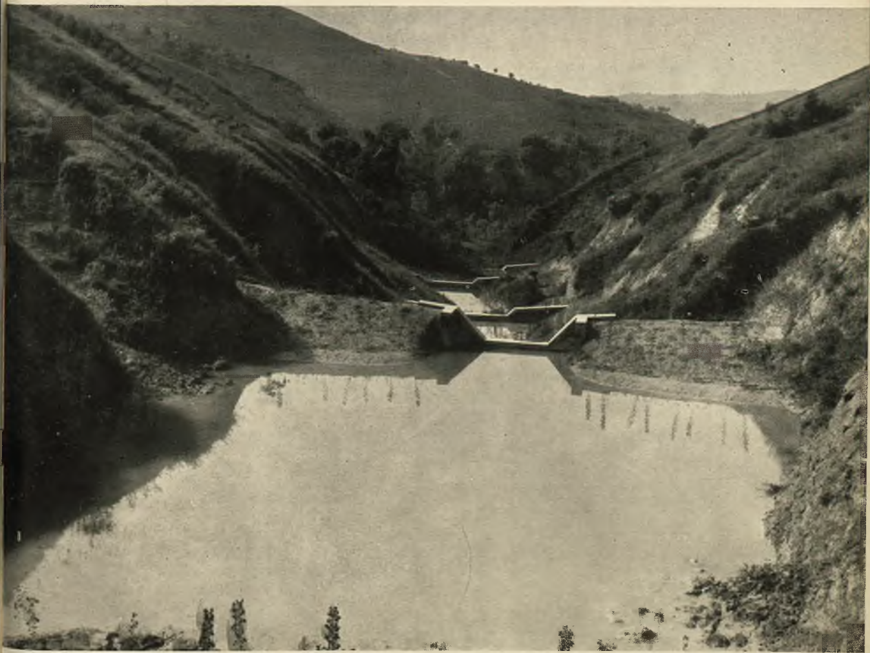
Fot. 8 - Teramo - BM Piomba Cerrano-Calvano: Sistemazione zone precalan- chive con opere in terra e scivolo in calcestruzzo.
