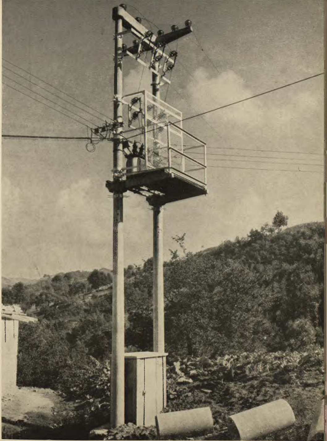
Fot. 5 - Cabina di trasformazione su pali in cemento armato centrifugato, per « centro » rurale.
