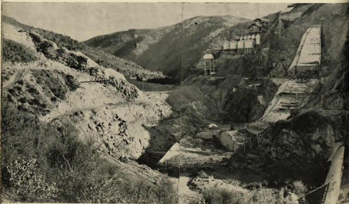
Fot. 53 - Sbarramento di Pietra del Pertusillo sul fiume Agri (Lucania): Getto del pulvino in sponda destra.
