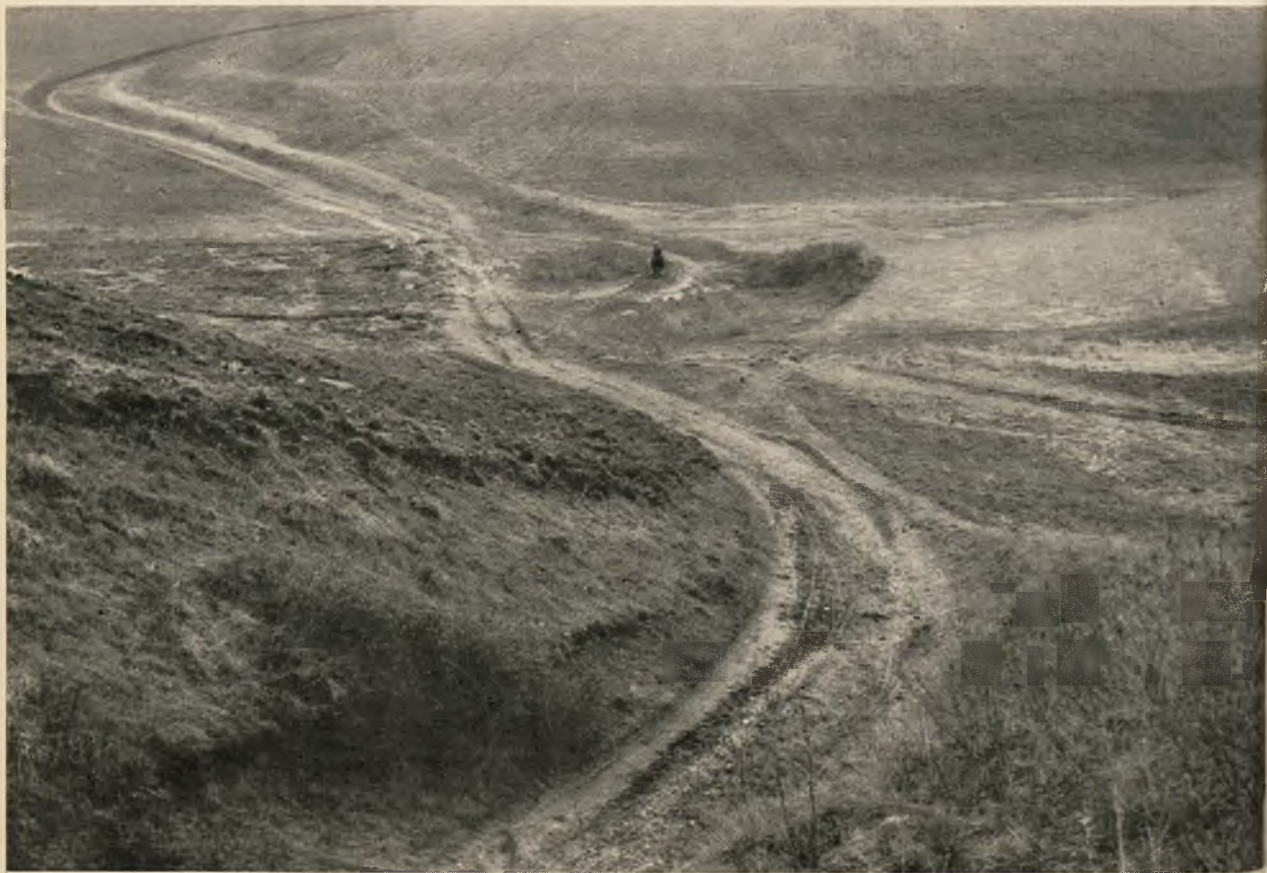
Fot. 6 - Consorzio stradale Valloni-Zipippo - Gravina di Puglia (Bari). Prima della costruzione della strada: Il tracciato preesistente.
