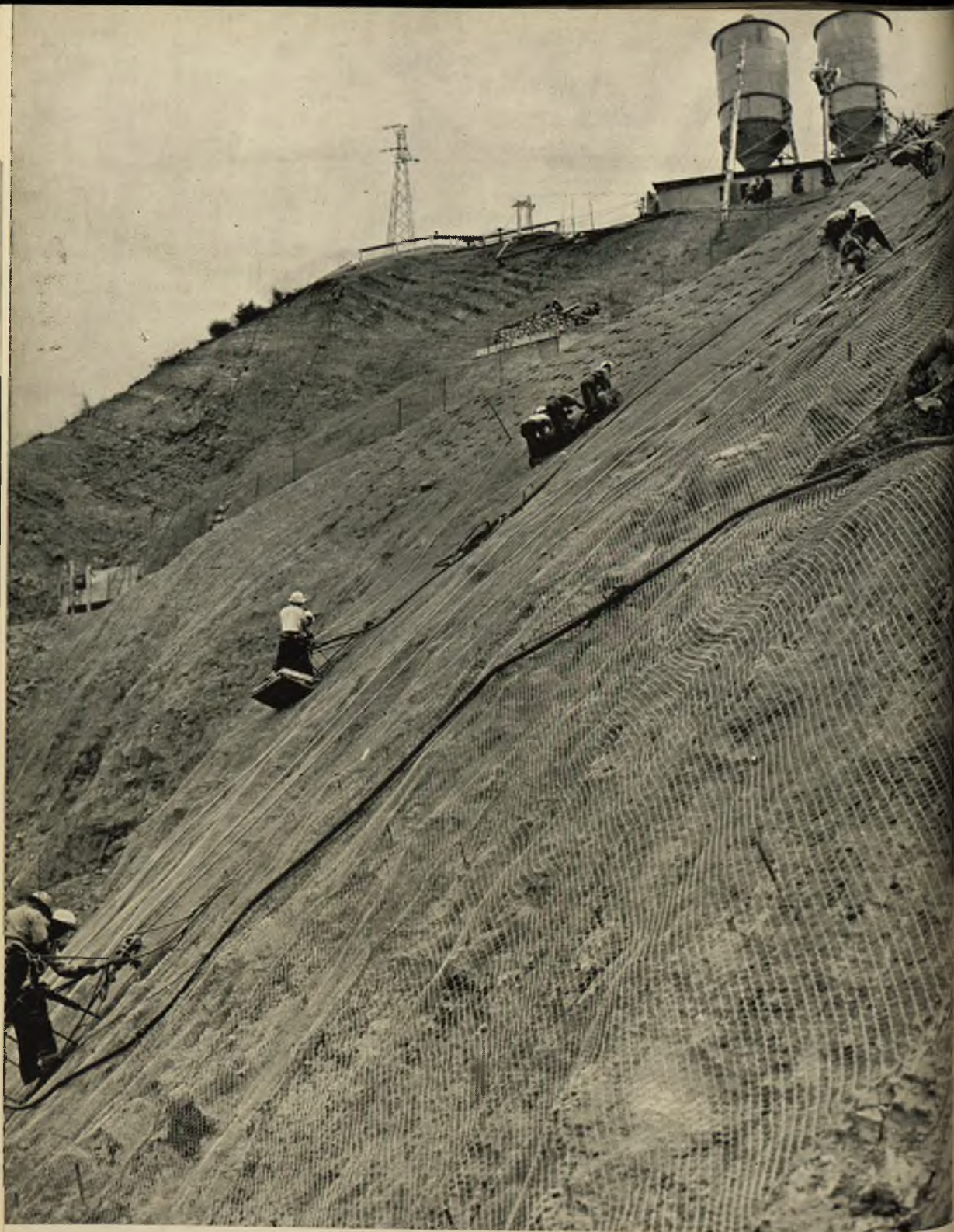
Fot. 51 - Sbarramento di Pietra del Pertusillo sul fiume Agri (Lucania): Protezione delle scarpate con rete metallica.
