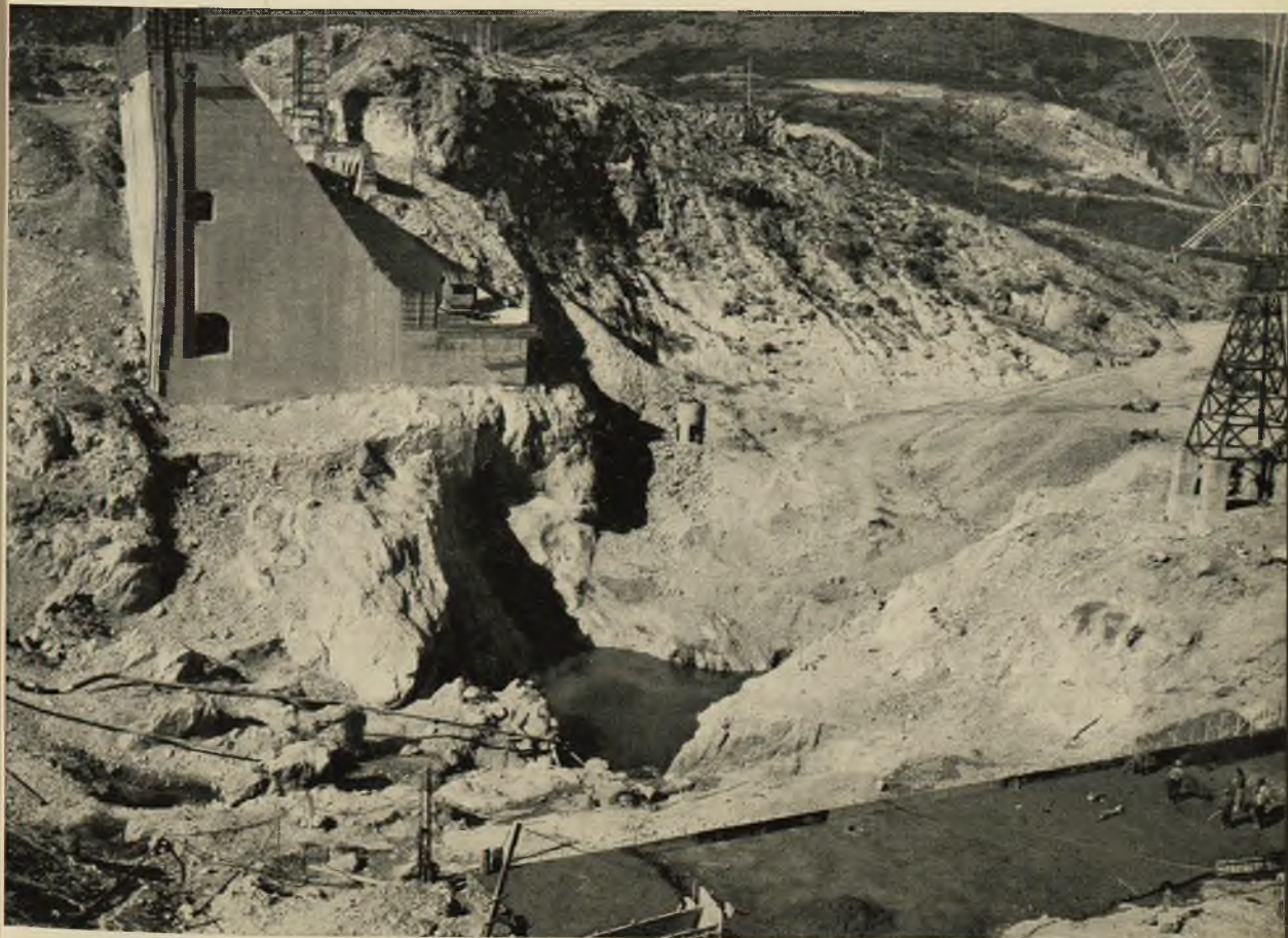
Fot. 33 - Serbatoio di Macheronis sul Posada (Sardegna) : Marmitta di erosione.
