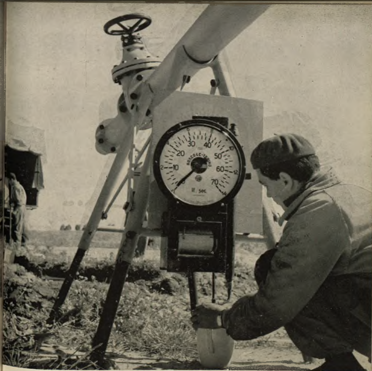
Fot. 8 - Venturimetro per misure di portata.
