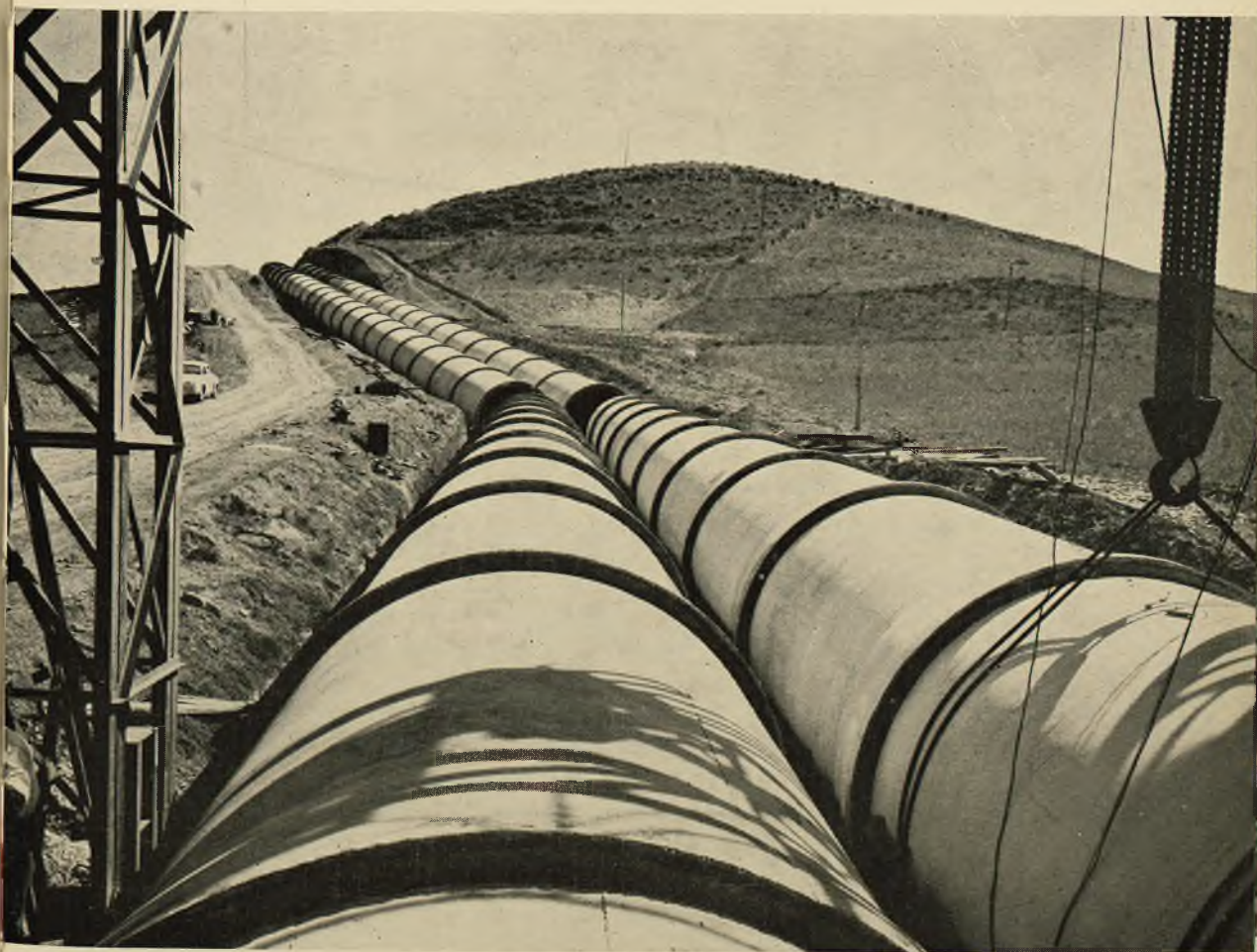
Fot. 5 - Sifone e attraversamento del Rio Bau. Schema medio Flumendosa (Sardegna).
