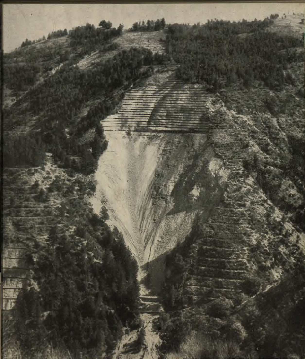
Fot. 49 - Cosenza - BM Trionto. Sistemazione della frana Caprice: Lavori in corso.
