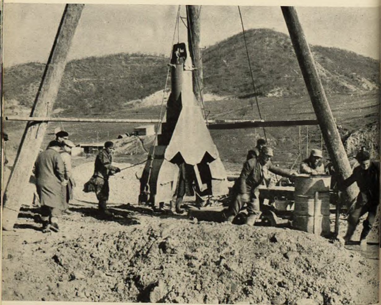
Fot. 45 - Sbarramento di San Pietro sull'Osgento (Campania): Benna per lo scavo della paratia in calcestruzzo.
