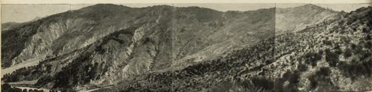
Fot. 6 - Teramo - Sistemazione zone precalanive in Comune di Atri: Opere in alveo coordinate con opere estensive di rimboscimento.
