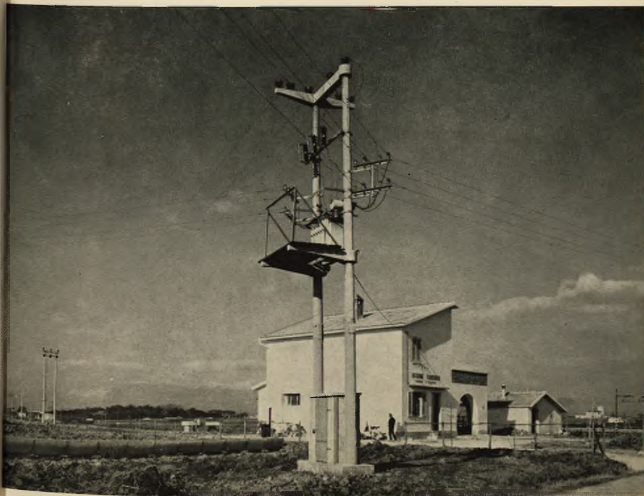
Fot. 6 - Cabine di trasformazione da palo per elettrificazione « zone di riforma ».
