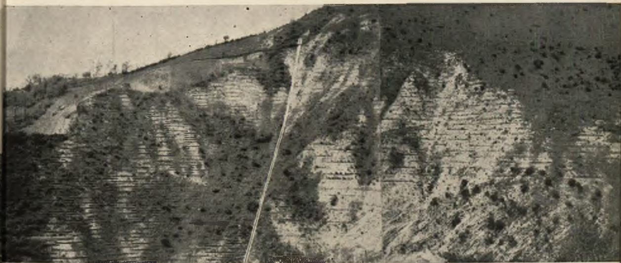
Fot. 51 - Foggia - BM Cervaro: Sistemazione pendici franose.
