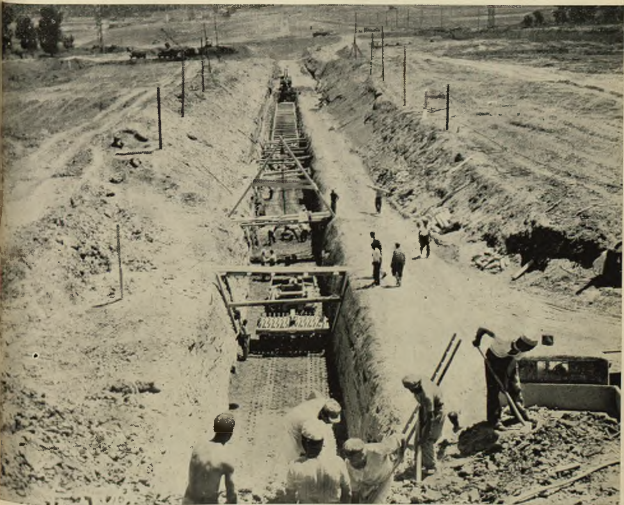
Fot. 13 - Serbatoio di Abate Alonia sul Rendina (Puglia): La diga ultimata. Fot. 14 - Serbatoio di Abate Alonia sul Rendina (Puglia): Compattamento del taglione.
