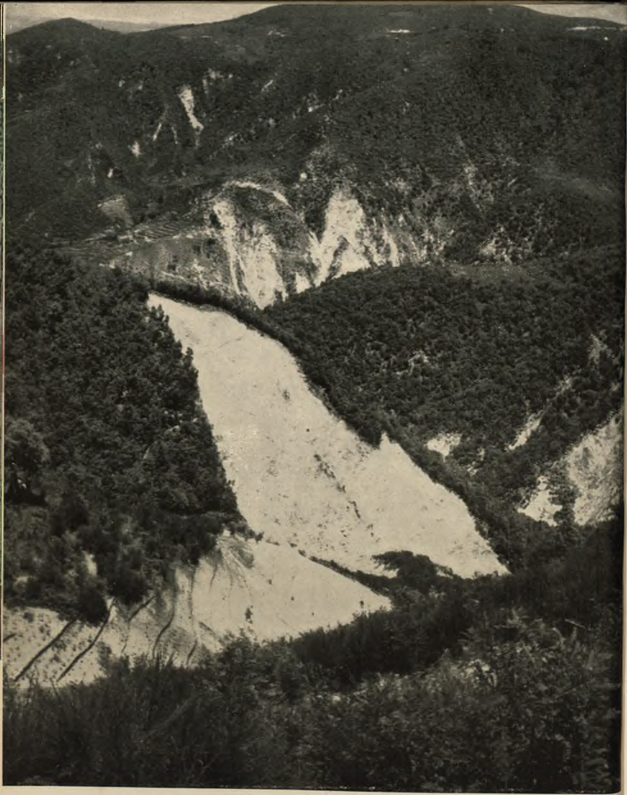
Fot. 40 - Reggio Calabria - BM Mesima. Sistemazione della frana dell'Omo Morto: Lavori in corso.
