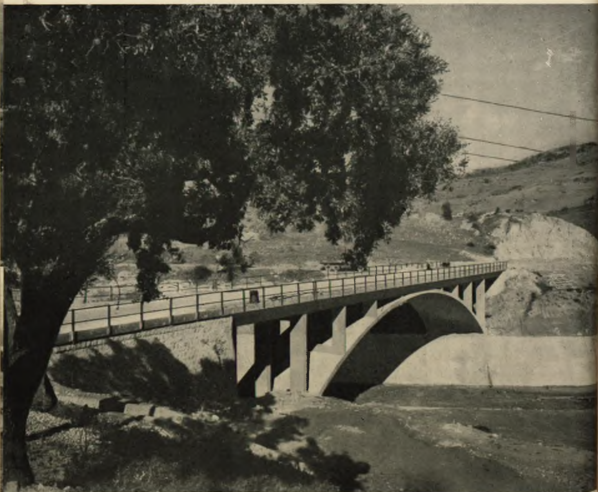
Fot. 109 - Agrigento: Lavori di costruzione della variante alla SS. 118 Corleonese Agrigentina in dipendenza della formazione del serbatoio sul fiume Eleuterio per l'acquedotto di Palermo in località Madonna delle Grazie. Ponte in c. a. sul canale di scarico del serbatoio.
