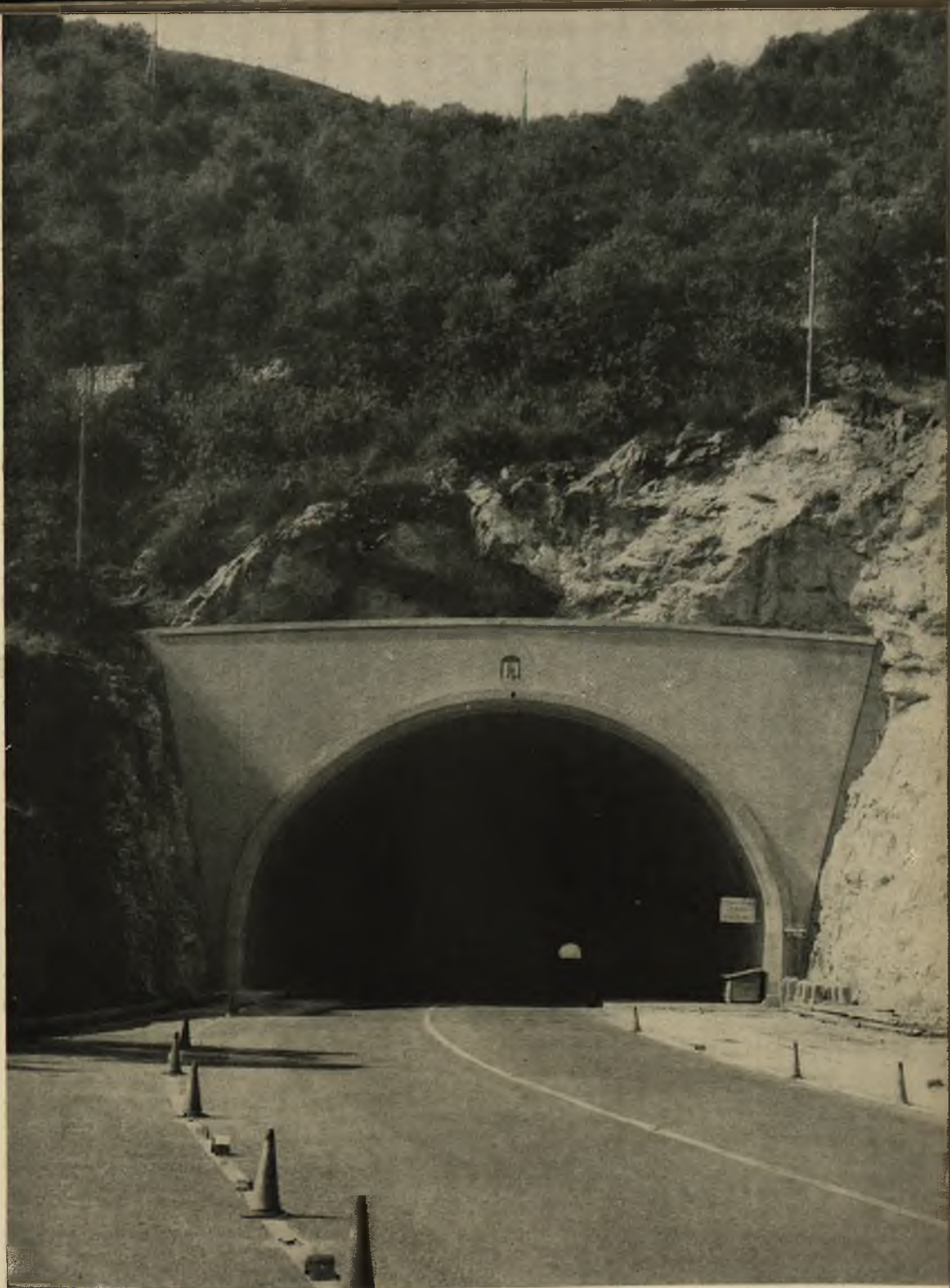
Fot. 7 - Campobasso: Costruzione variante alla strada provinciale 28 Nunziata Lunga. Galleria sotto il valico appenninico delle Tre Torri.
