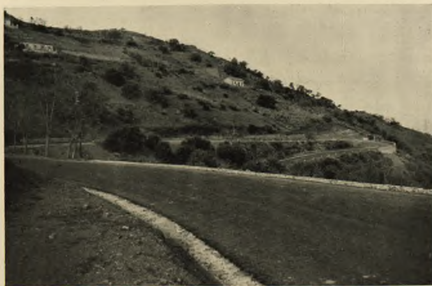
Fot. 101 - Palermo: Costruzione strada San Mauro-Gangi. Veduta dei ponti sui valloni S. Pietro e Tiberio (sullo sfondo).
