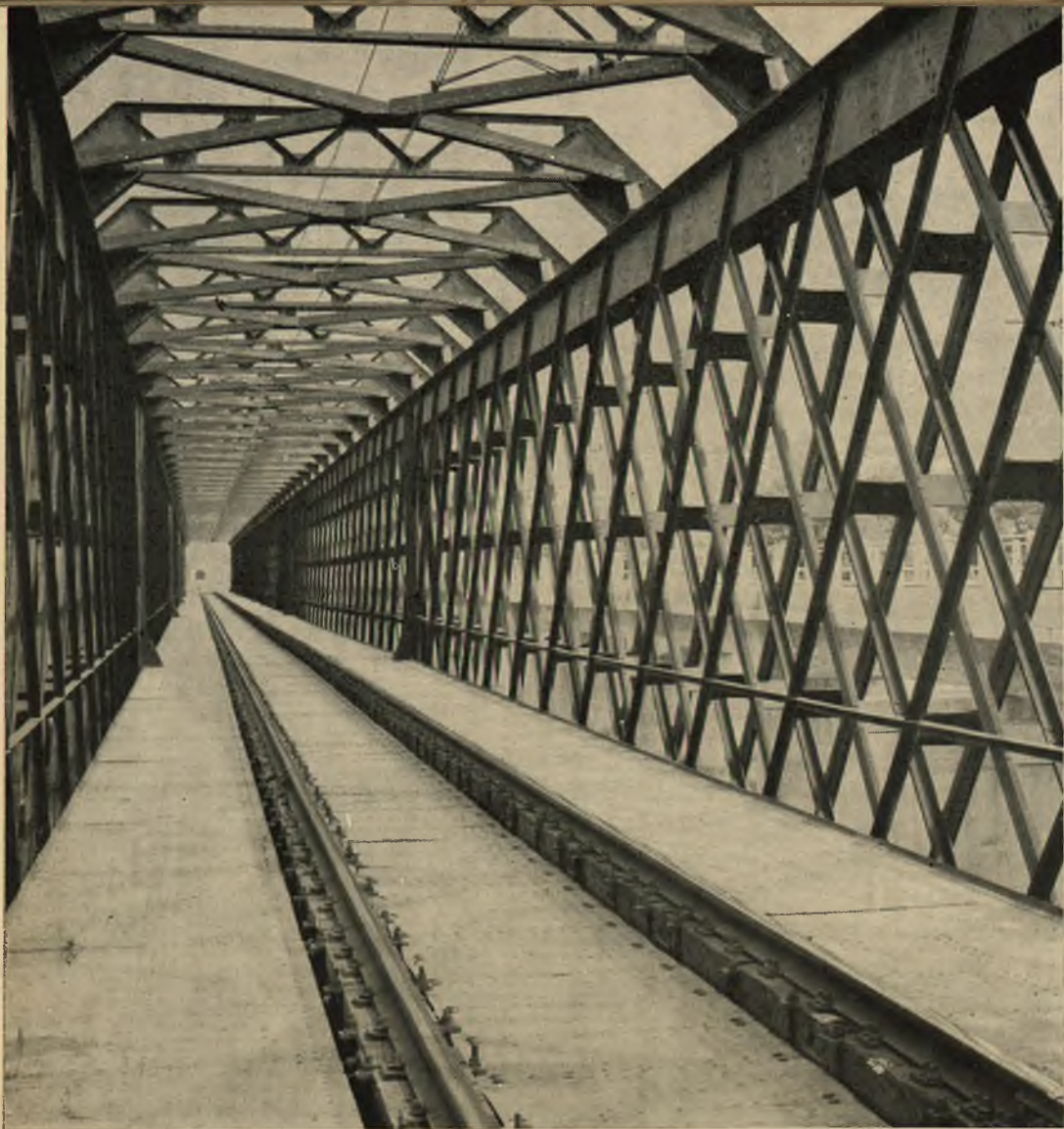
Fot. 4 - Linea Battipaglia-Reggio Calabria : Viadotto di Castrocecco (Foto F.S.).
