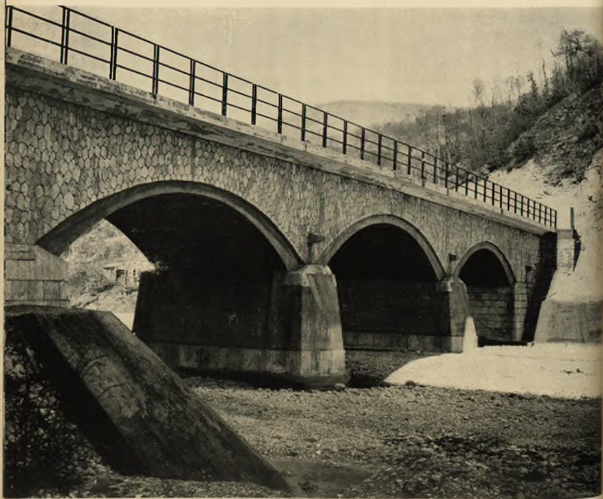
Fot. 38 - Rieti: Costruzione ponte sul torrente Corno sulla strada di allacciamento della frazione di Ocre.
