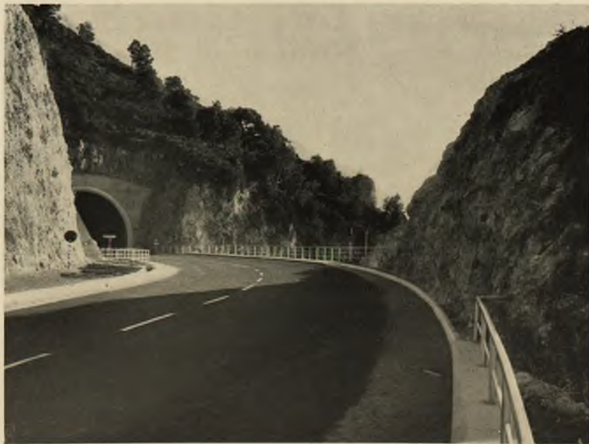
Fot. 29 - Latina: Strada di attraversamento di Formia, 2° lotto. Ponte di accesso alla darsena e viadotto di accesso al centro urbano di Formia. Fot. 30 - Latina: Strada litoranea Terracina-Sperlonga-Gaeta. Il portale Sperlonga della galleria di Capovento.
