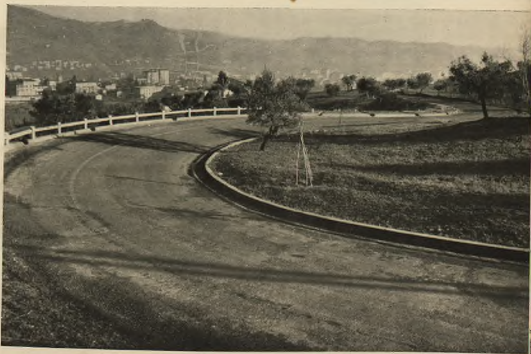
Fot. 23 e 24 - Ascoli Piceno: Sistemazione strada provinciale Colle S. Marco.
