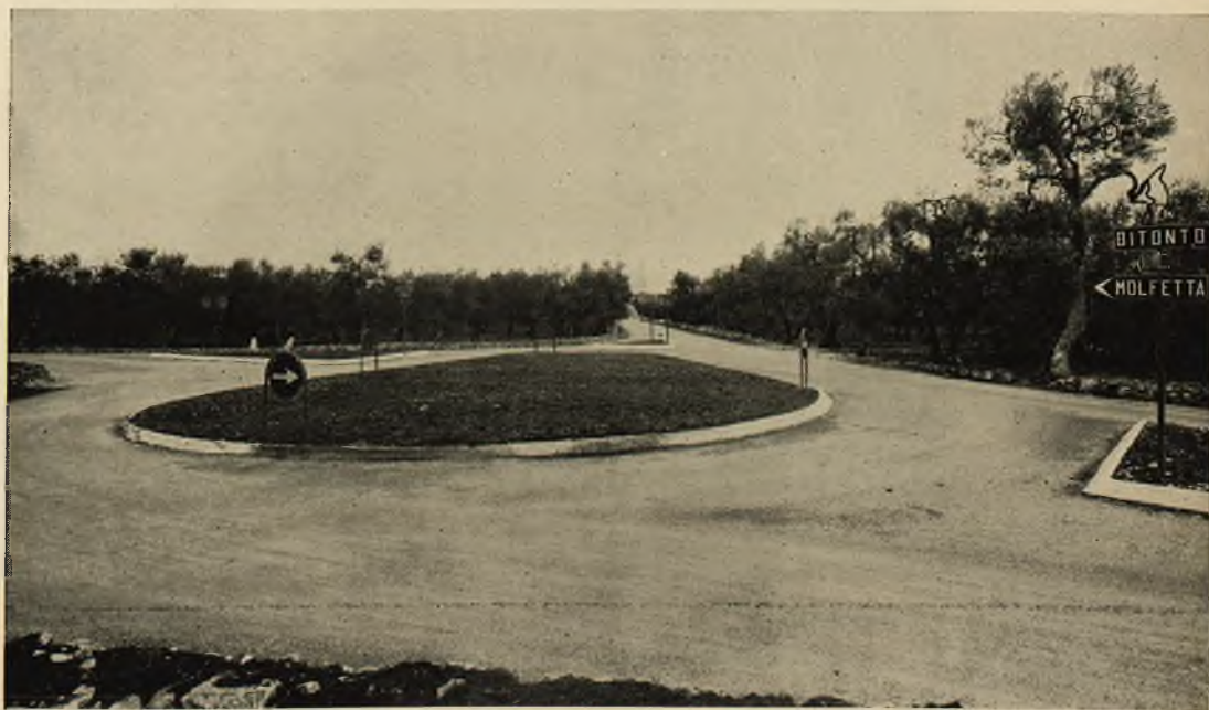
Fot. 77 - Bari: Sistemazione strada Monopoli-Alberobello.
