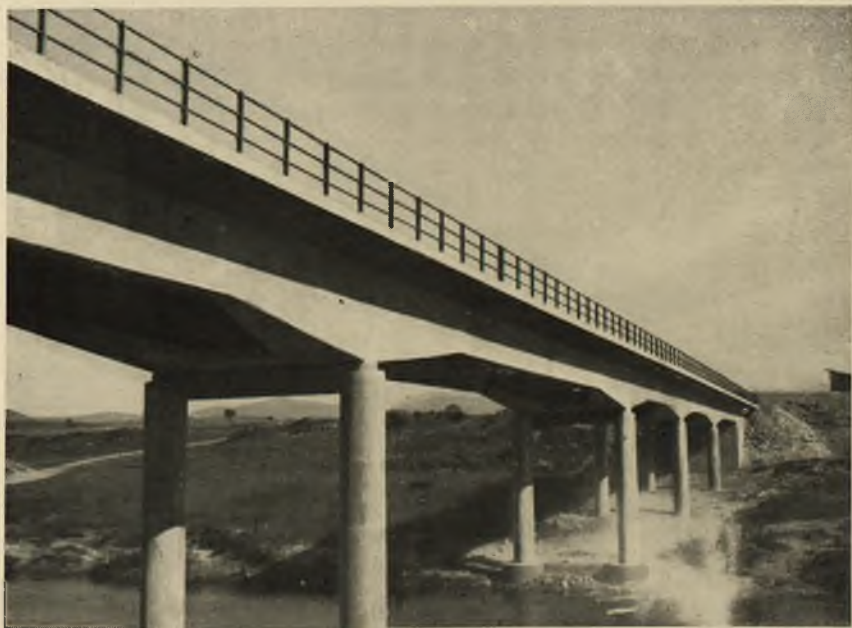
Fot. 122 - Nuoro: Strada sull'Ortobene. Tratti e viste panoramiche. Fot. 123 - Nuoro: Ponte sul Tirso sulla strada Bardosu-Ottana.
