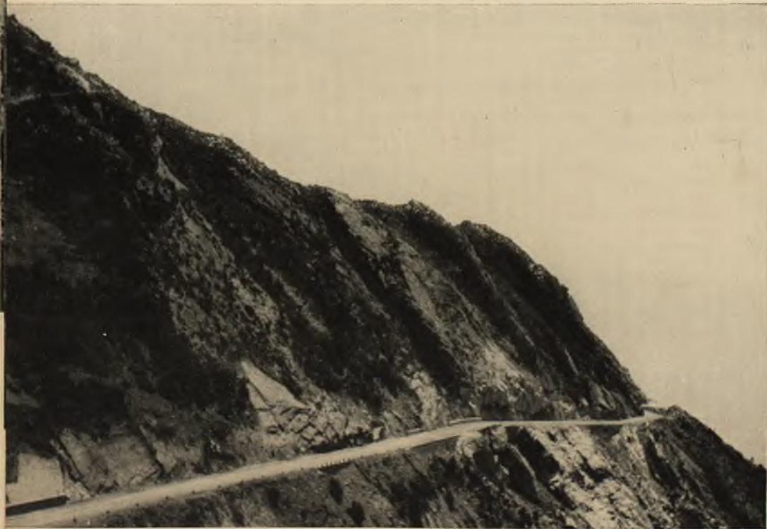
Fot. 42 - Isola d'Elba: Strada provinciale Marciana Marina-Procchio, 1° tratto. Località Le Sprizze.
