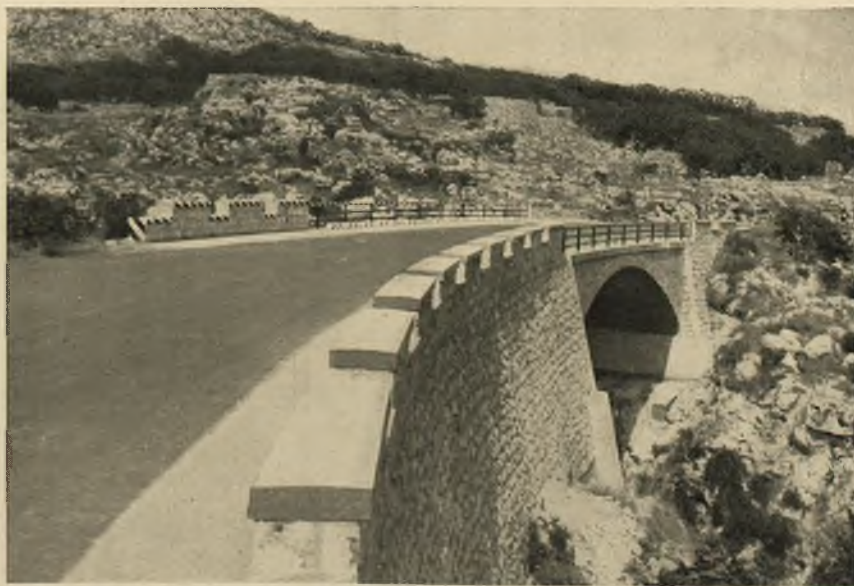
Fot. 64 - Lecce: Costruzione strada litoranea di Siponto.
