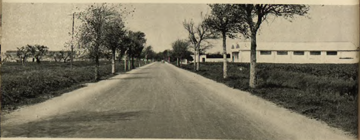
Fot. 71 - Foggia : Strada provinciale Ascoli Satriano-Candela. Fot. 72 - Foggia : Strada provinciale Borgo Celano-SS. 89.
