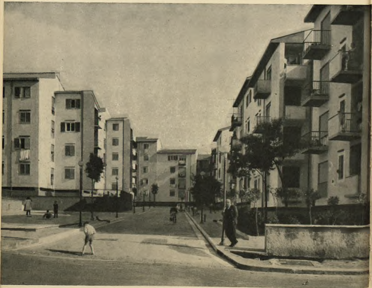
Fot. 2 - Cassa per il Mezzogiorno - Legge per Napoli: Costruzione case popolari a S. Giacomo dei Capri. Complesso di isolati.
