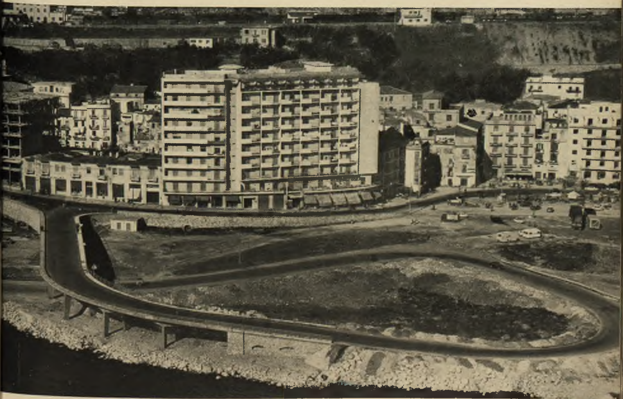
Fot. 36 - Anzio : Costruzione cavalcavia di Padiglione sulla strada Roma-Anzio. Fot. 37 - Latina : Strada di attraversamento di Formia. Tratto Largo Paone.
