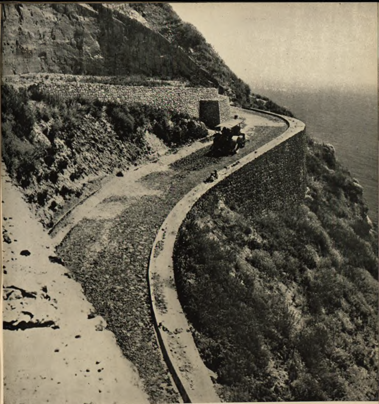
Fot. 59 - Isola d'Ischia (Napoli): Lavori di costruzione della strada Testaccio-Maronti.
