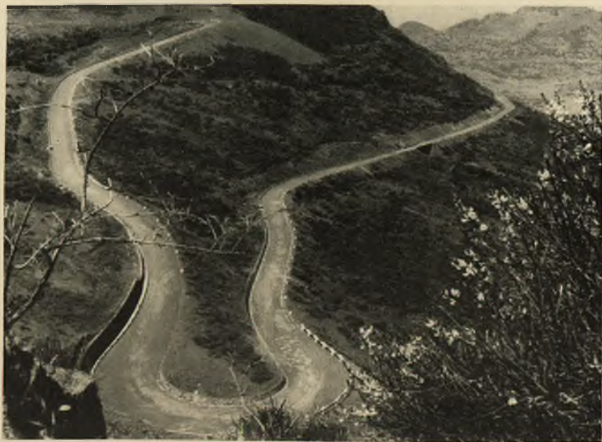
Fot. 115 - Catania: Costruzione strada Scordia-Loddiero-Militello. Fot. 116 - Messina: Costruzione della strada turistica Vulcano Porto-Vulcano Piano. Tornante sulla falda del monte Saraceno.
