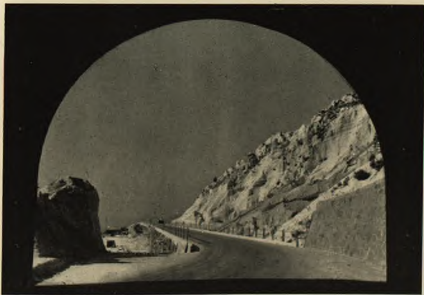
Fot. 117 - Messina: Costruzione strada litoranea Messina-Faro. Tratto del lato nord Paradiso-Grotta.
