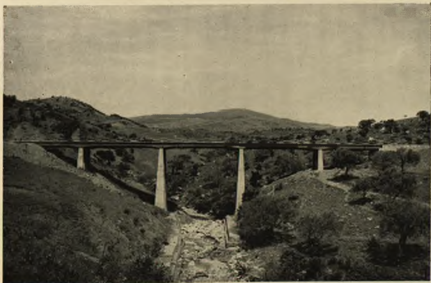
Fot. 99 - Palermo: Costruzione strada turistica di accesso di Solunto. Fot. 100 - Palermo: Strada San Mauro-Gangi e diramazioni. Ponte sul torrente Malia.
