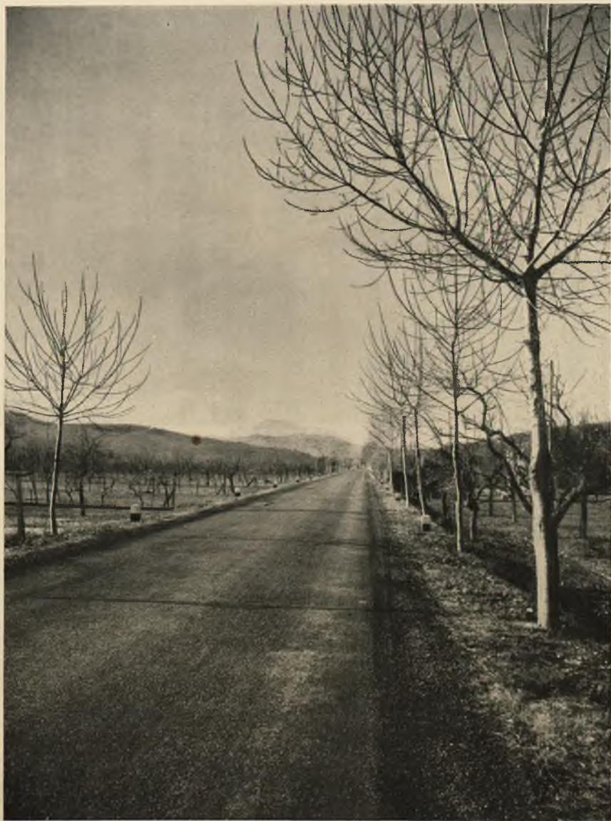
Fot. 25 - Ascoli Piceno : Sistemazione strada Val Tesino.
