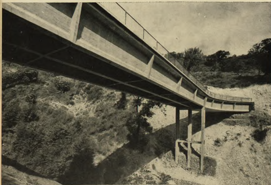
Fot. 90 - Catanzaro: Costruzione strada Gimigliano-Tiriolo. Ponte sul torrente Corace.
