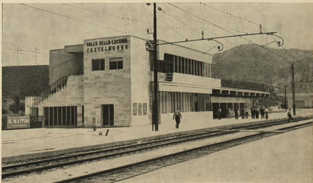
Fot. 8 - Linea Battipaglia-Reggio Calabria: Galleria Condoleo (Foto F.S.). Fot. 9 - Linea Battipaglia-Reggio Calabria: Stazione di Vallo della Lucania (Foto F.S.)
