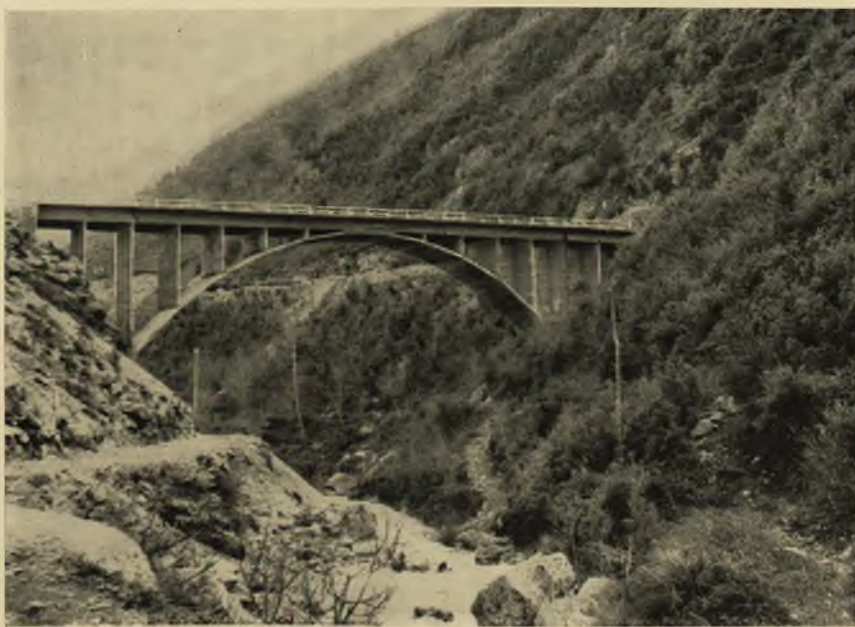
Fot. 94 - Cosenza : Strada Mantadoriccio-Casello Monzagna. Ponte sul Gavuco. Fot. 95 - Cosenza : Costruzione strada S. Sosti-Pettoruto. Ponte sul torrente Rose.
