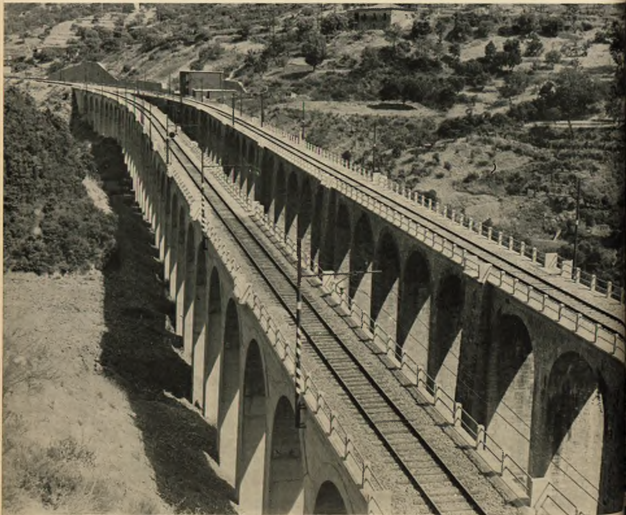
Fot. 2 - Linea Battipaglia-Reggio Calabria : Viadotto di Valle Cupa (Foto F.S.).
