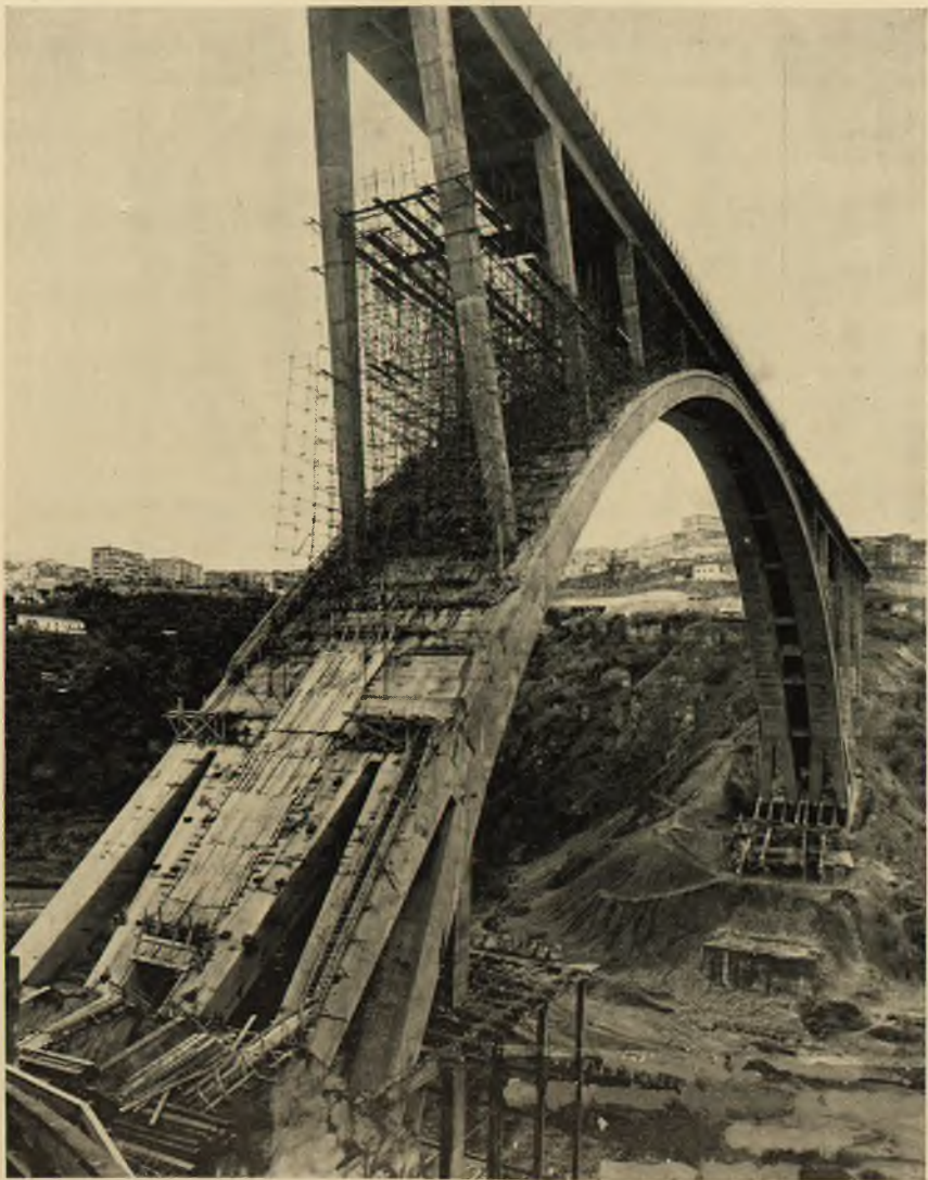
Fot. 87 - Catanzaro: Costruzione viadotto sulla Fiumarella. Fot. 88 - Catanzaro: Veduta dal lato di S. Eufemia.
