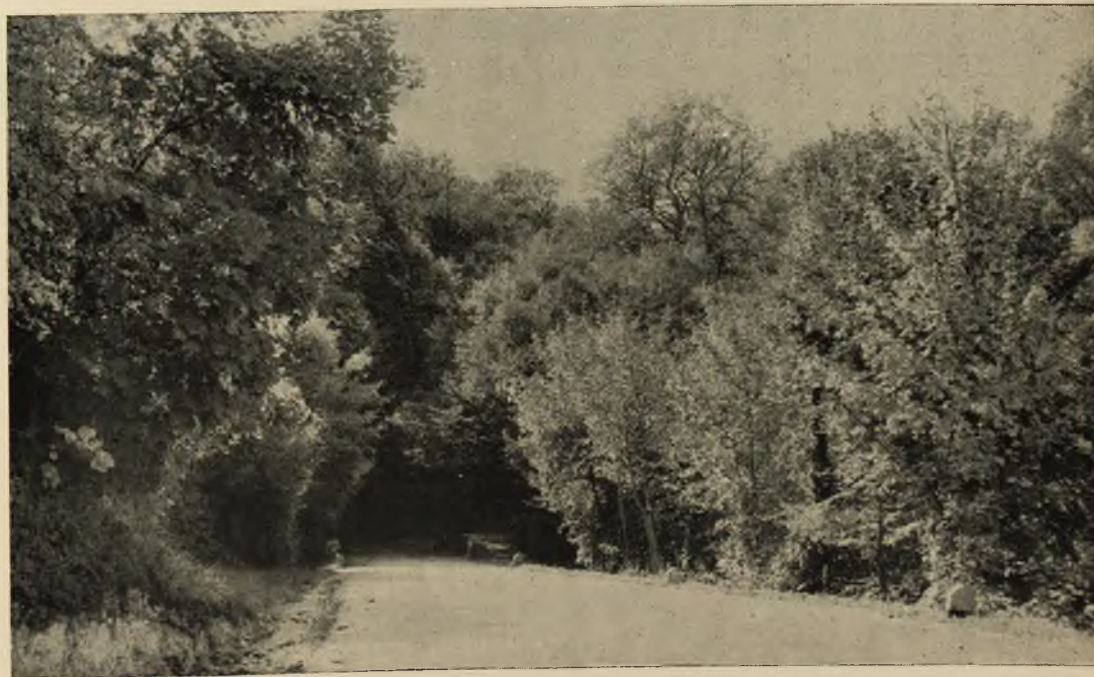
Fot. 69 - Bari : Sistemazione della strada provinciale Castellana-Selva di Fasano. Fot. 70 - Foggia : Attraversamento Foresta Umbra.
