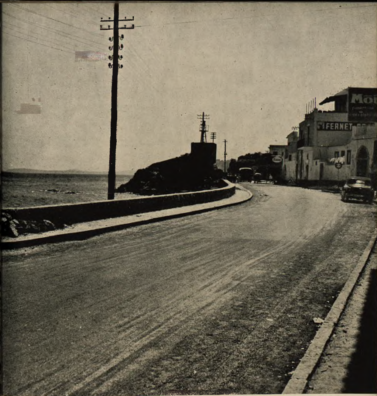
Fot. 61 - Isola d'Ischia (Napoli): Lavori di allargamento della strada Lacco- Forio. Tratto piazza Girardi-piazza S. Restituta.
