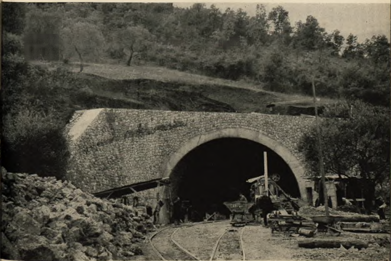
Fot. 53 - Salerno: Costruzione strada e ponte S. Cono-Vietri di Potenza. Galleria Serroni.
