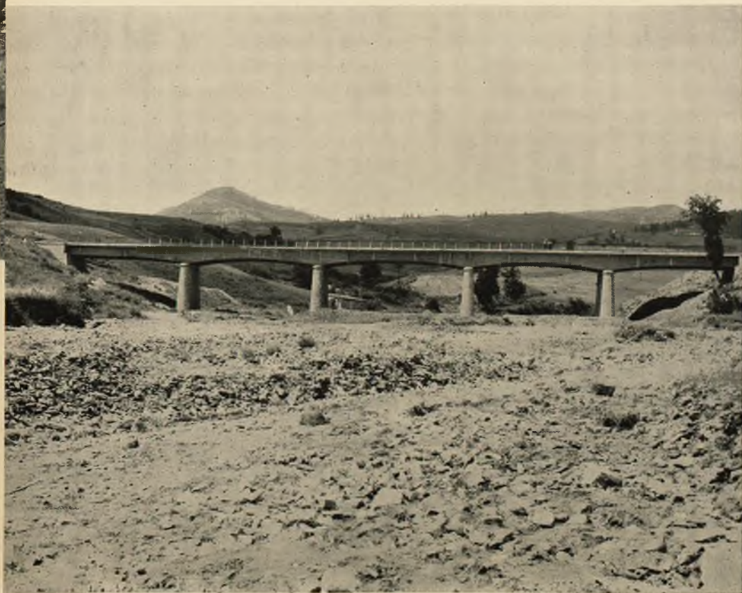
Fot. 86 - Potenza: Strada Bella-S. Cataldo. Ponte sul torrente Merdarulo.
