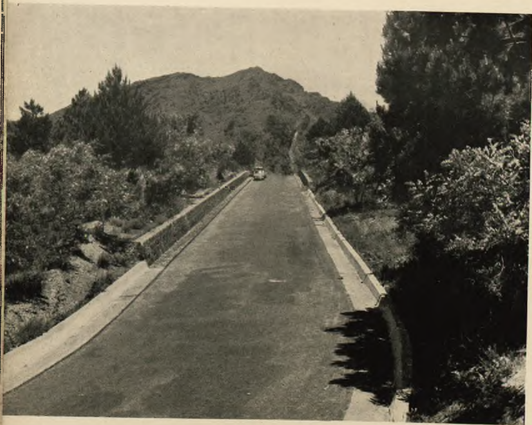
Fot. 58 - Napoli: Lavori di costruzione della strada di accesso al Vesuvio. Tronco dal bivio Colle Umberto alla stazione superiore della seggiovia.
