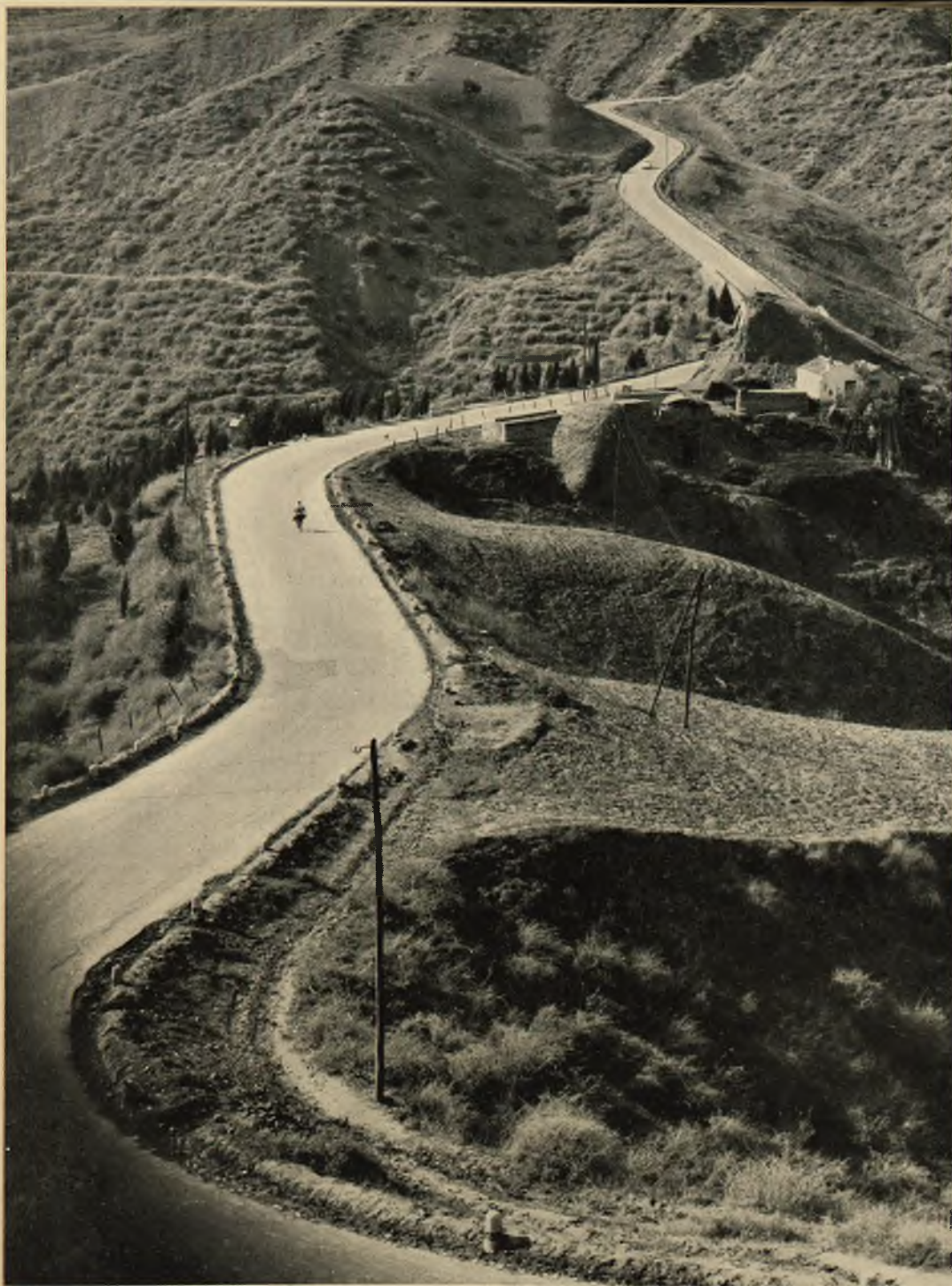
Fot. 80 - Matera: Lavori di costruzione della strada provinciale Pistocci-S. Basilio.
