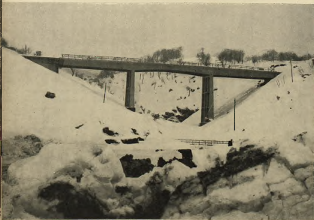
Fot. 11 - Pescara: Completamento variante strada provinciale con costruzione di ponte in c. a. sul Fosso S. Elia. Lavori in corso.
