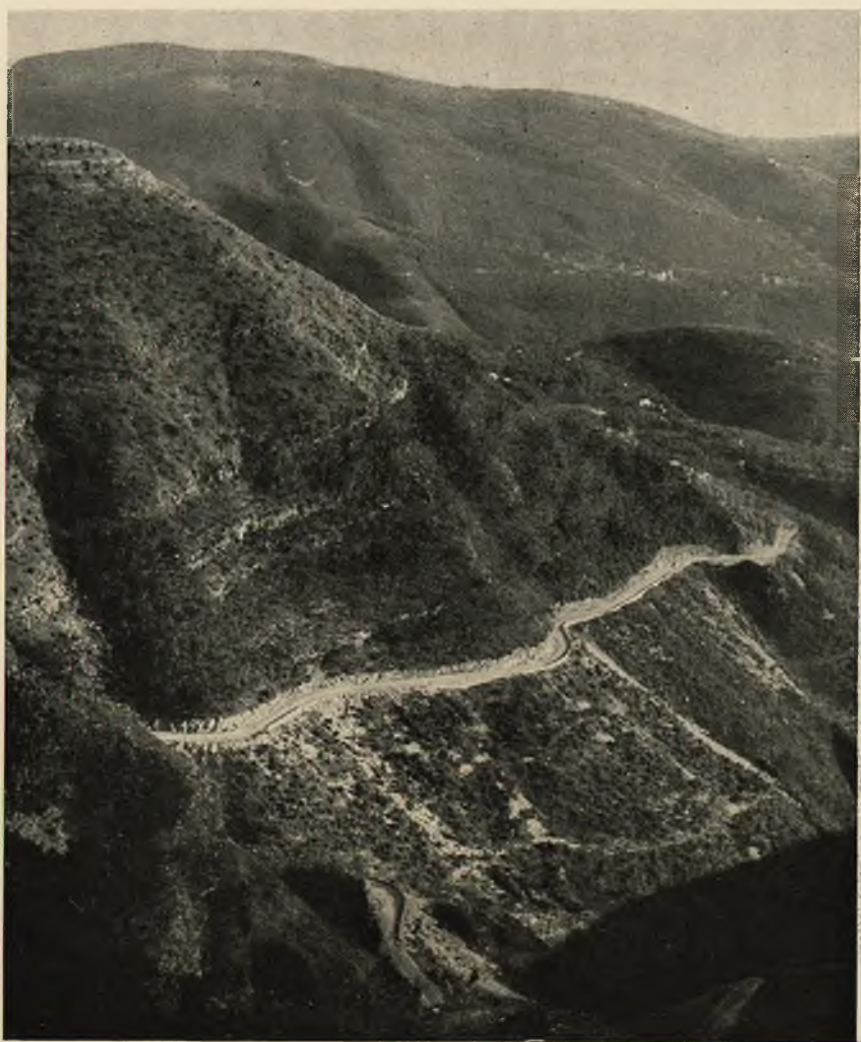
Fot. 56 - Napoli: Lavori di costruzione della strada provinciale Moiano-Faito.
