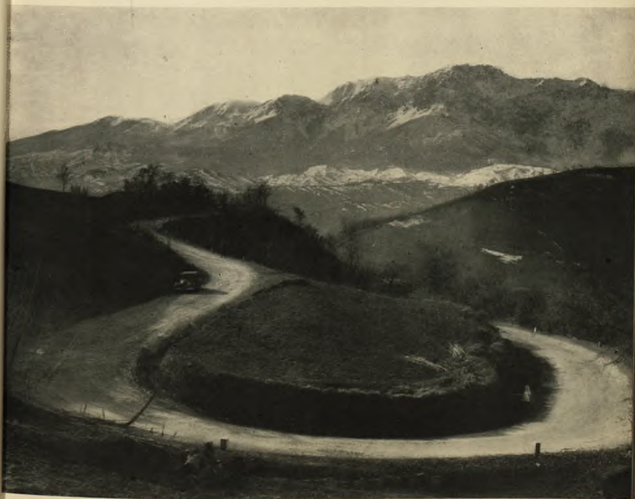
Fot. 20 - Teramo: Sistemazione e pavimentazione della strada provinciale Ponte Vomano-Bisenti.
