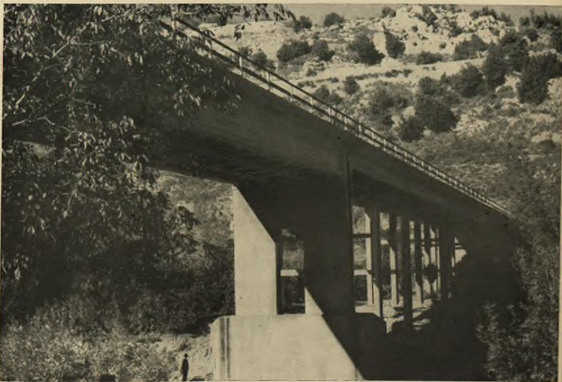
Fot. 113 - Siracusa : Lavori di sistemazione della strada provinciale S. Alessandra-Rosolini.
