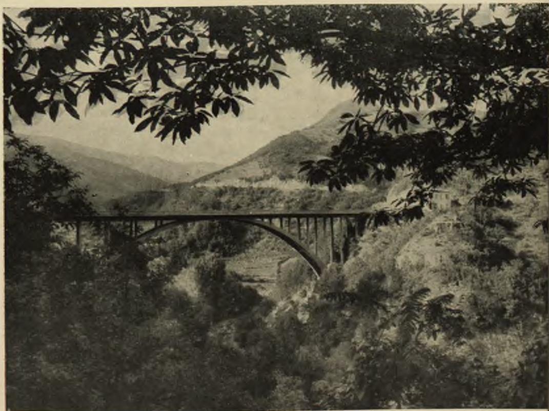
Fot. 17 - Teramo: Costruzione ponte sul Tordino sulla strada comunale stazione di Mosciano-Morrodoro.
