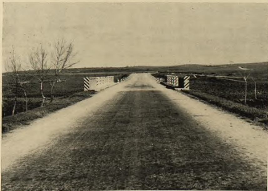
Fot. 84 - Potenza: Sistemazione strada provinciale Venosina Appula dall'innesto SS. 93, presso la stazione di Rapolla, al ponte sul torrente Basentello. Fot. 85 - Potenza: Allargamento della sede stradale e del ponte sul torrente Basentello.
