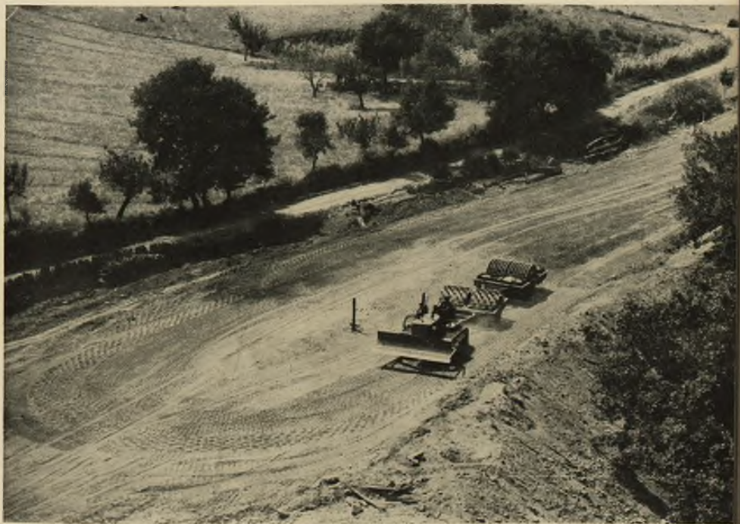
Fot. 9 - Campobasso: Costruzione strada fondovalle del fiume Tappino.
