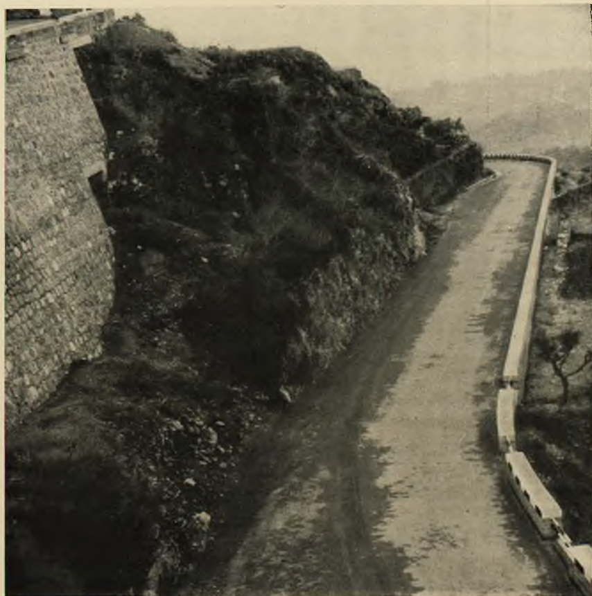
Fot. 82 - Potenza: Lavori di costruzione della strada Roccano-ponte sulla Fiumarella.
