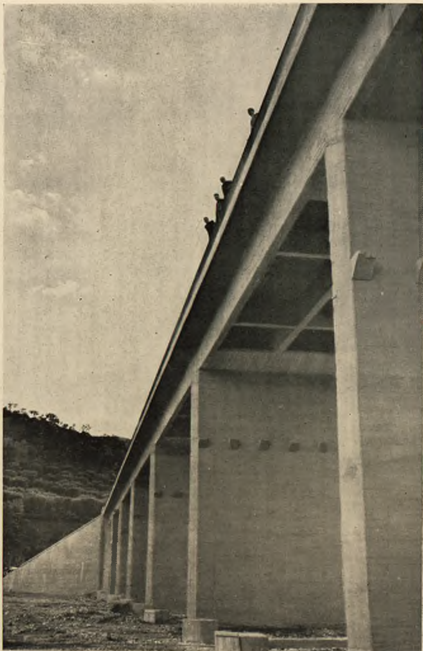
Fot. 54 - Salerno : Ponte sul fiume Bianco a servizio della strada S. Cono-Vietri di Potenza.
