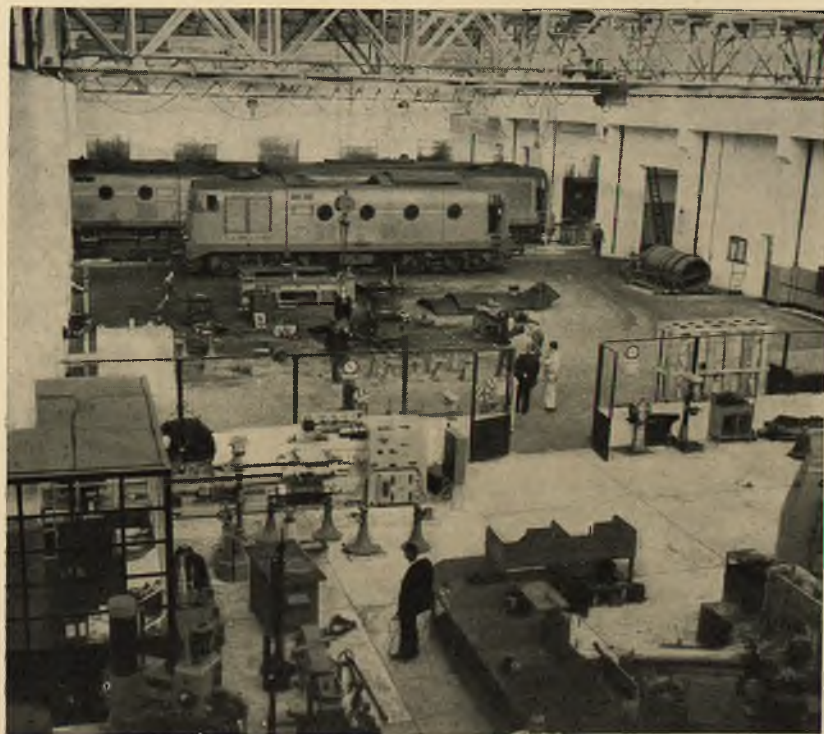
Fot. 16 - Deposito locomotive di Taranto (Foto F.S.).
