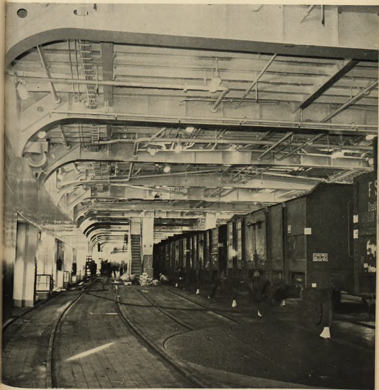
Fot. 22 - Nave traghetti « Tyrsus »: Ponte-binario (Foto F.S.).
