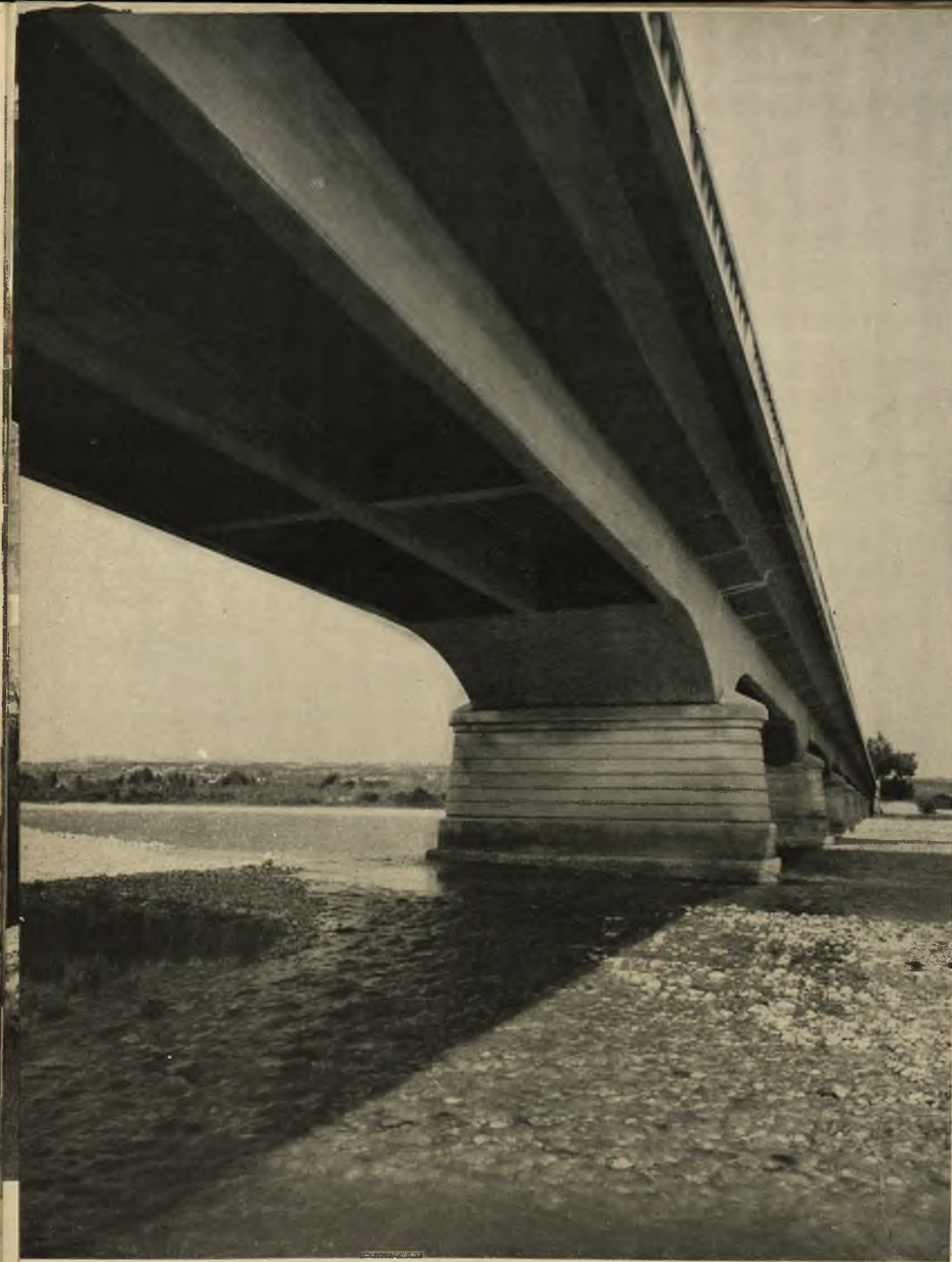
Fot. 19 - Costruzione ponte sul Tordino.
