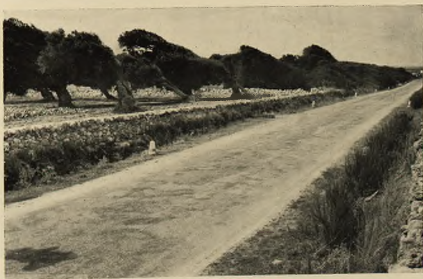
Fot. 73 - Bari: Costruzione della strada Monopoli-Alberobello. Fot. 74 - Bari: Strada Monopoli-Egnatia.
