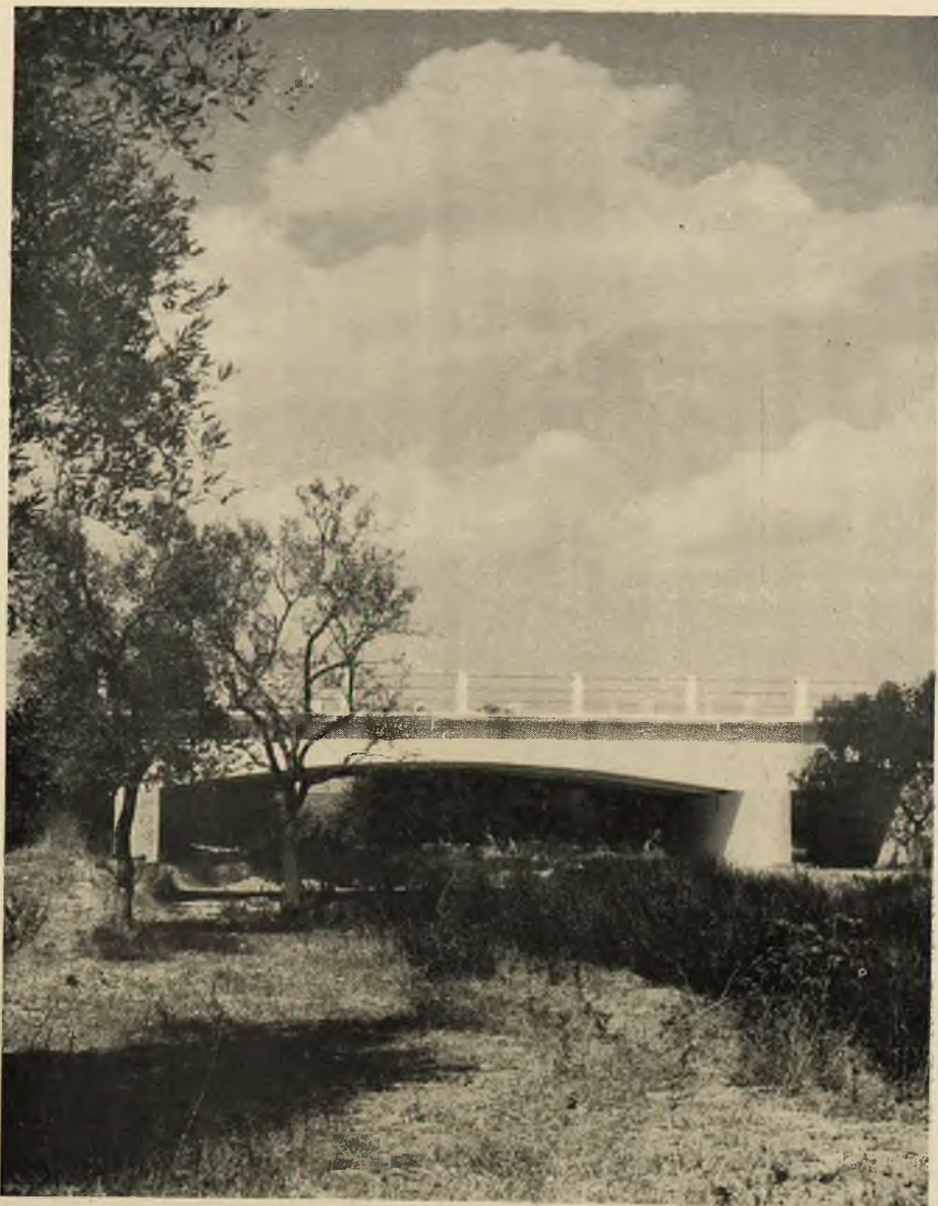
Fot. 79 - Taranto : Sistemazione strada provinciale Grottaglie-Mutata-Orimini.
