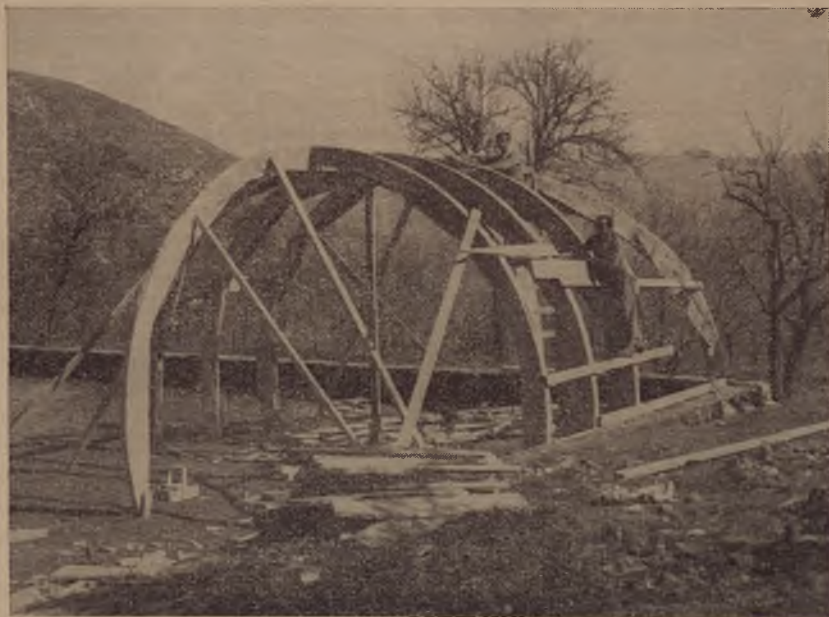
Preparazione di centine per manufatto di sezionamento e scarico.
