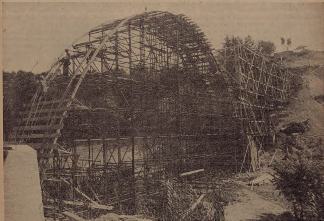
Le opere della « Cassa » in Puglia: Un ponte canale il cui arco centrale ha la luce di circa trenta metri.
