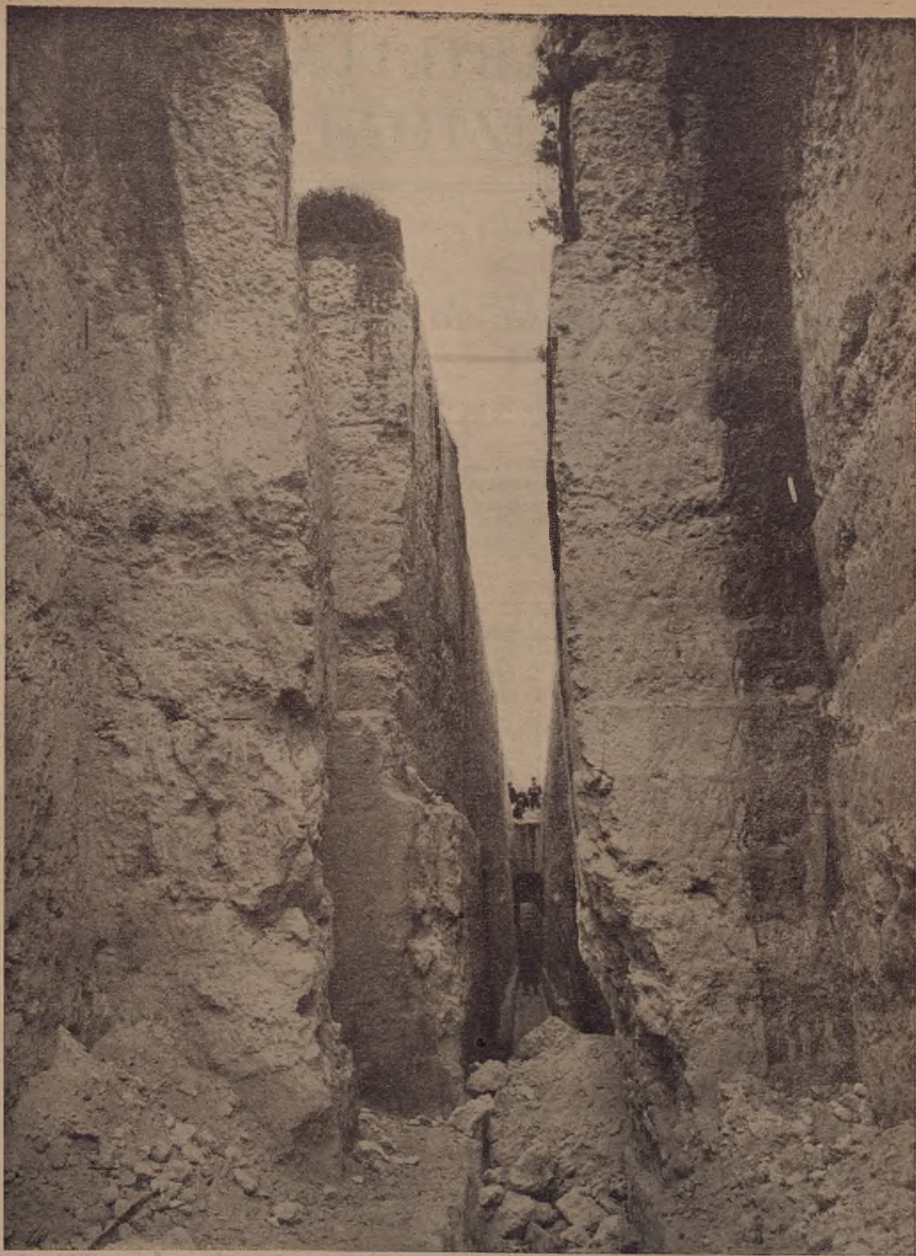
Profondi scavi nella roccia sono spesso necessari per aprire la via alle condutture degli acquedotti.
