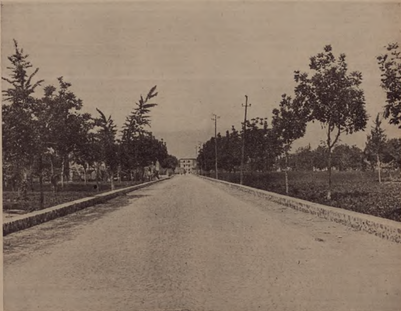
Nuove vie di comunicazione sistemate con pavimentazione di cubetti di porfido.
