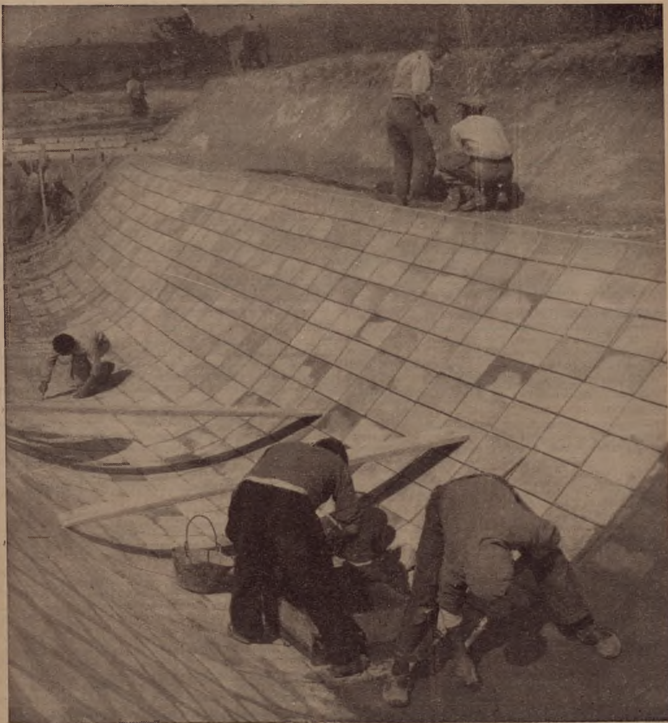
La grande bonifica in Abruzzo: rivestimenti con lastre prefabbricate di un canale sulla sinistra del Pescara.
