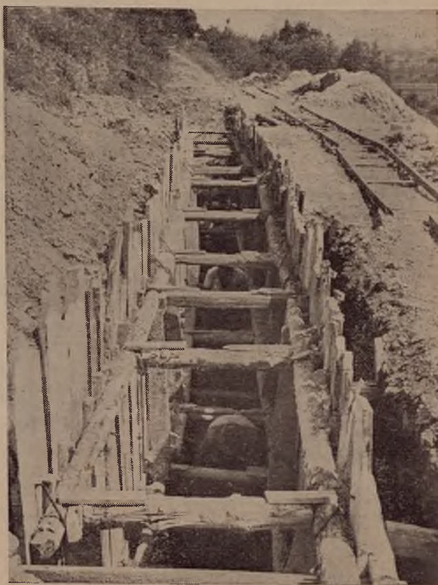
Consolidamento di terreno in frana all'imbocco di una galleria.
