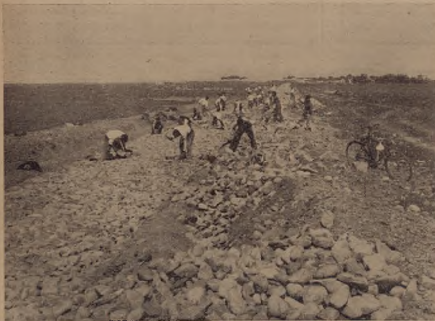
Posa in opera di fondazione massciata.
