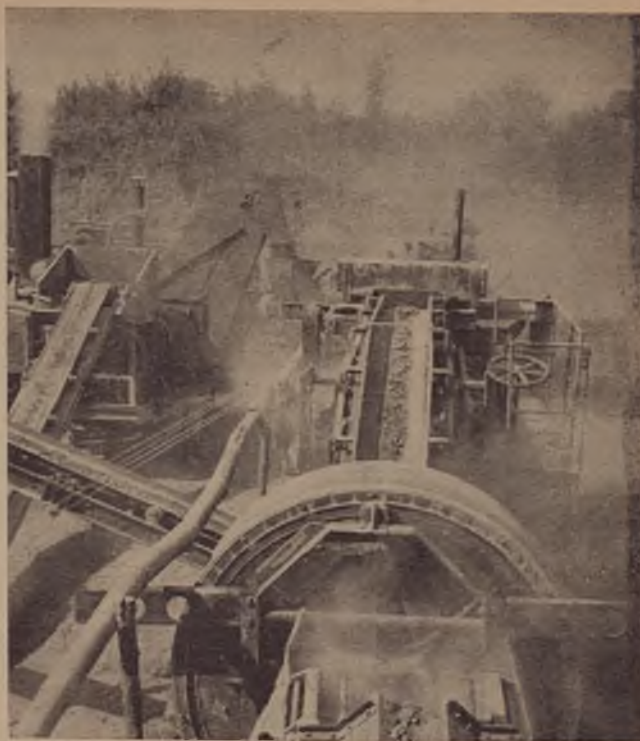
Macchinari per la pavimentazione a tappetini delle strade delle provinciali di Napoli
