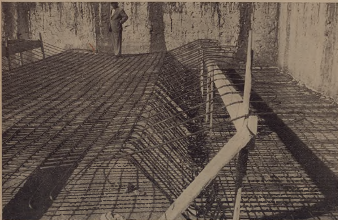
Tonnellate di ferro vengono impiegate nella costruzione dei bacini idraulici.
