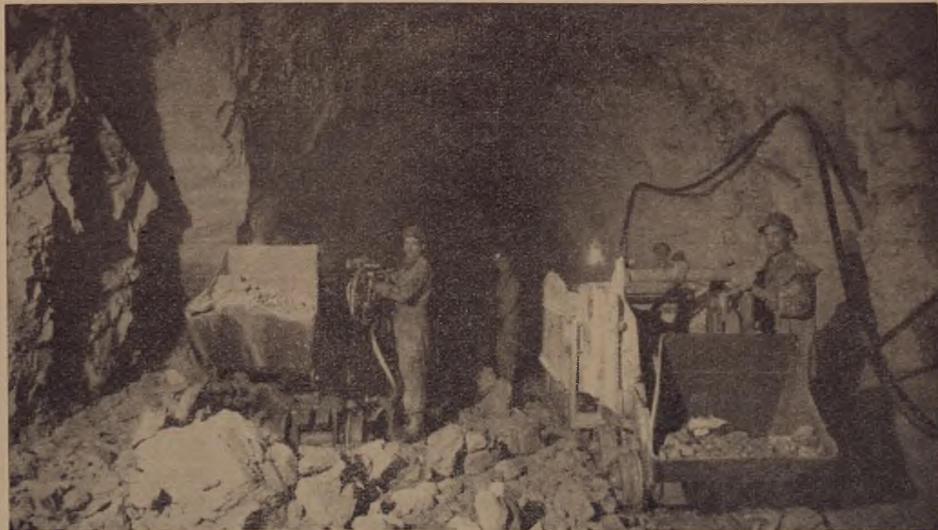
Pale meccaniche in azione nella galleria del Flumendosa in Sardegna.
