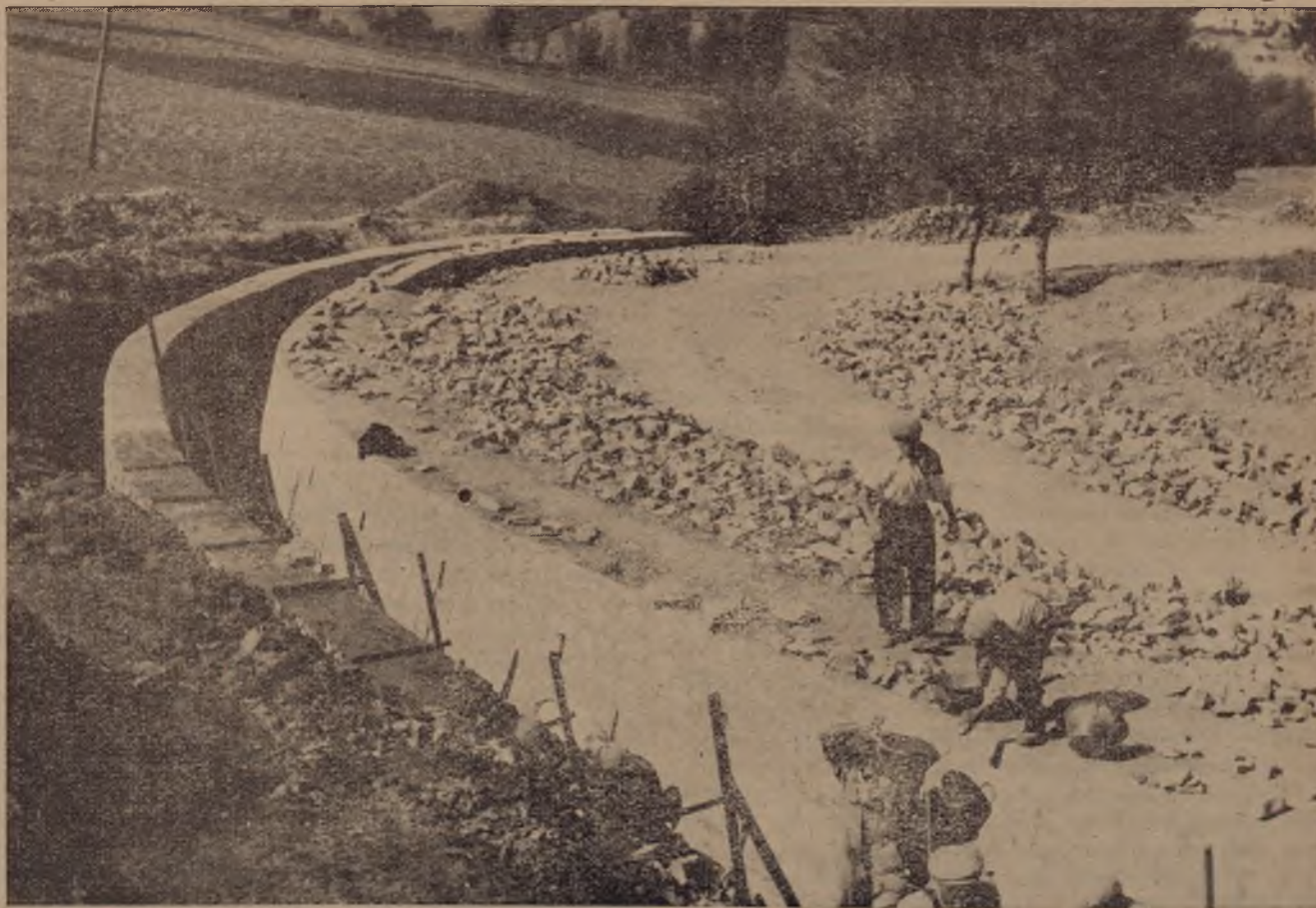
FOGGIA: strada Arzano Scampitello. — Opera d'arte per la sistemazione di un corso d'acqua.
