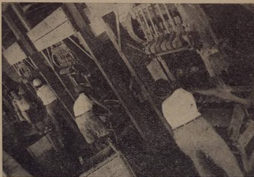
Fabbricazione delle lastre di rivestimento per le opere di irrigazione sul Pescara.
