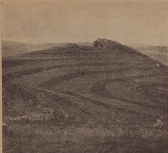
Lavori di sistemazione idraulico - forestale nella valle del Tumarrano.
