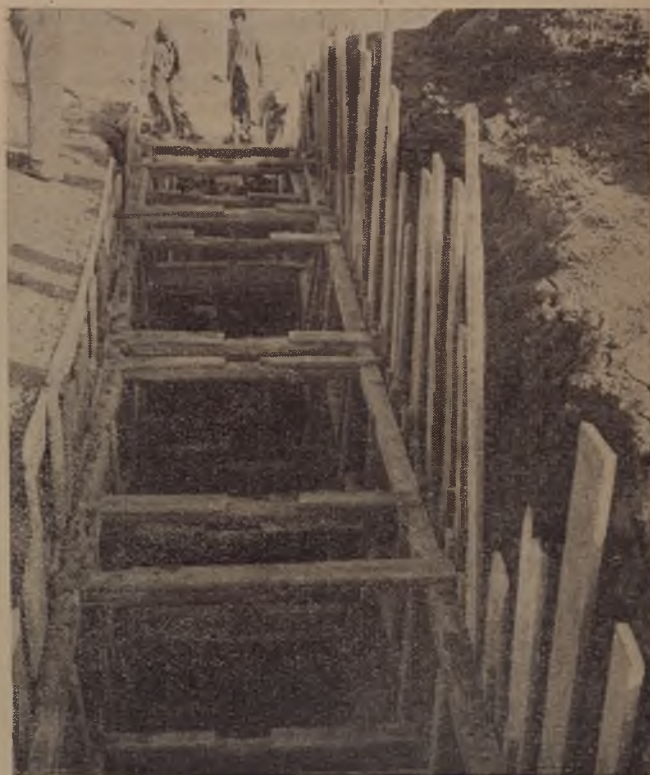
CALTAGIRONE: Strada di bonifica. - Scavi e relative sbadacchiature per la fondazione del muro andatorio a monte della destra del ponte.
