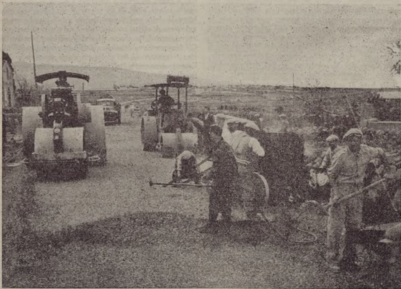
SARDEGNA. — Sistemazione strada Cuglieri-Suni (Prov. Cagliari).
