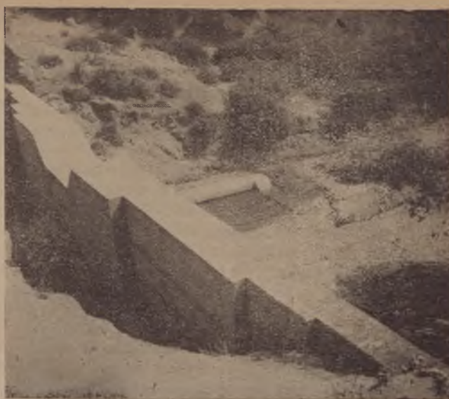
Opere di sistemazione idraulica : una vasca di smorzamento.
