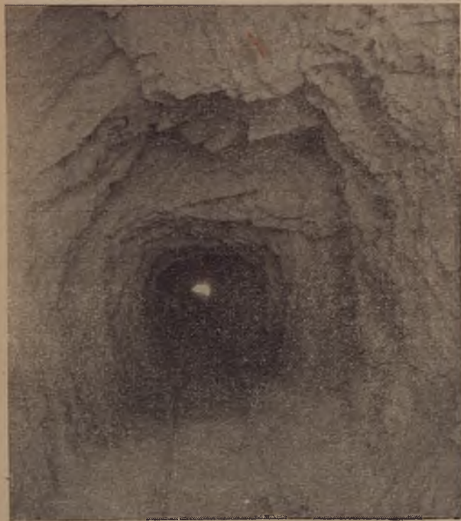
Per sistemare le tubazioni si superano i dislivelli perforando montagne.
