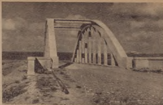
Sistemazione stradale su un torrente.
