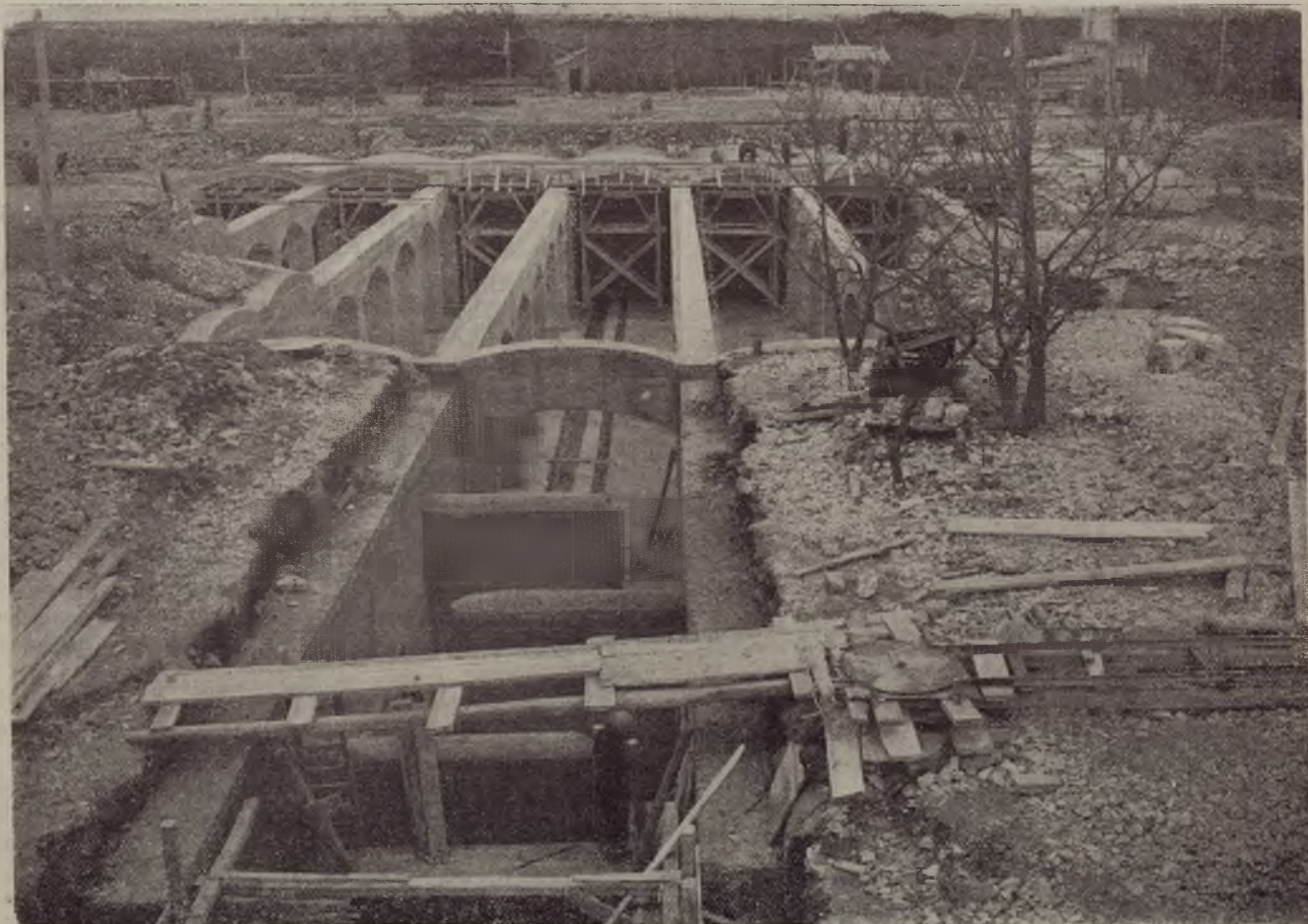
Il nuovo serbatoio in costruzione.
