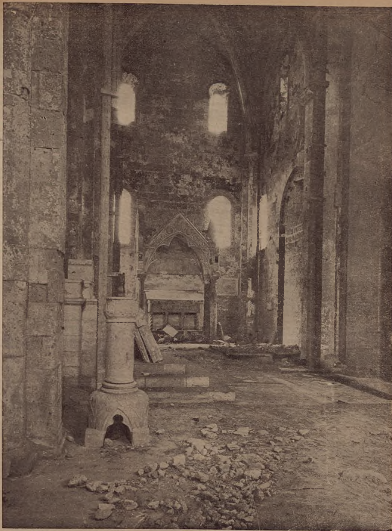
Caserta Vecchia - Interno del transetto della Cattedrale: col contributo della «Cassa» l'edificio sarà consolidato e riportato alla treschezza delle sue linee originarie.
