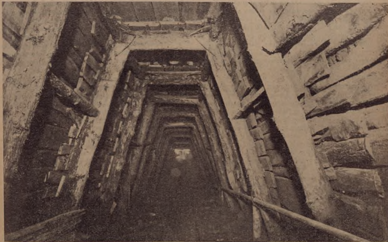
Cunicolo d'avanzamento di una galleria che fa parte di una grande opera di bonifica negli Abruzzi.
