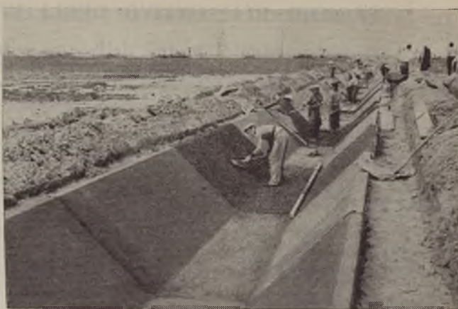
Consorzio di bonifica di Latina: canale di irrigazione
