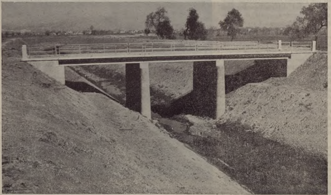
Ponte sulla strada di Quintola per la nuova inalveazione del rivolo d'Auria (Basso Carigliano).
