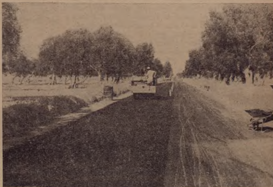
Amministrazione Provinciale di Lecce - Strada Galatone-Galatina. Rullatura del tappetino del conglomerato bituminoso.
