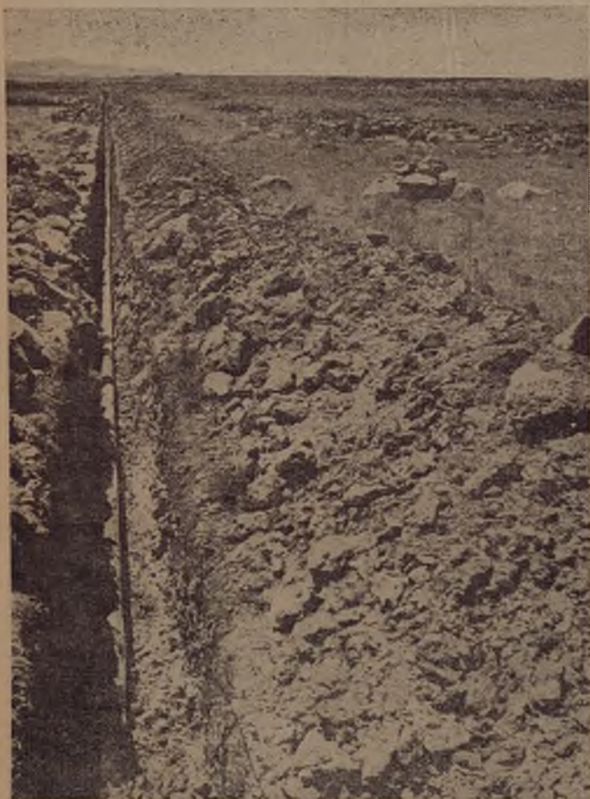
Sistemazione delle condutture per il grande acquedotto del Sarcidano.
