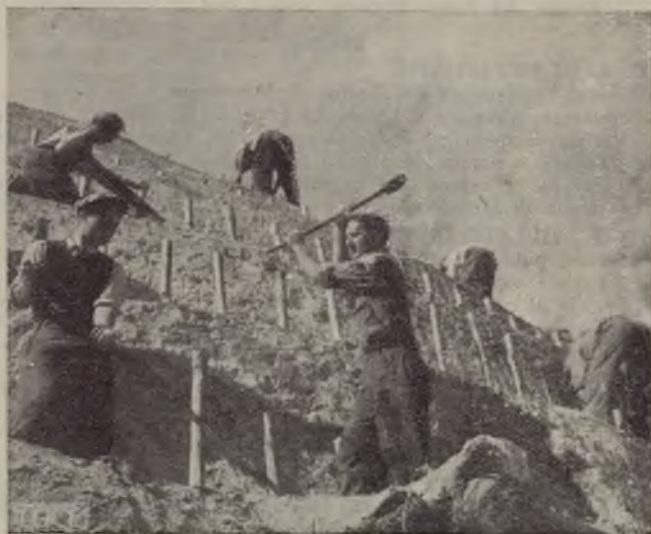
Opere di sistemazione montana.
