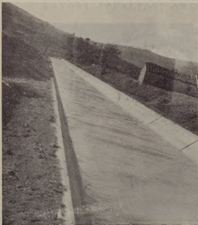
Tratto di canale rivestito, in località Alanno (Consorzi Bonifica - Pescara).
