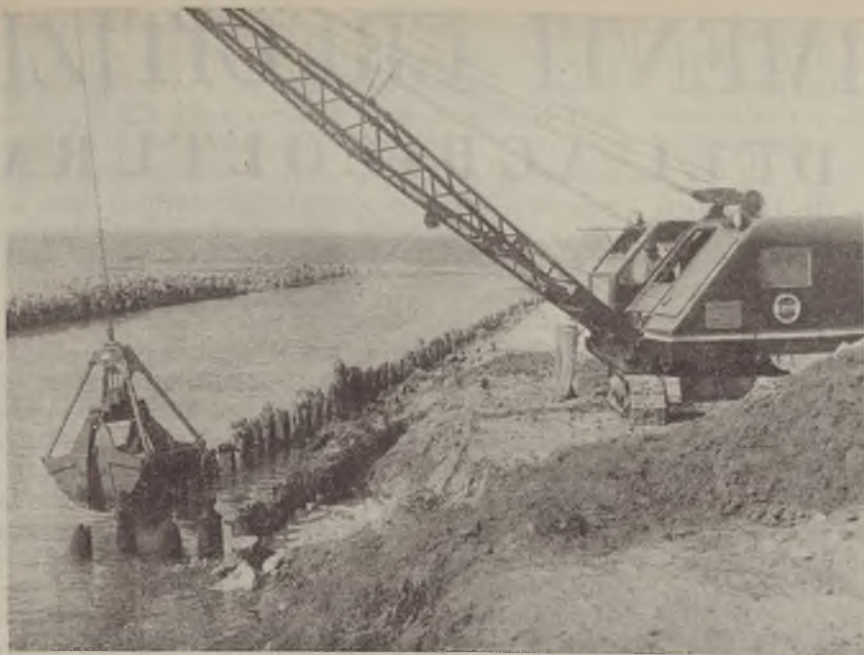
Bonifica del Bacino Inferiore del Volturno: Sistemazione tronco vallivo della R. Agnena (Salpamento della infrastruttura dei vecchi moli).
