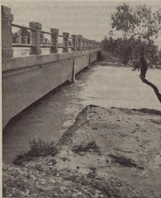
Ponte sul torrente Cervaro.
