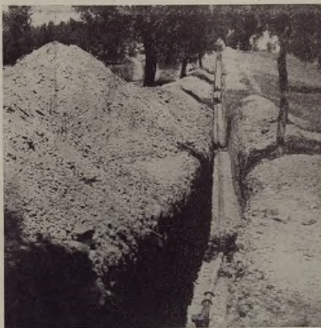
Posa delle tubazioni dell'acquedotto di Pescara.
