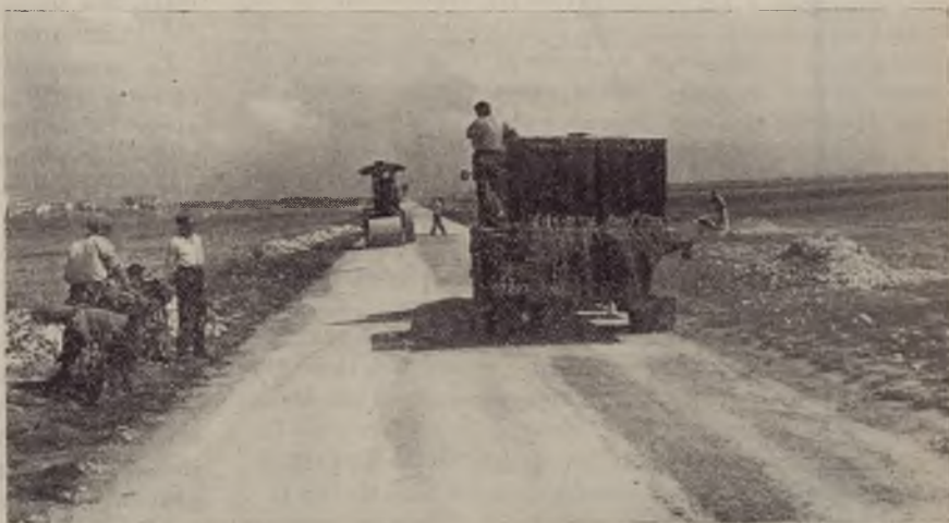
Cilindratura di strada di trasformazione fondiaria in provincia di Foggia.
