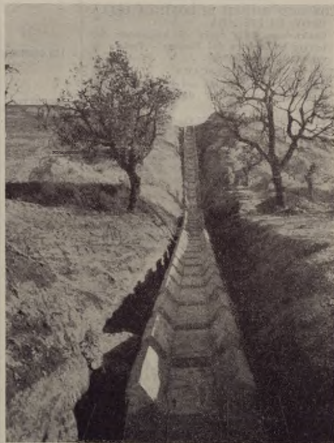
Sifone di attraversamento del torrente "Cigno,, (Pescara) Culle di appoggio della tubazione.
