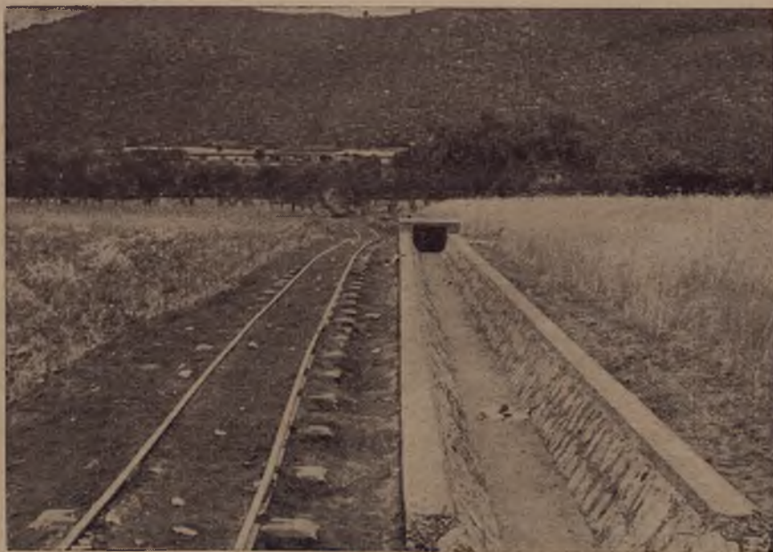
Consorzio Bonifica Piana di Fondi e Monte S. Biagio (Fondi). Tratto di canale principale nell'VIII lotto di irrigazione.
