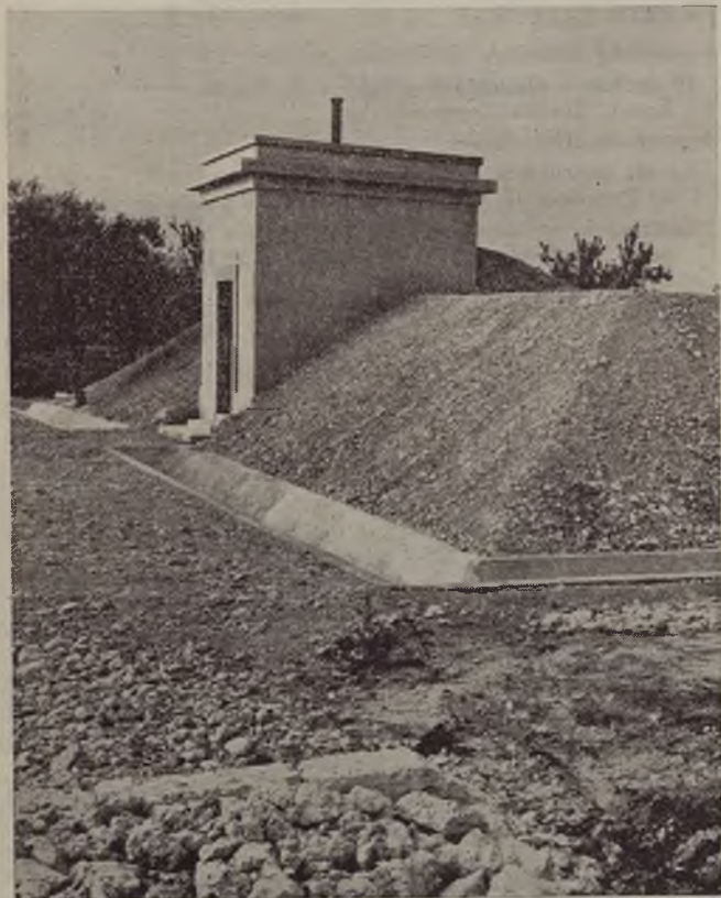
Ente Autonomo Acquedotto Pugliese: serbatoio di riserva di Torre Canne
