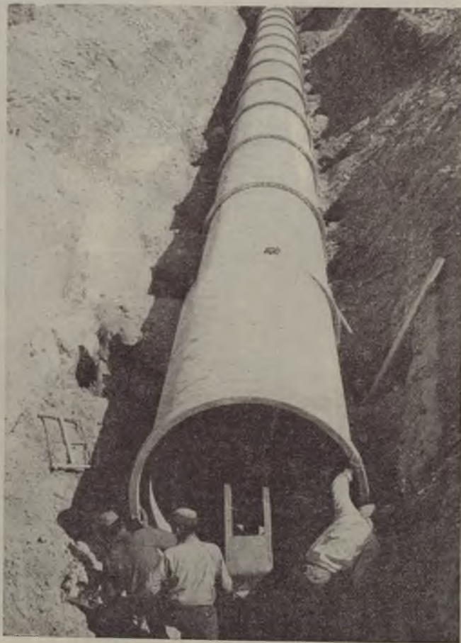
Posa di sifone tubolare per opere d'irrigazione in Abruzzo.
