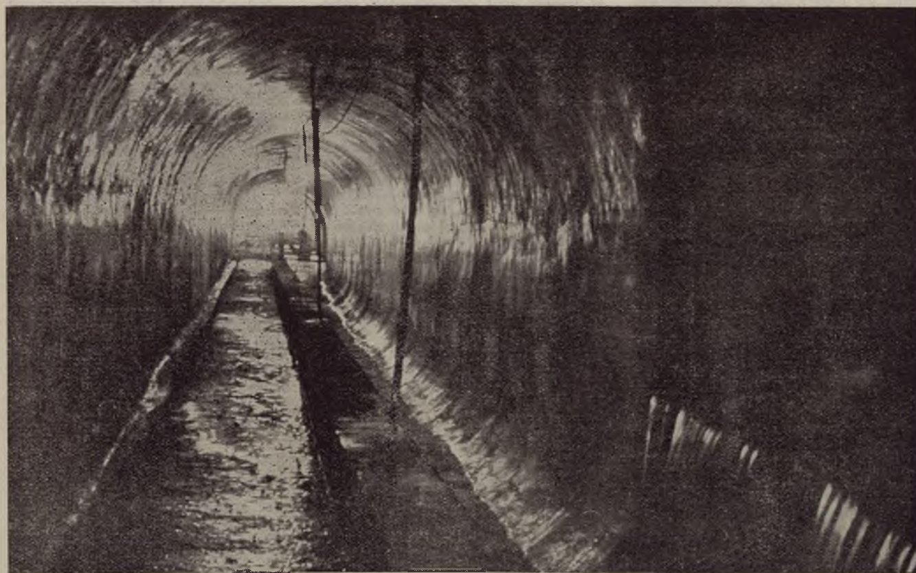
Acquedotto Molisano (ramo di sinistra): galleria di raccolta delle sorgenti
