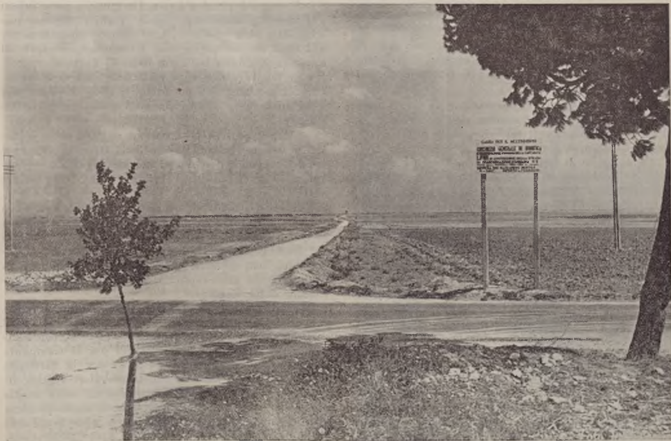
Una nuova strada di trasformazione fondiaria in provincia di Foggia.
