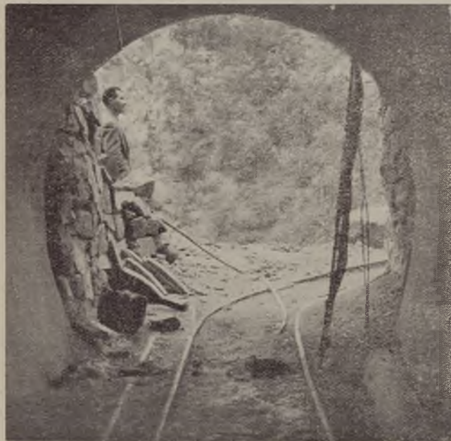
Acquedotto del Lese (Calabria): galleria in località « Difesella »
