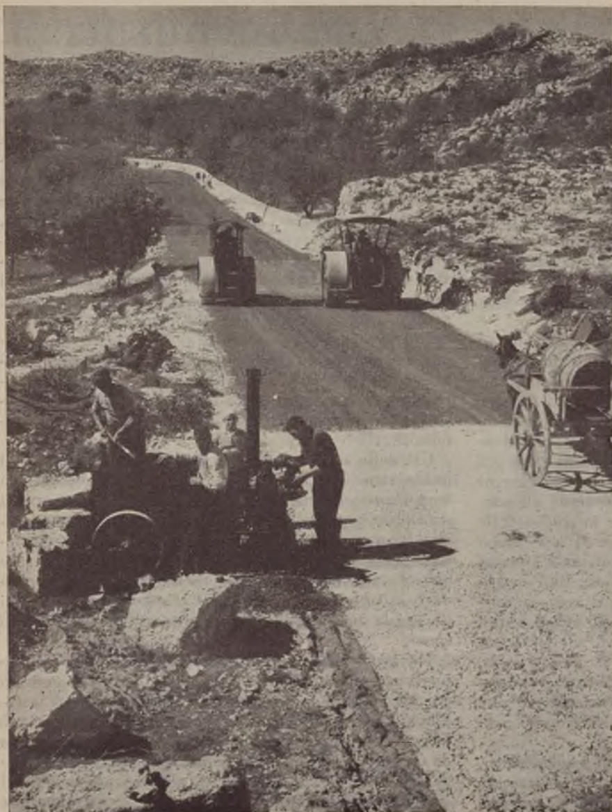
Lavori in corso nella strada Siracusa-Belvedere Caroncino.
