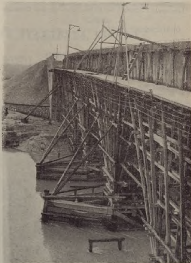
Costruzione del ponte sul Vomano ad Aprati (Teramo).
