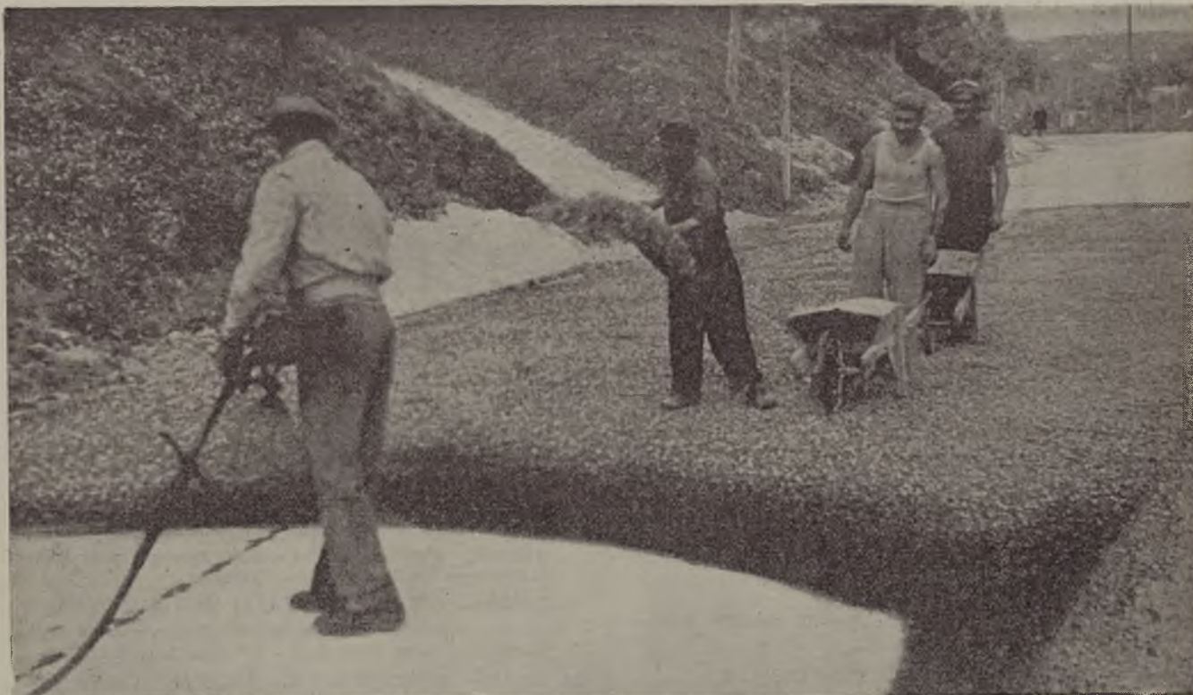
Sistemazione e pavimentazione di strada provinciale a Teramo. Trattamento di prima applicazione.
