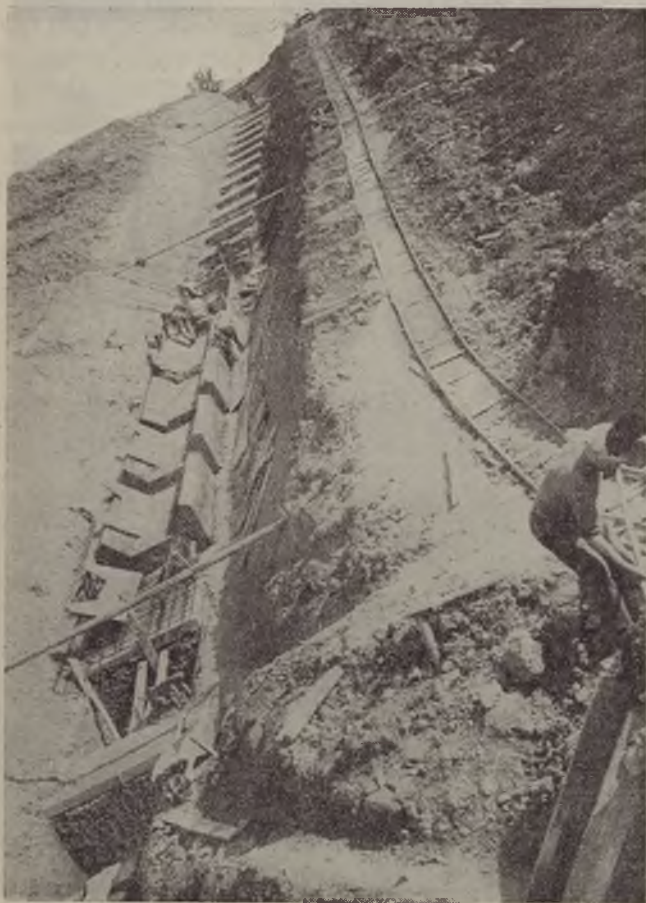
Costruzione di culle di appoggio dei tubi per opere d'irrigazione in Abruzzo.
