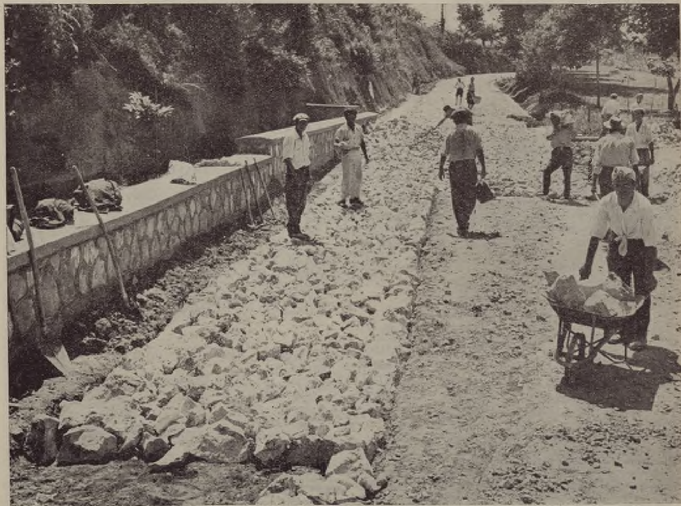
Costruzione di strada di bonifica in Campania
