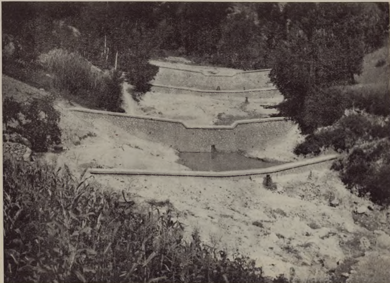
Lavori di sistemazione del bacino montano del Tavo (Pescara)
