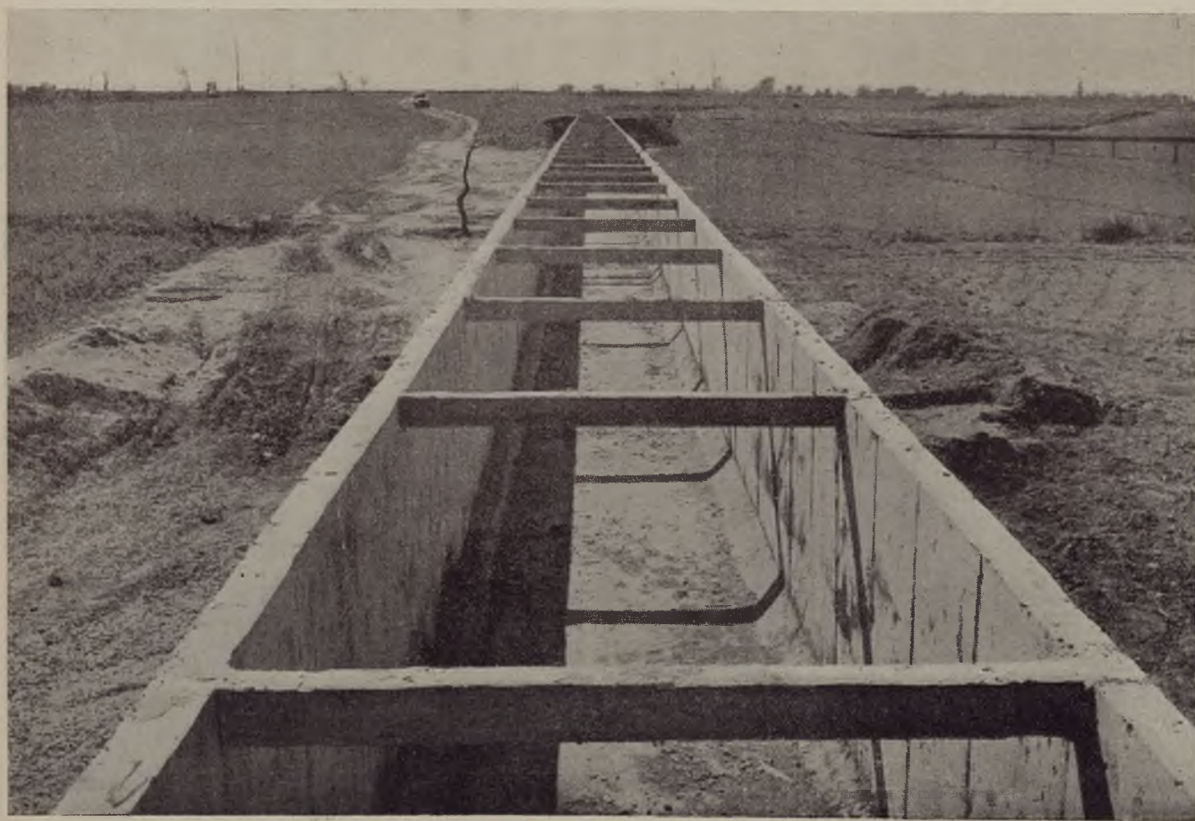
Tratto pensile di canale poli-centrico nel Consorzio Aurunco di Bonifica (foto dall'alto).
