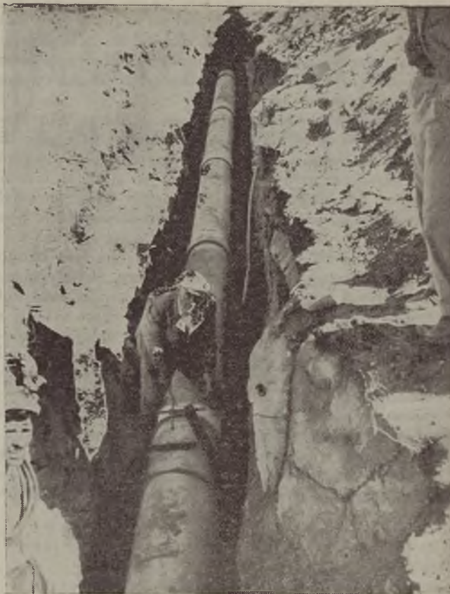
Acquedotto Consorziale di Nuoro: posa di tubazione sul 1° lotto della condotta
