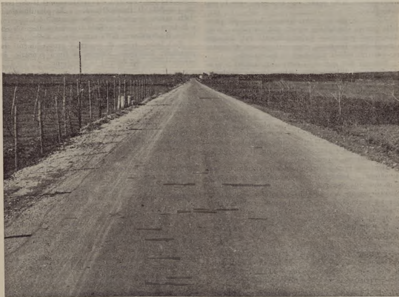
Sistemazione della strada Francavilla verso Sava (Messina).
