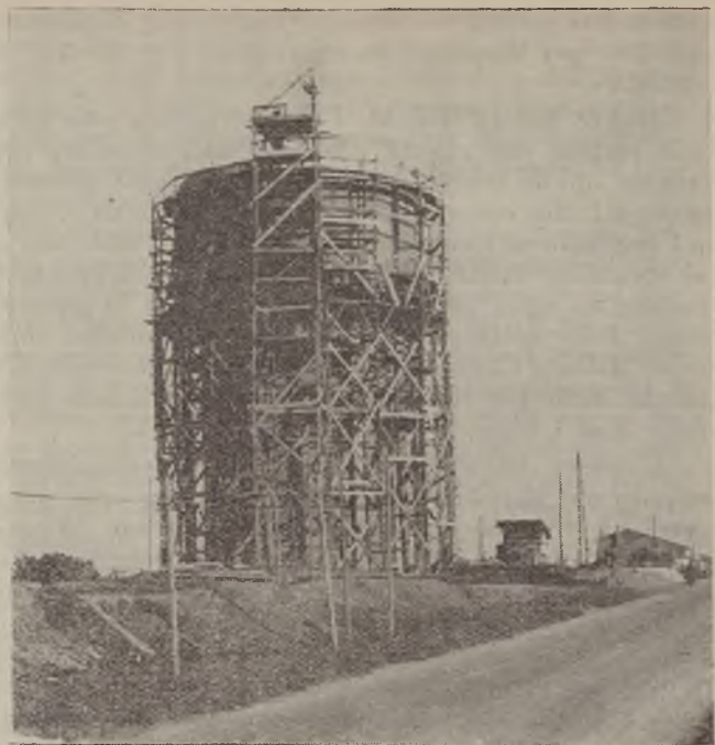
Acquedotto del Tacina (Calabria): serbatoio elevato per Cutro
