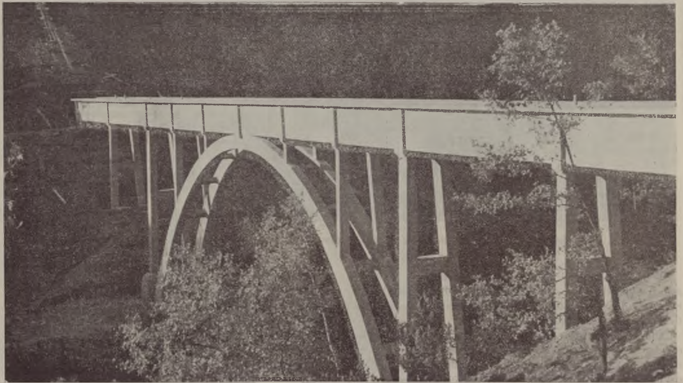
Ponte canale sul fosso «Canale» a cinque luci, nei Consorzi Riuniti di Bonifica di Pescara.
