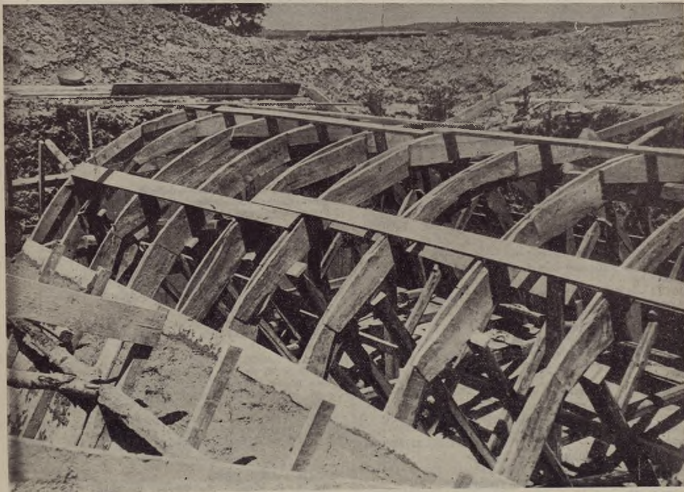
Costruzione del serbatoio di S. Nicolò a Tardino (Teramo).
