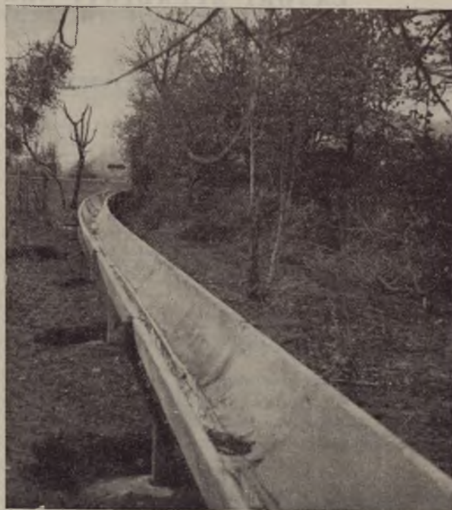
Canaletta d'irrigazione nel Comprensorio Aurunco.
