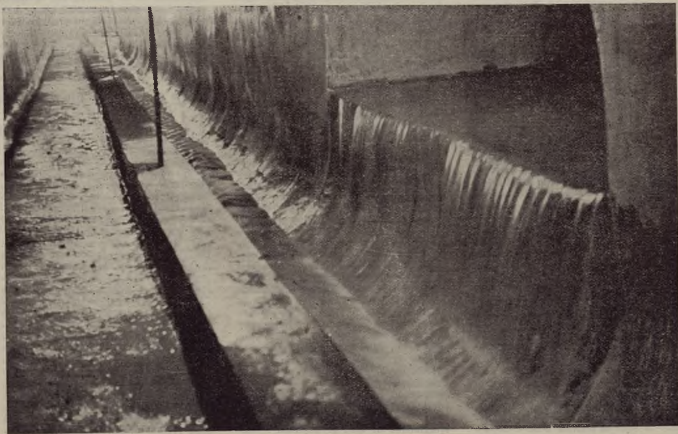
Galleria di raccolta delle sorgenti di Sant'Onofrio (Catanzaro)
