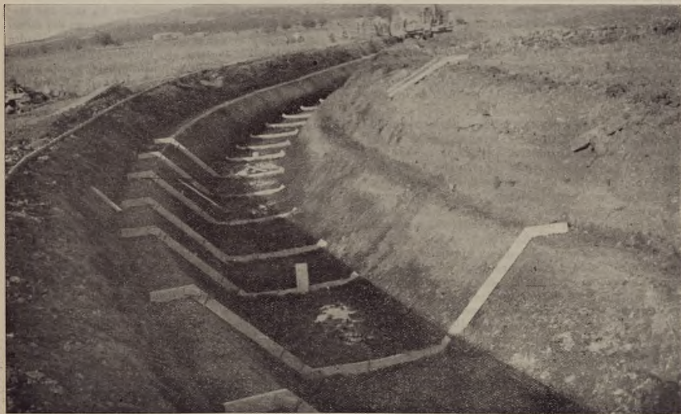
Consorzio di bonifica del nuorese: lavori di sistemazione idraulico-valliva nella piana di Posada
