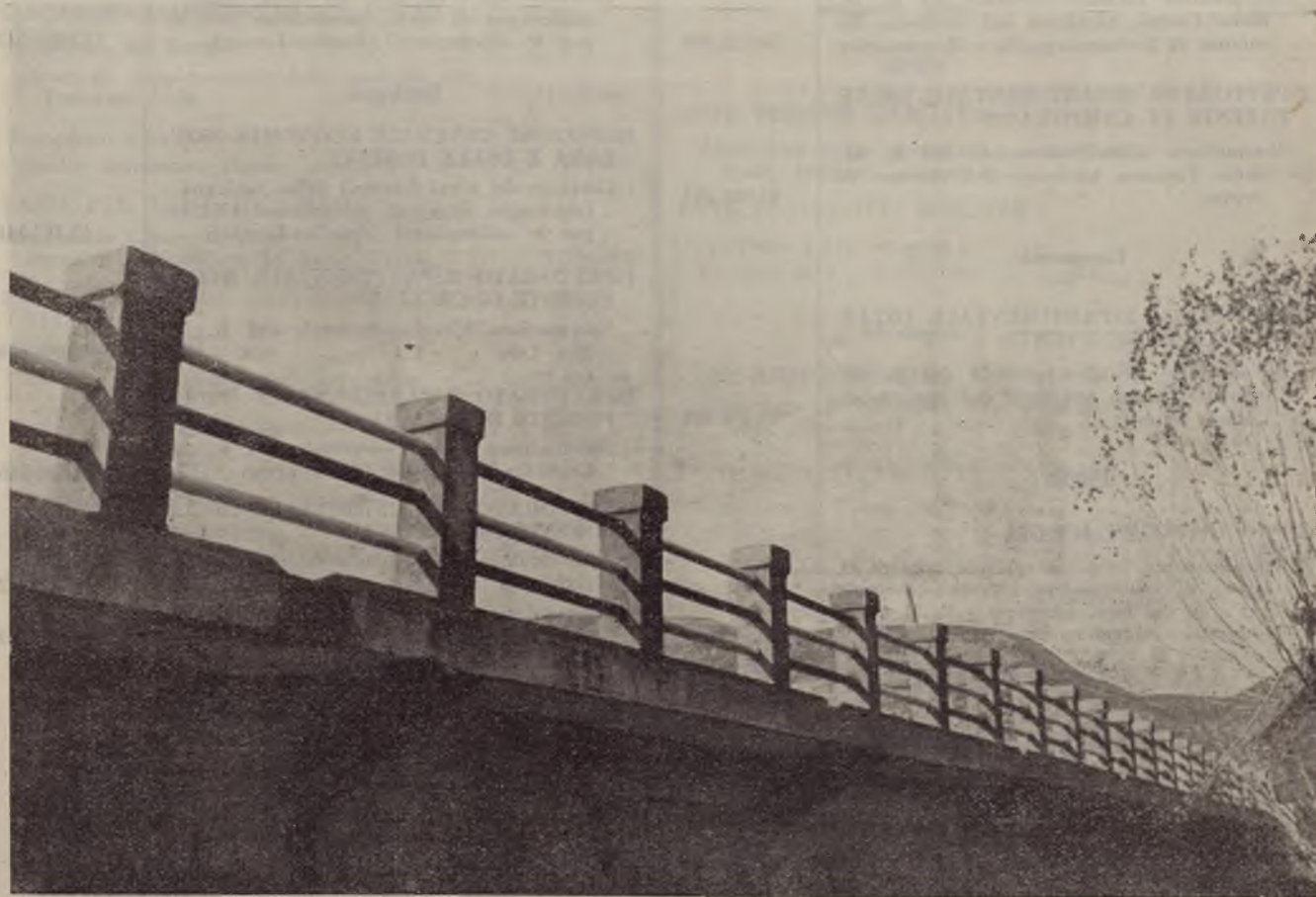
Opere di sistemazione generale della strada provinciale Picente (L'Aquila).
