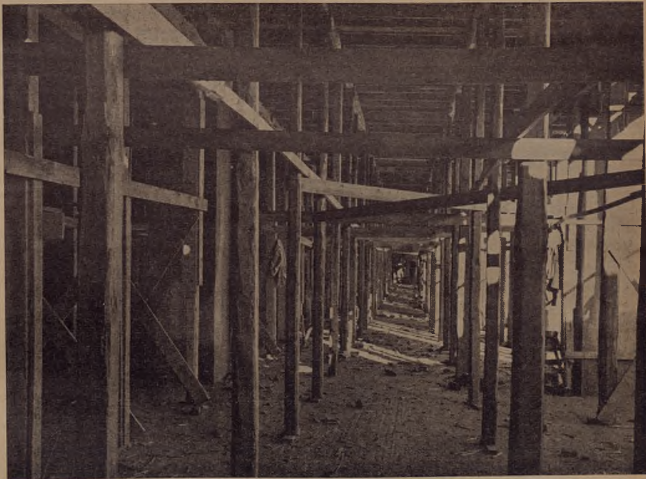
Lavori di ampliamento del serbatoio di Brindisi : Particolare dell'armatura lignea di sostegno per il solaio di copertura della vasca.
