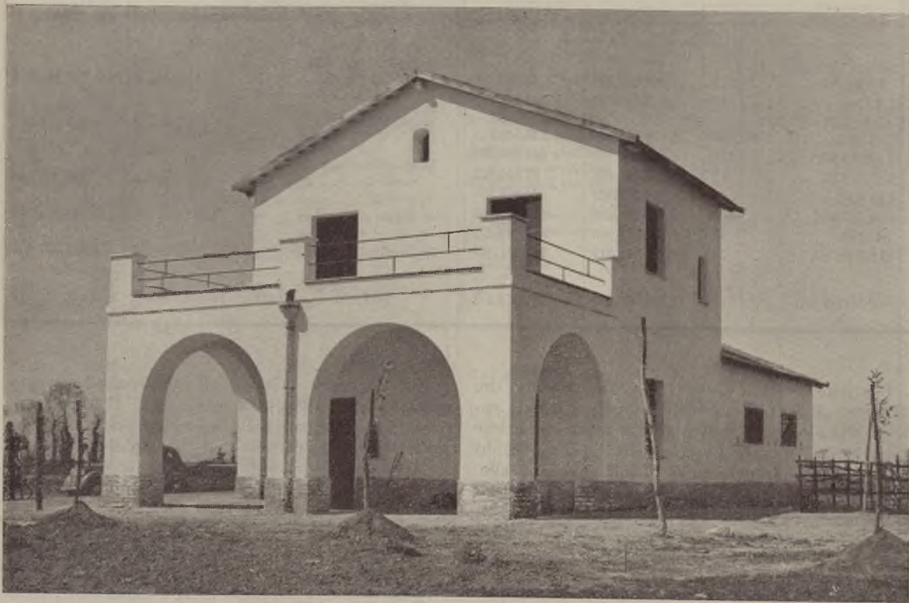
Consorzio Aurunco di bonifica: fabbricato colonico con annessa stalla
