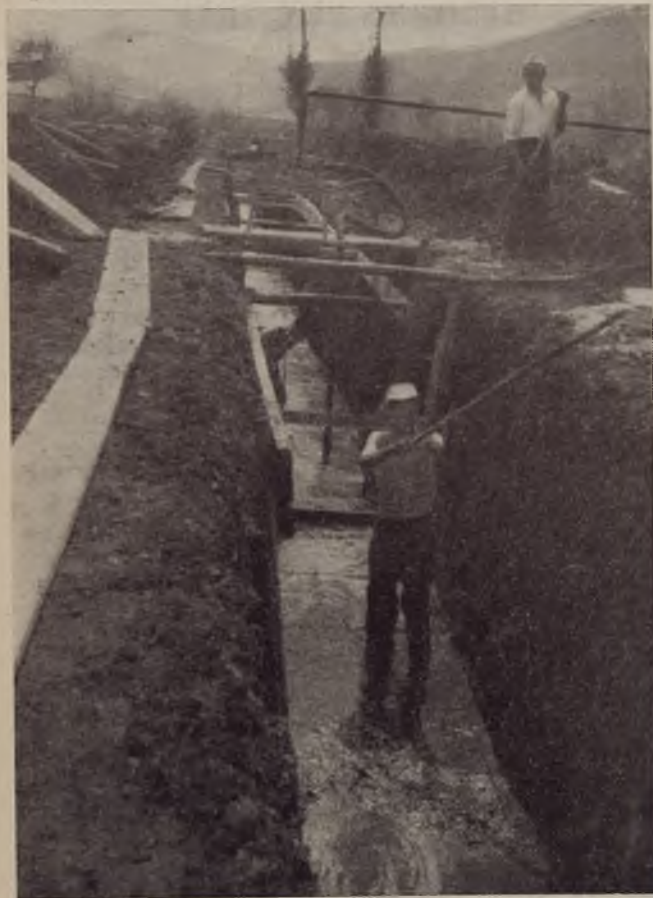
Collettore principale. - Esecuzione del cavo.
