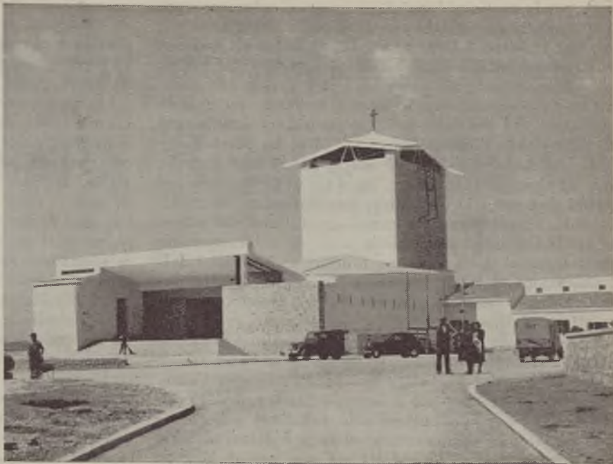
L'elegante linea architettonica della chiesa al centro del villaggio « La Martella ».
