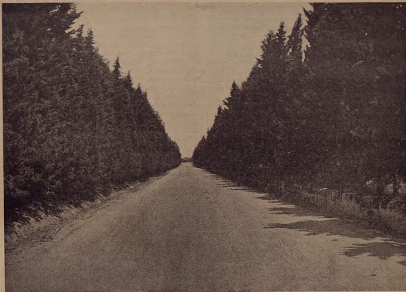
Amm.ne Prov.le di Lecce. - Strada Cavallino S. Cesario : Allargamento e depolverizzazione con pavimentazione in conglomerato bituminoso.
