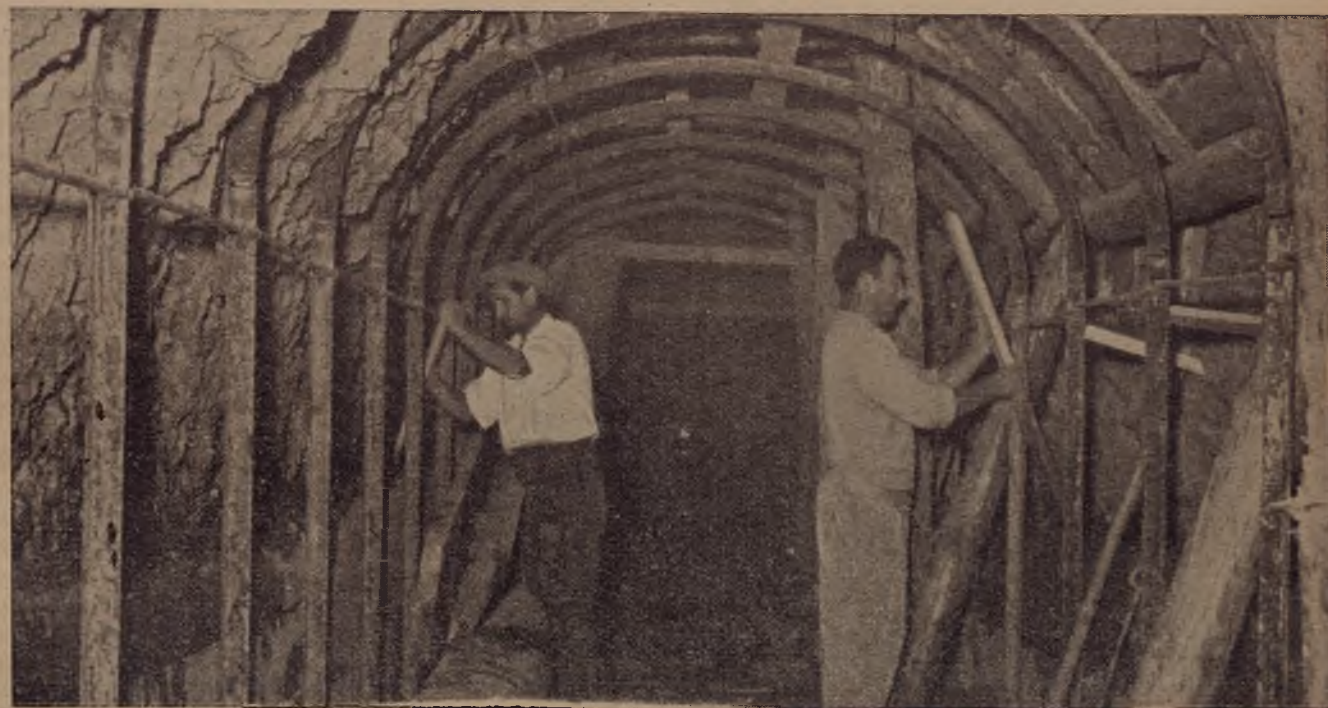
Galleria di eduazione delle acque del Giardino per l'acquedotto « Val di Pescara ». — Esecuzione del rivestimento in calcestruzzo.
