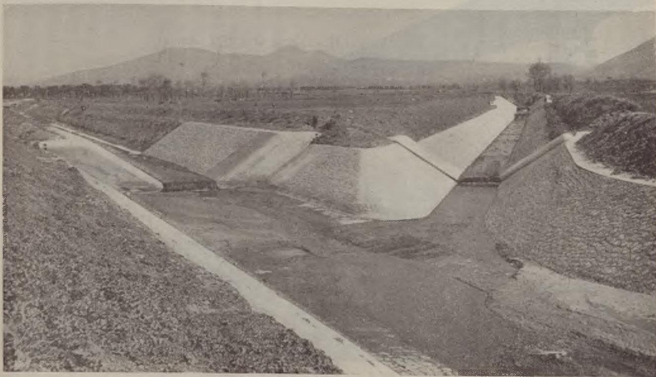
Nuova inalveazione del rivolo d'Auria; manufatto di confluenza col rio Grotta.
