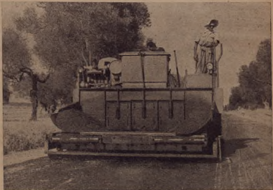
LECCE. - Strada Galatone-Galatina dell'Amministrazione Provinciale. Finitrice «Vogele» in funzione per la stesa del conglomerato bituminoso.
