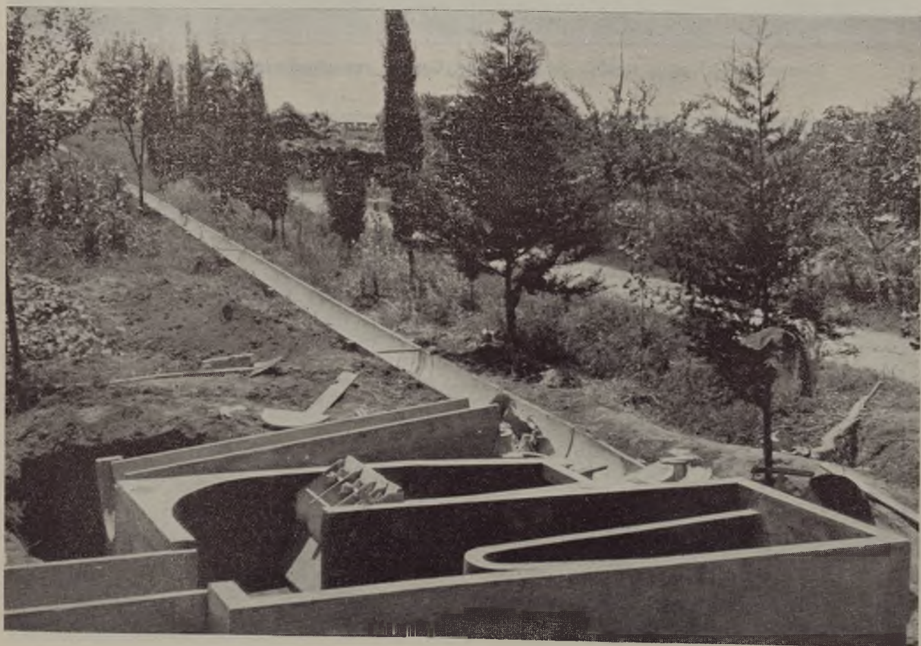
Opere per l'irrigazione (derivazione con sfioratore) nel Consorzio Aurunco di Bonifica
