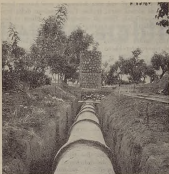
Consorzio di bonifica Piana di Fondi e M. S. Biagio: canale di irrigazione con tubi vianini e pozzetto piezometrico.
