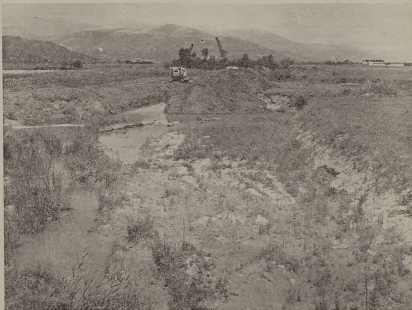
Sistemazione idraulica del torrente Ausente (Caserta)
