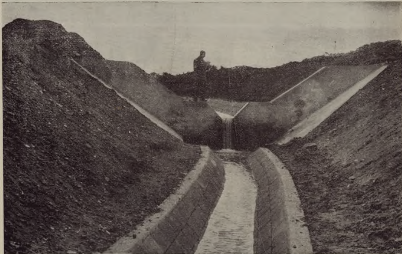
Lavori di completamento della sistemazione delle Marane Pidocchiosa e Ponticello
