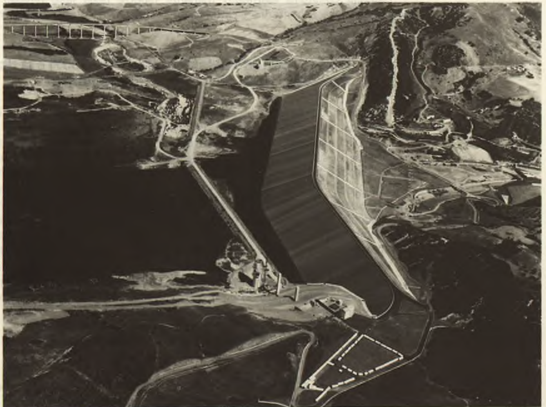
Figura 2 - Diga in costruzione sul fiume Sinni a Monte Cotugno (Potenza)
