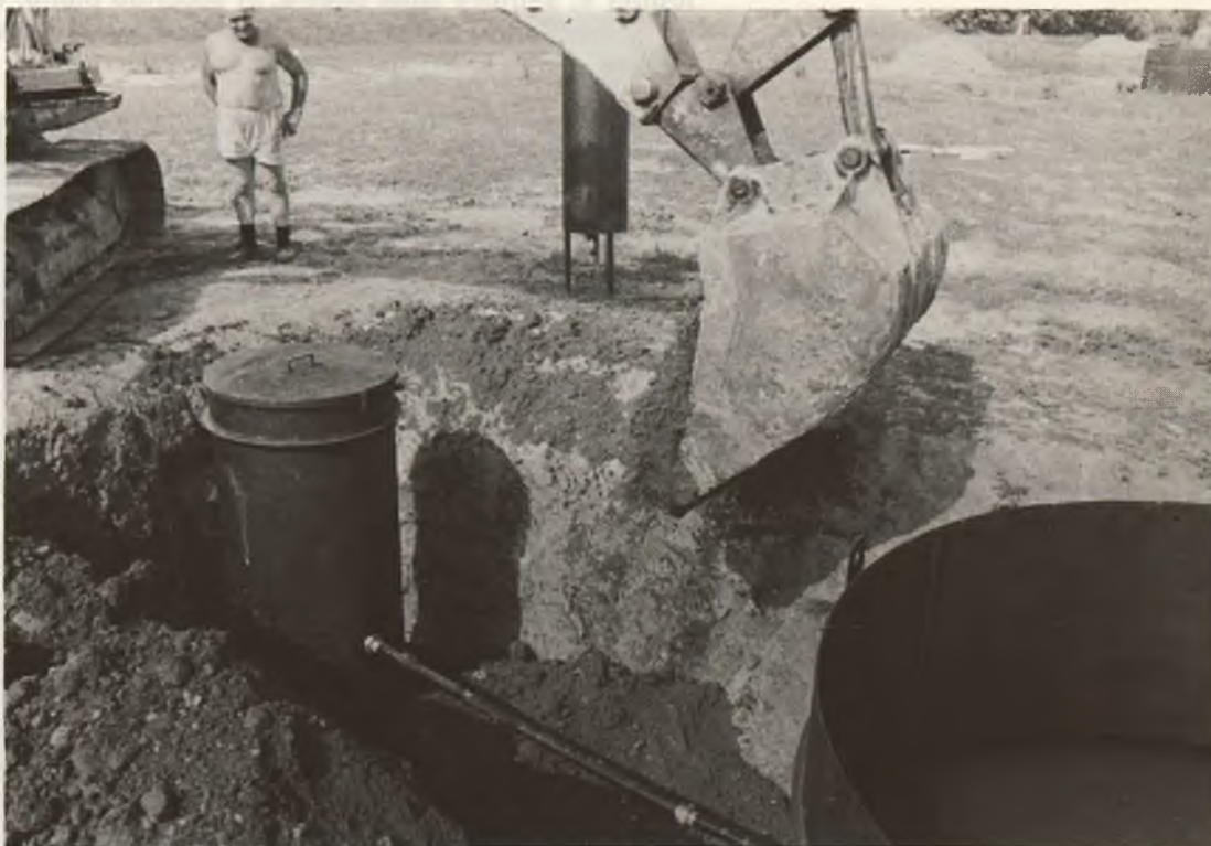
Figura 13 - Lisimetro SMIP in corso di installazione
