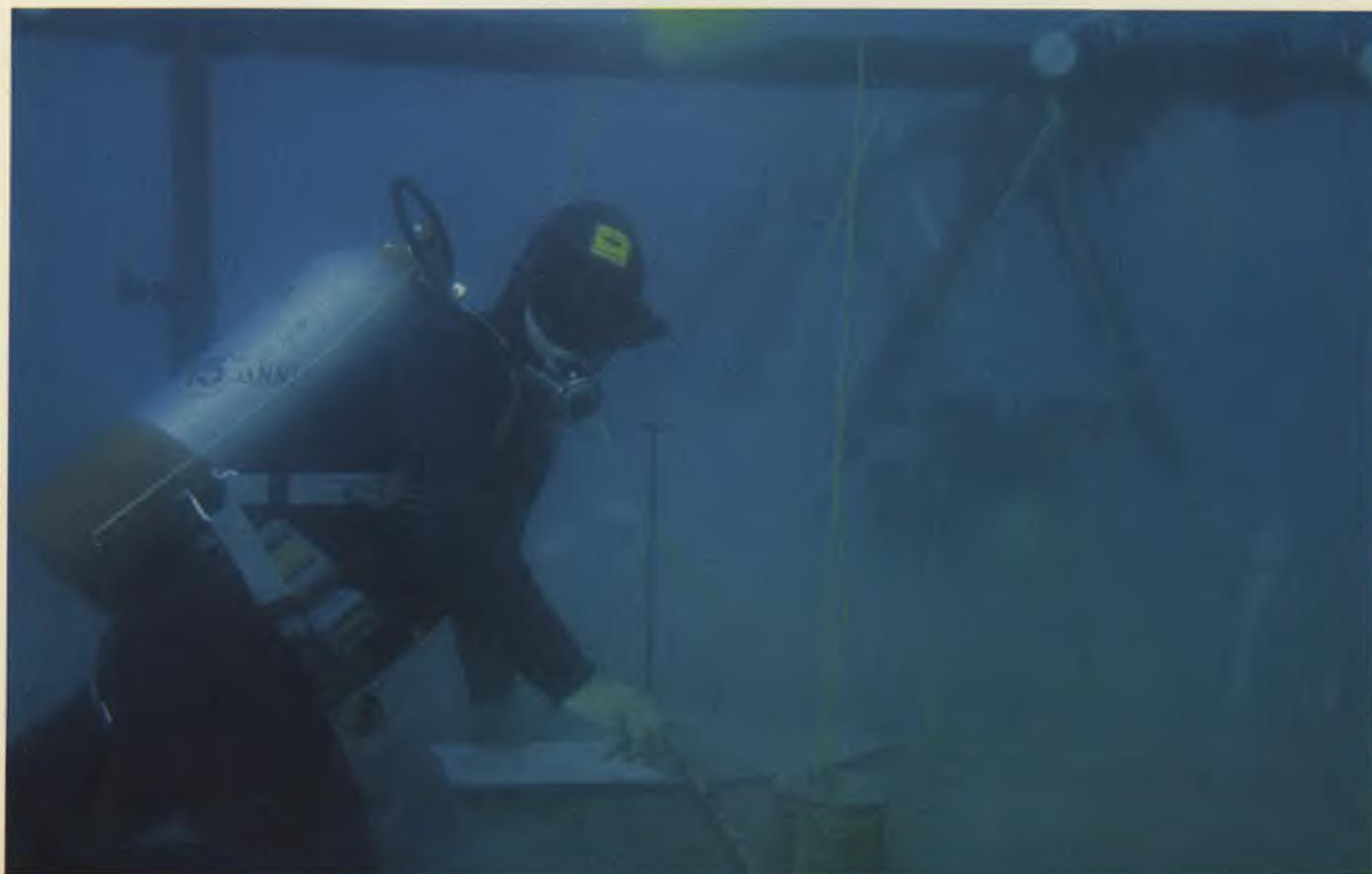
Figura 19 - Rilevamento delle dimensioni del getto
