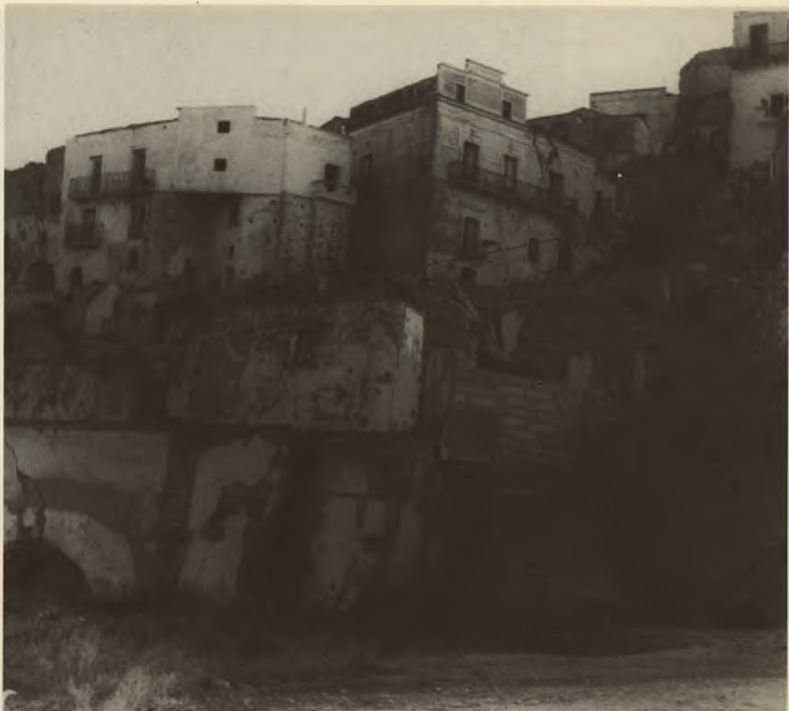
Foto 3 Evidenti manifestazioni di dissesto dell'abitato di Craco.
