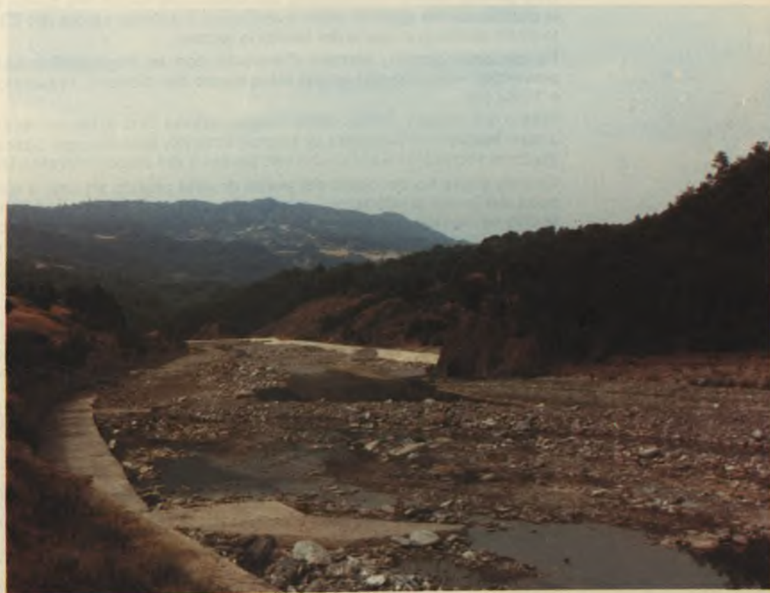
Foto 10 Difese di sponda lungo il fiume Sinni.
