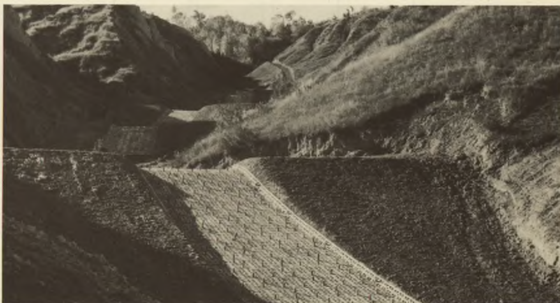
Foto 43 Sistemazione idraulica con briglie in terra con sezioni di deflusso rivestite in elementi prefabbricati.
