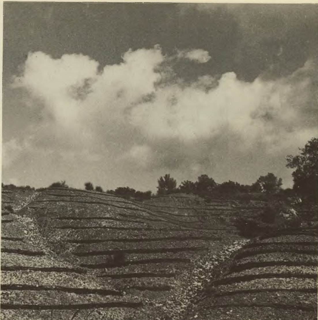
Foto 36 Sistemazione di pendici in dissesto con graticciate e regolazione delle acque di scorrimento superficiale.
