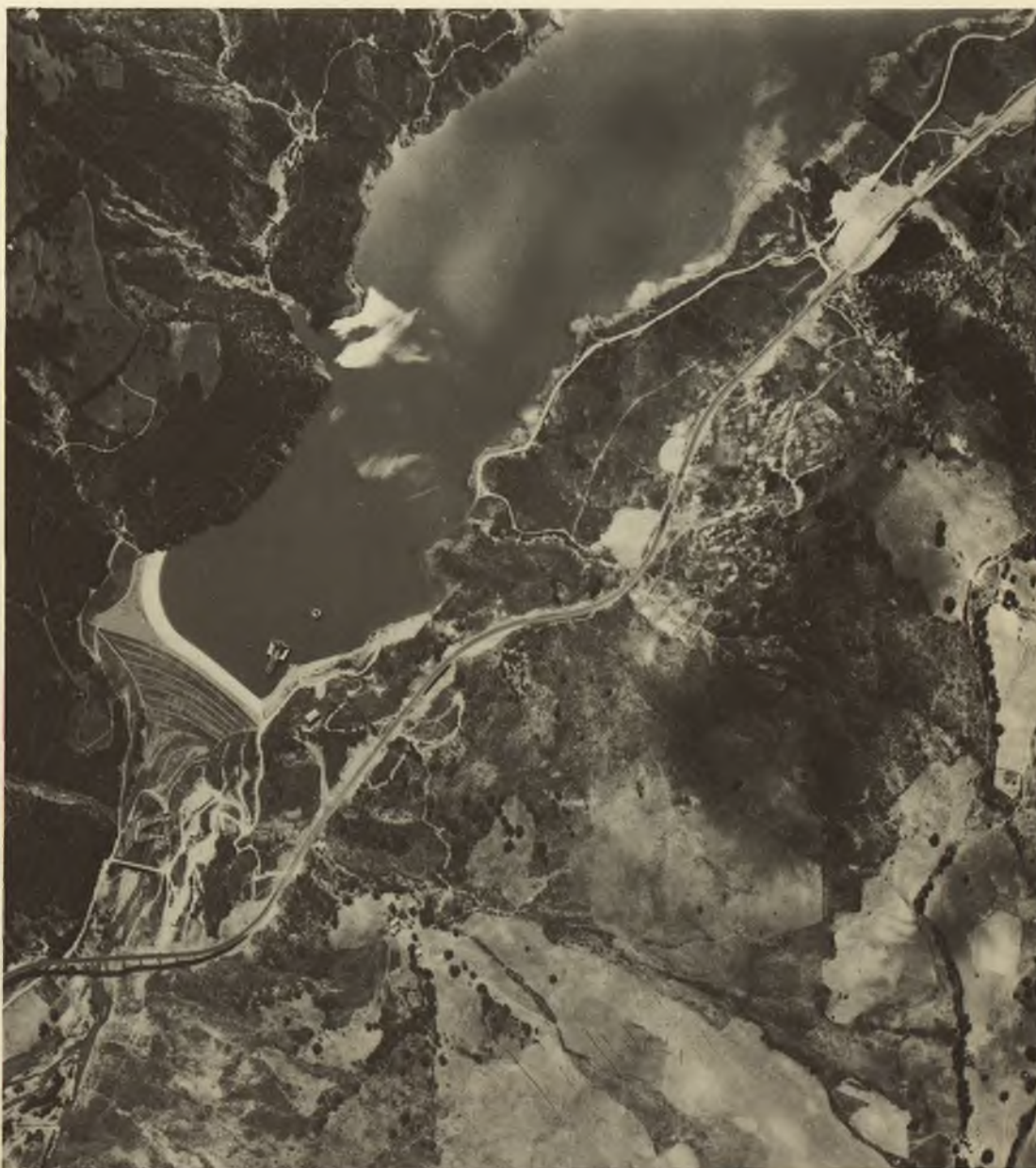
Foto 45 Vista dall'aereo della diga in terra sul torrente Camastra affluente del fiume Basento. Su una capacità utile del serbatoio di 32,15 milioni di metri cubi, per tale opera è prevista una capacità morta di 4,25 milioni di metri cubi, (85.000 mc/anno per 50 anni).
