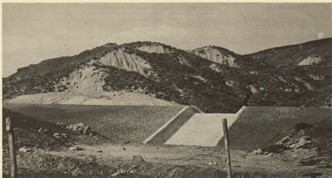
Foto 42 Briglia in terra con sezioni di deflusso rivestite in conglomerato cementizio gettato in opera.
