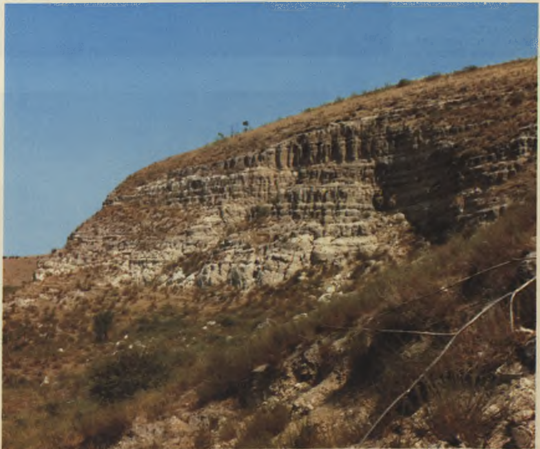
Foto 29 Tavoletta Stazione Venosa-Maschito. Gradino morfologico, in formazione arenaceo- conglomeratico- tufacea, soggetto ad erosione e frane di crollo.
