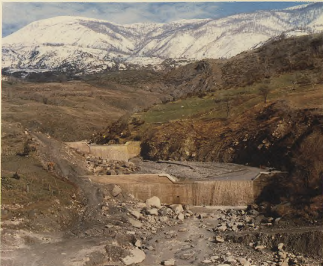
Foto 32 Sistemazione idraulica di un torrente in fase di scavo realizzata con briglie a diaframma in calcestruzzo.
