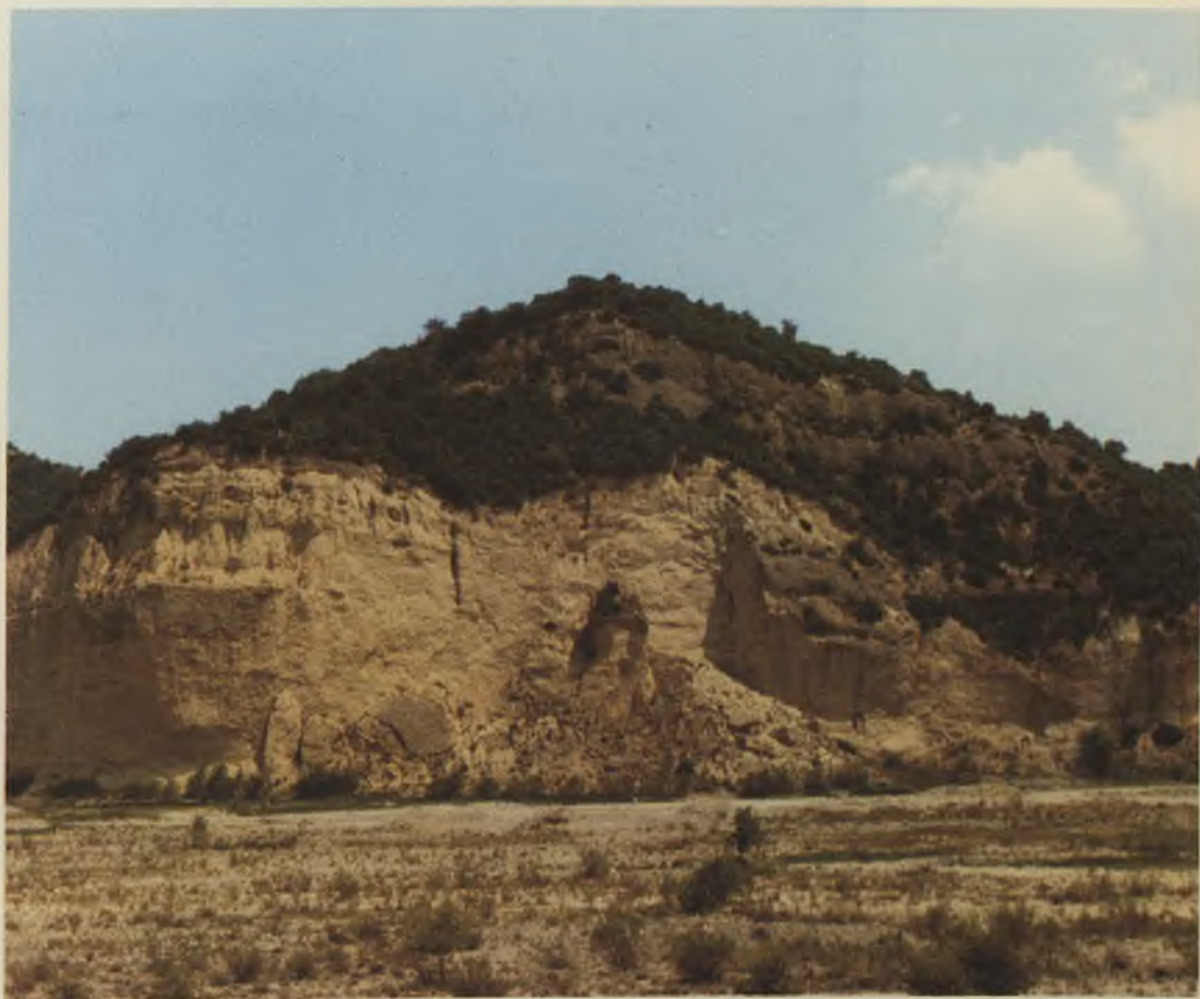
Foto 24 Torrente Sauro. Frane riportabili al tipo «crolli e/o ribaltamenti».
