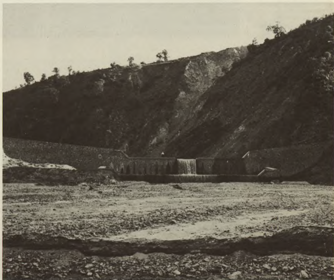
Foto 39 Briglia in pietrame e malta cementizia con vasca di dissipazione.
