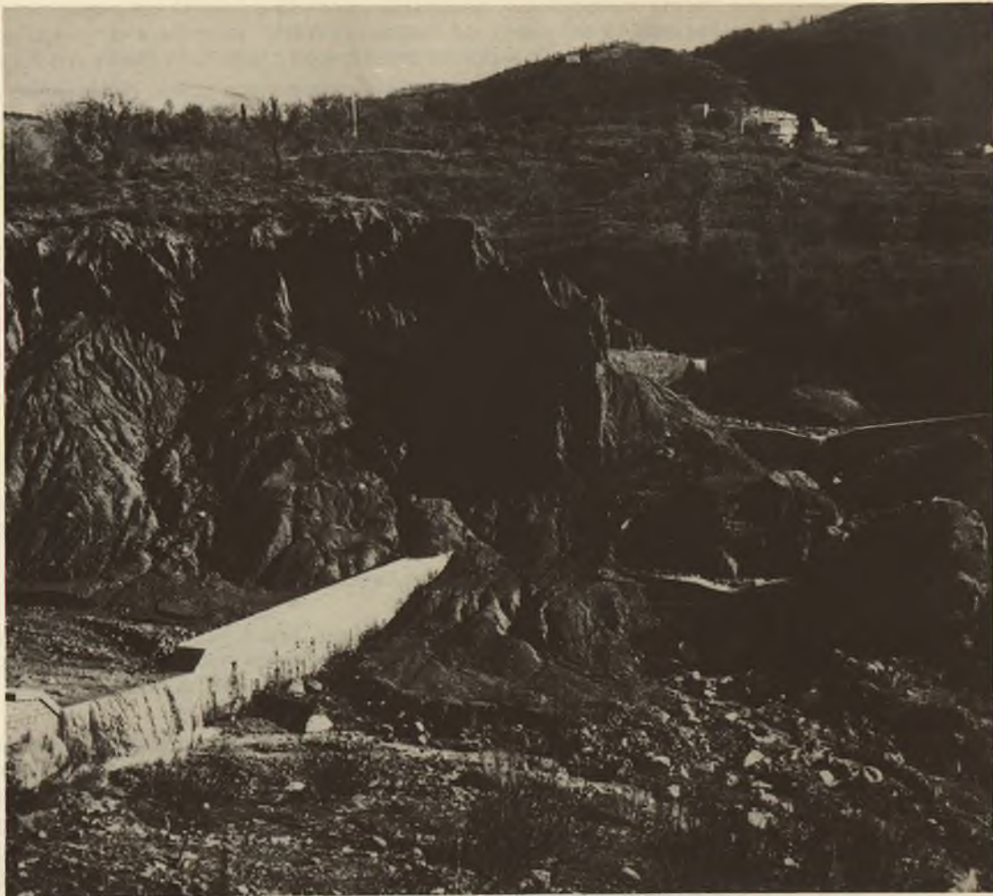
Foto 9 Bacino del Noce. Briglia in c.c. realizzata per arrestare l'azione di scavo operata dalle acque incanalate.
