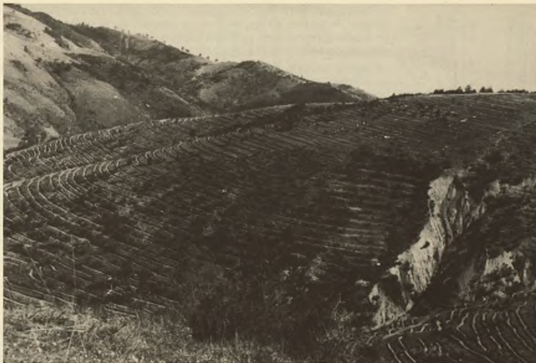
Foto 34 Pendici in erosione interessate da lavori di rimboschimento.
