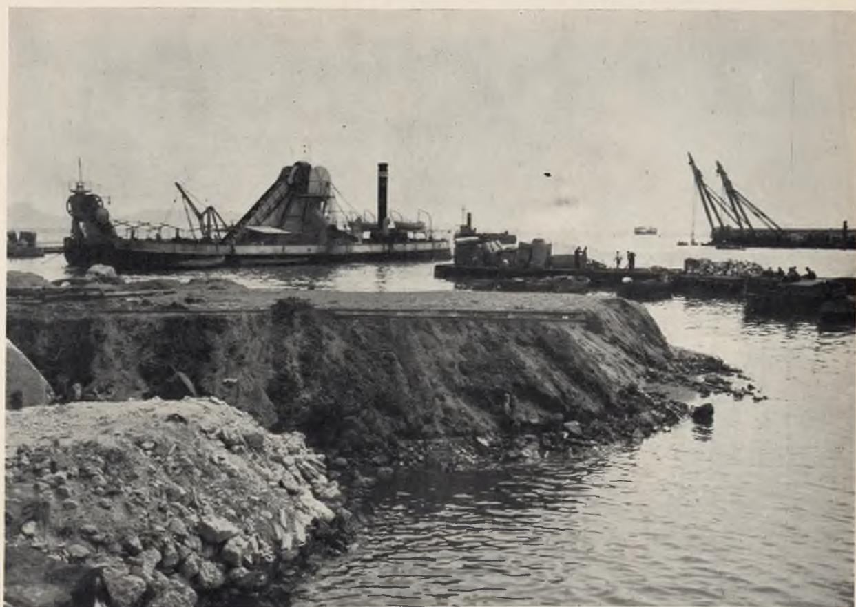
Foto 3 - La draga Parodi del Servizio escavazione porti del Ministero dei LL. PP., impiegata nei lavori di scavo per l'attraversamento del passo di Procida.
