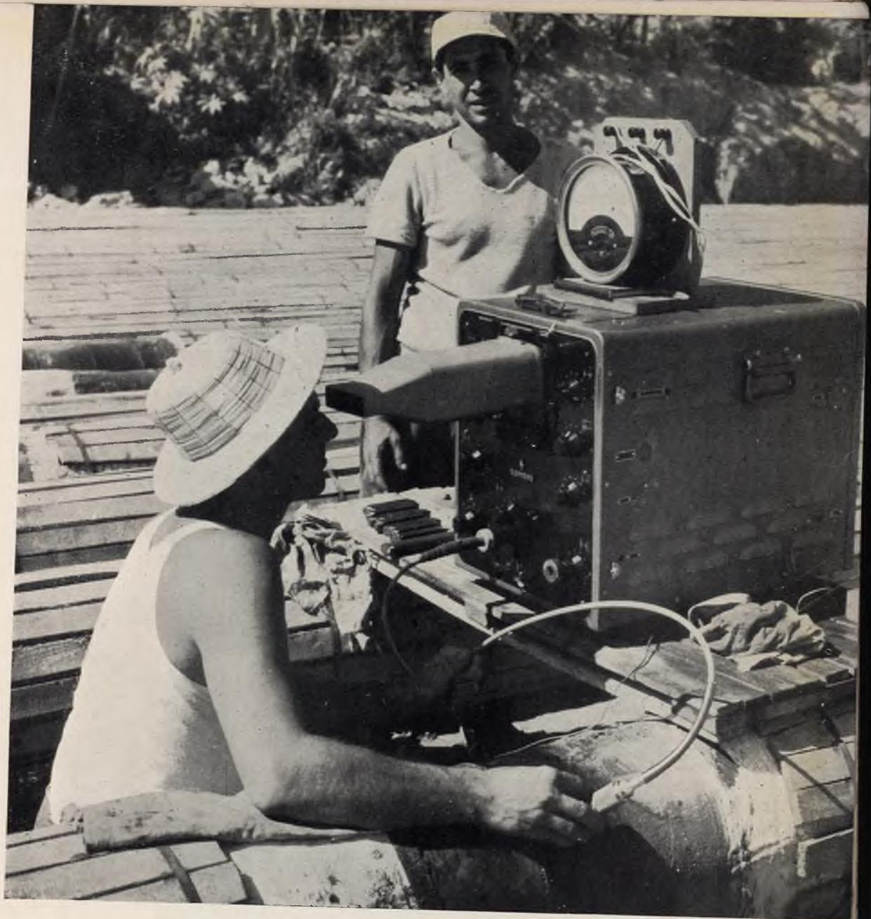
Foto 6 - Controllo di una saldatura con dispositivo ad ultrasuoni.
