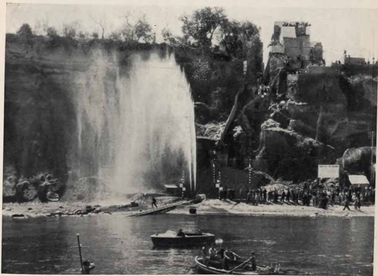
Foto 12 - Due getti d'acqua zampillano sulla spiaggia di Procida dalla estremità delle due condotte sottomarine collegate al serbatoio di Bacoli.
