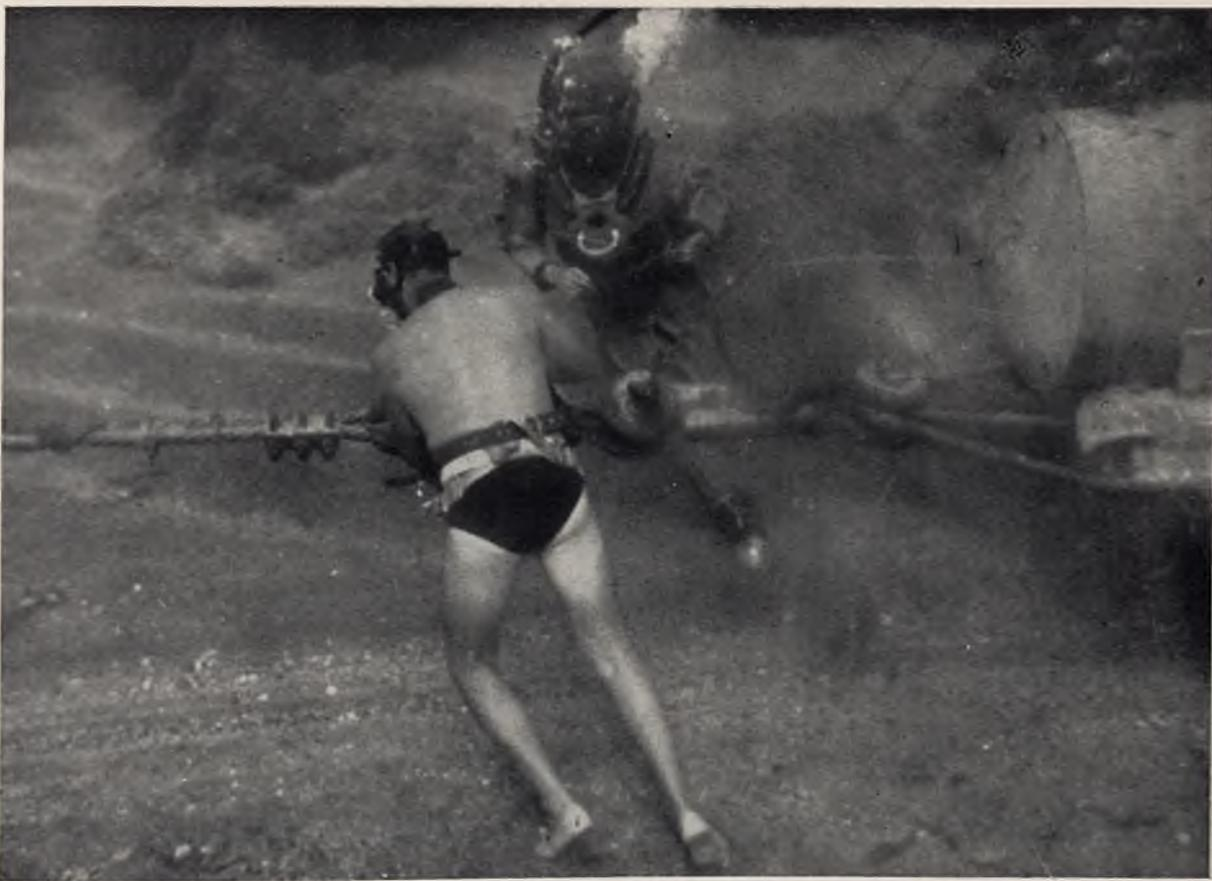
Foto 19 - Palombari e sommozzatori controllano l'avanzamento della testa di tiro entro la trincea nel fondo marino.
