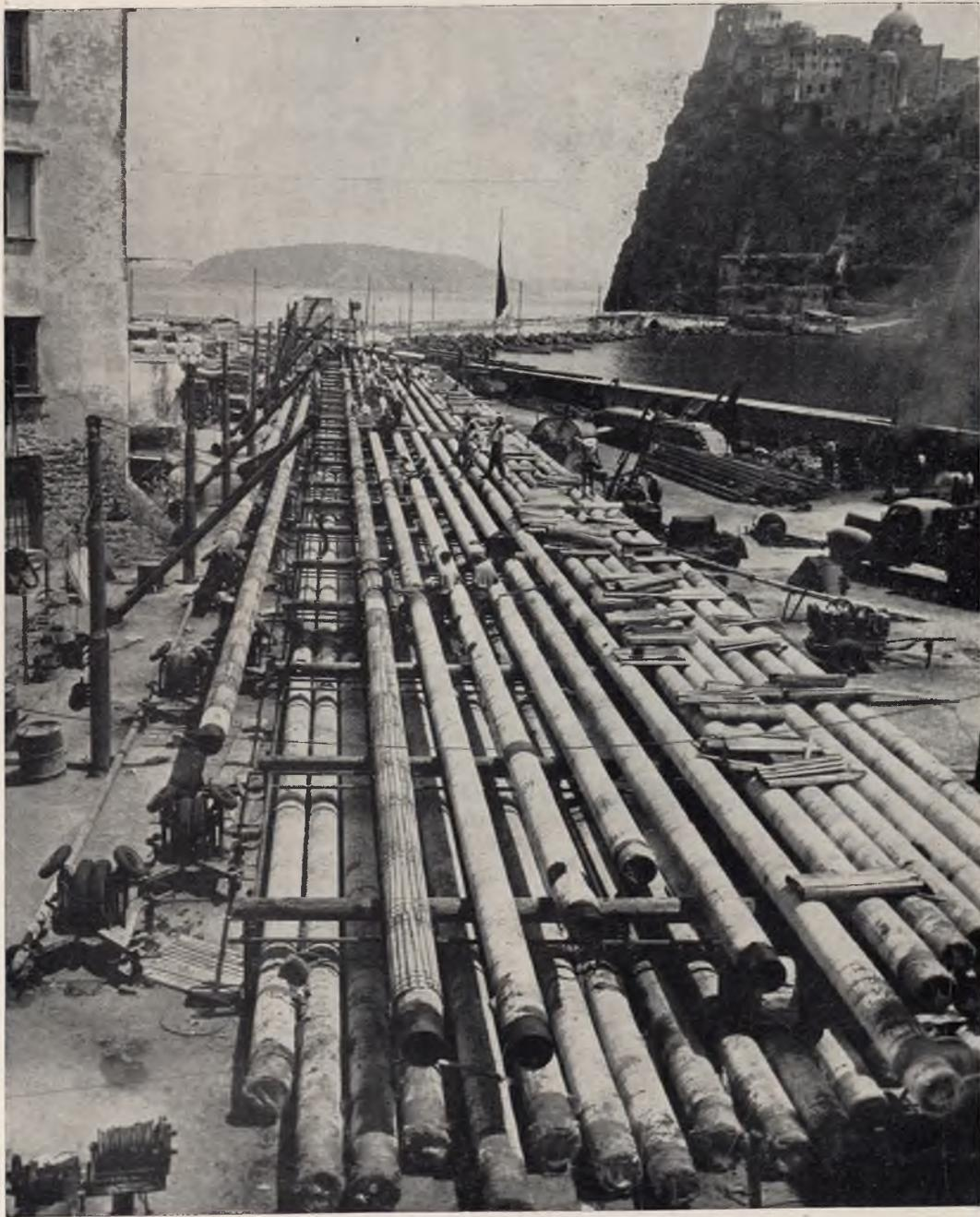
Foto 13 - Cantiere di Ischia Ponte. Condotte pronte per il varo.
