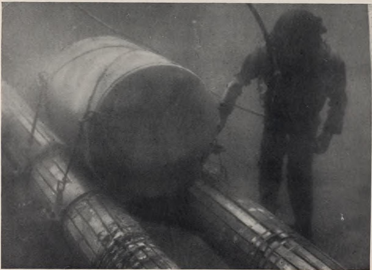
Foto 18 - Un palombaro ispeziona l'attacco di un cilindro di alleggerimento.
